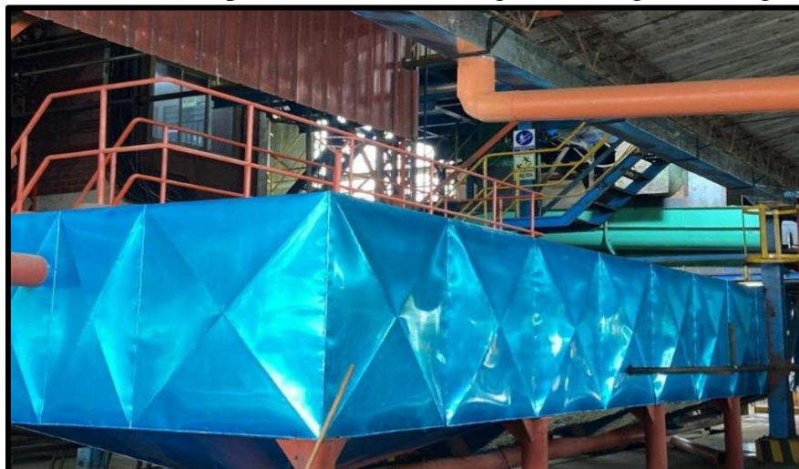
Figura 34: Preclarificador de 40 m 3 culminado. Fuente: Olamsa.
