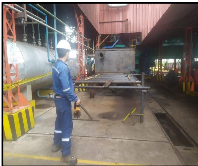
Figura 30: Primera etapa de la implementación del preclarificador de 40 m 3 Fuente: Olamsa
