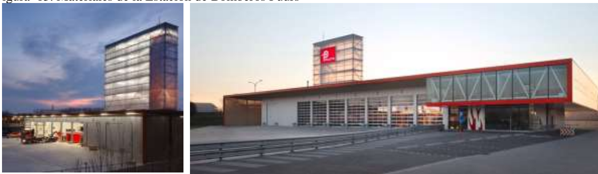
Figura 15. Materiales de la Estación de Bomberos Puurs
