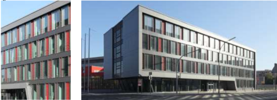
Figura 17. Materiales de la Estación de Bomberos 1
