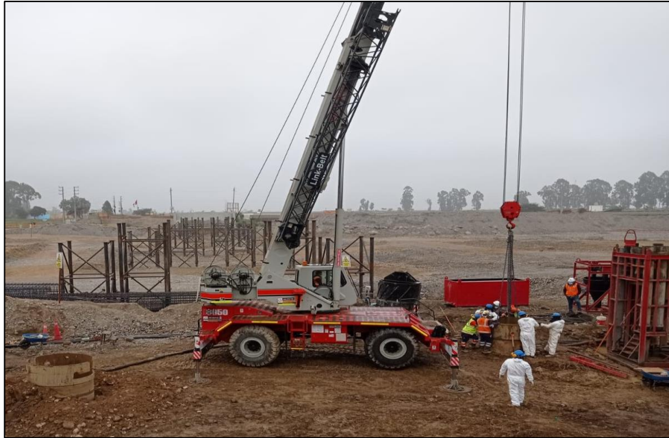
Figura N 20. Trabajos de pilotaje Fuente: Elaboración Propia
