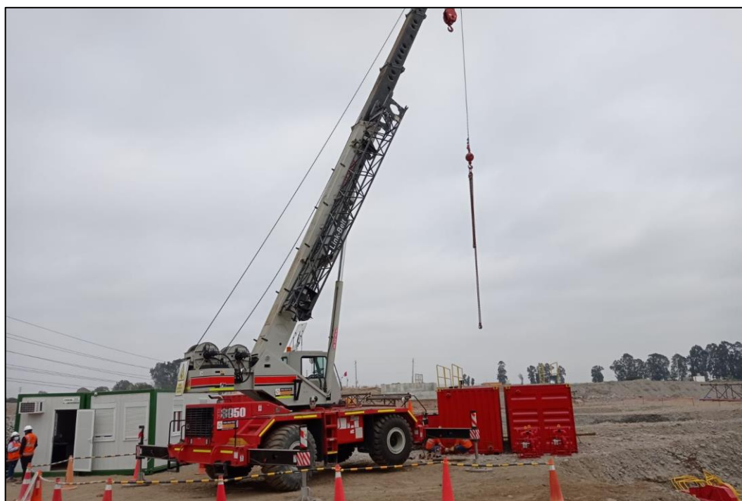
Figura N 19. Movilización y desmovilización de equipo de pilotaje
