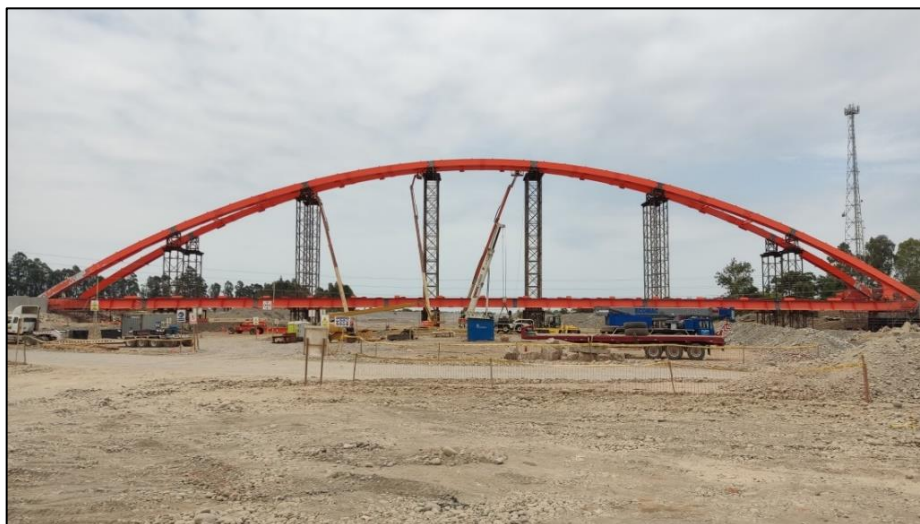
Figura N 17. Montaje de la estructura metálica
