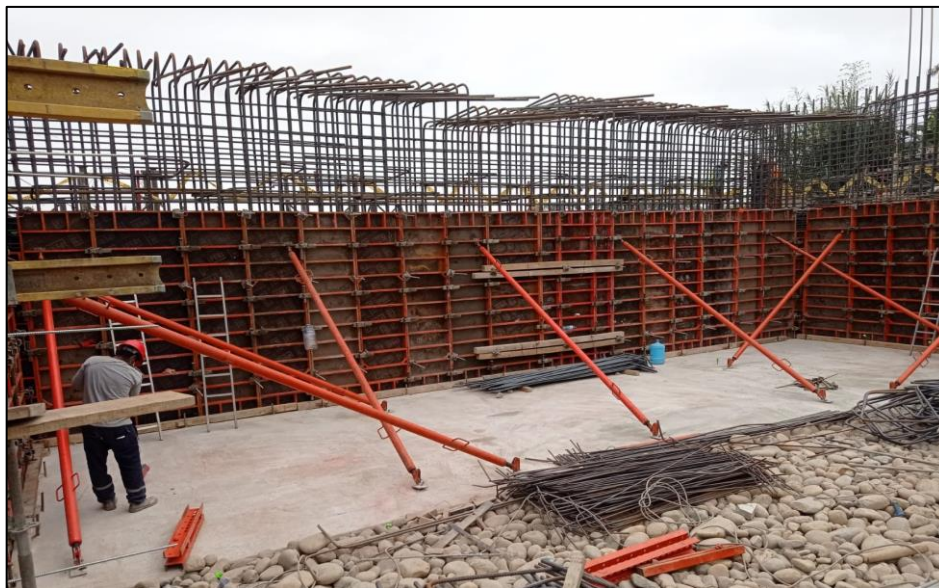
Figura N 21. Encofrado del estribo Fuente: Elaboración Propia
