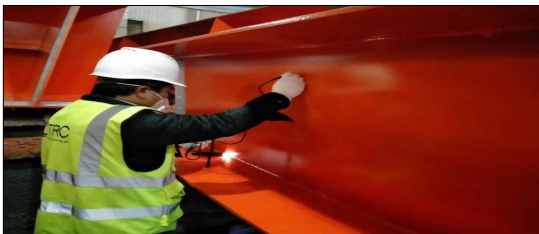
Figura N 16. Pintura de la estructura metálica
