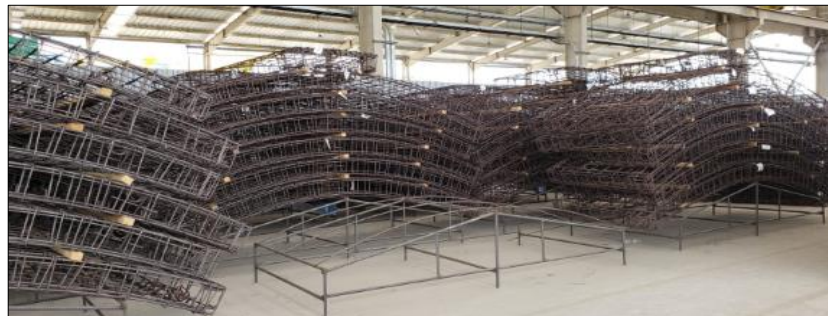
Figura N° 58: Armado de dovelas de concreto. Fuente: Elaboración propia (2022).
