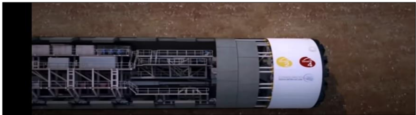
Figura N° 60: Tuneladora instalando dovelas de concreto. Fuente: Andina agencia peruana de noticias (2022).
