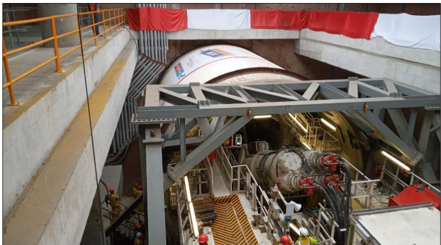
Figura N° 56: Armado de tuneladora. Fuente: Elaboración propia (2022).
