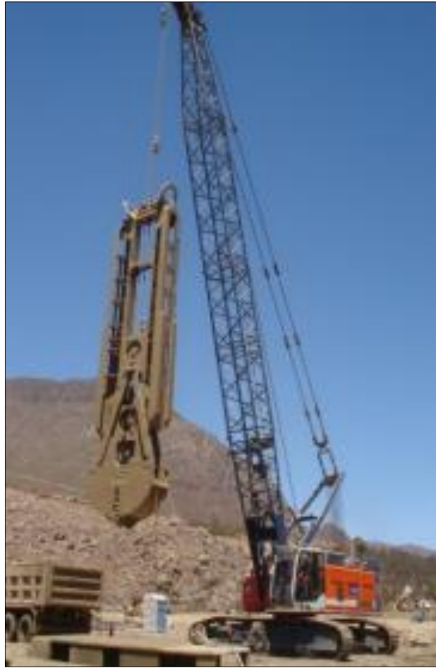
Figura N° 62: Excavación con cuchara. Fuente: Pilotes Terrates (2020).
