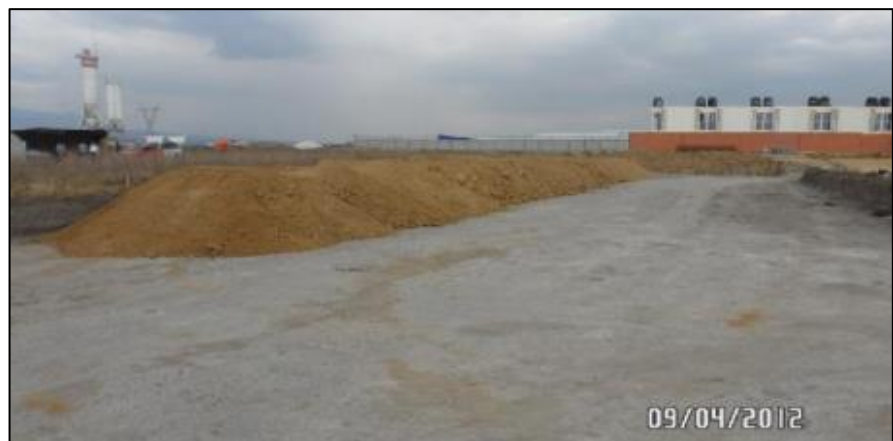
Figura N° 15: Material de sustitución proveniente de un banco. Fuente: Tomada por Doroteo Cid, 2012.
