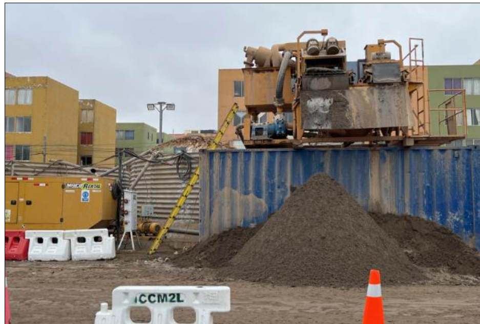
Figura N° 65: Proceso de desarenado de lodo bentonítico. Fuente: Elaboración Propia (2022).
