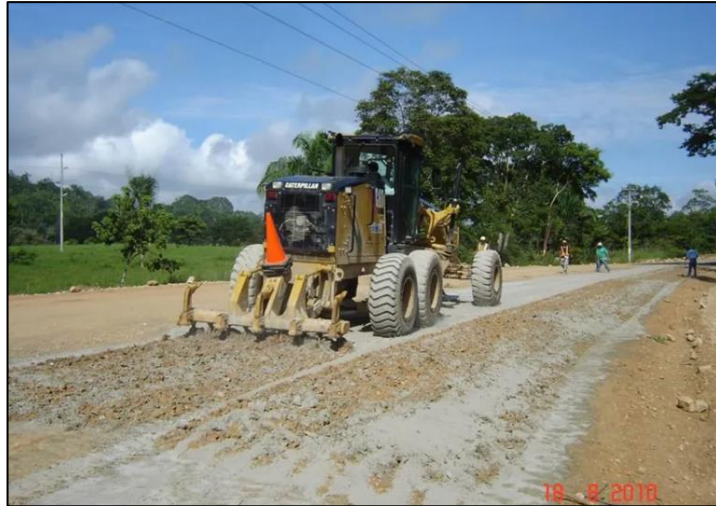
Figura N° 20: Estabilización de suelos con cemento. Fuente: Tomada por 360 En Concreto, 2010.
