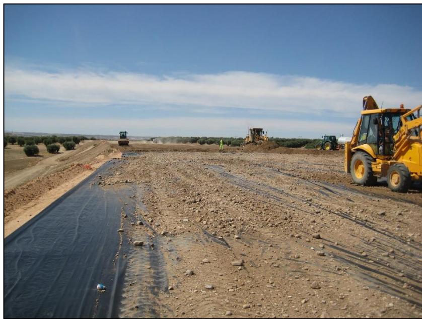
Figura N° 24: Mejoramiento de suelos con geotextil. Fuente: Tomada por Geotextan.
