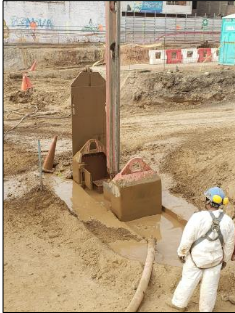
Figura N° 45: Perforaciones de muros pantalla. Fuente: Elaboración Propia (2020).
