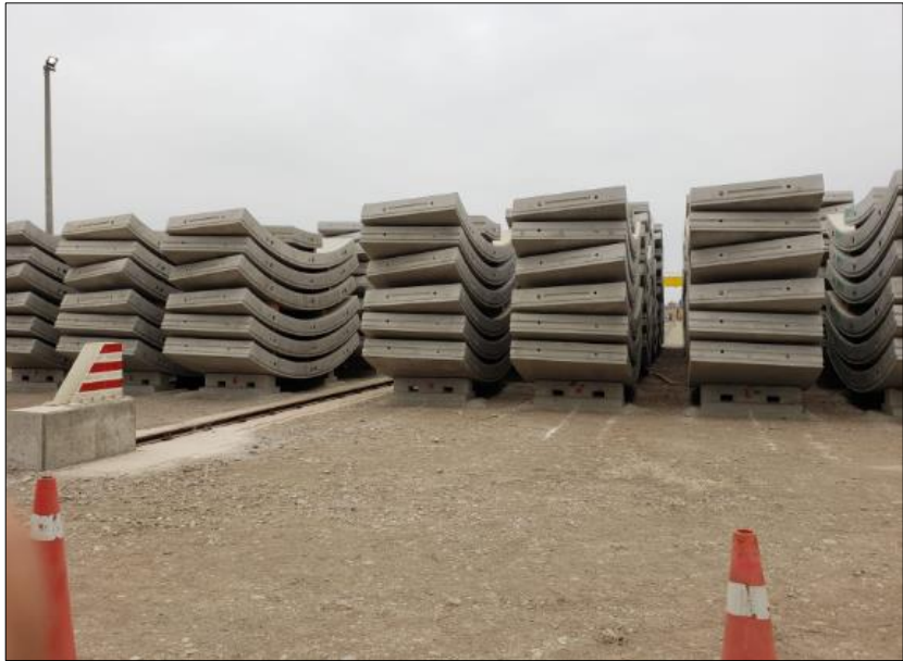
Figura N° 59: Dovelas de concreto prefabricadas. Fuente: Elaboración propia (2022).
