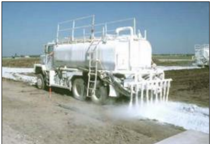
Figura N° 18: Aplicación de lechada de cal. Fuente: Tomada por Nacional Lime Association, 2004.
