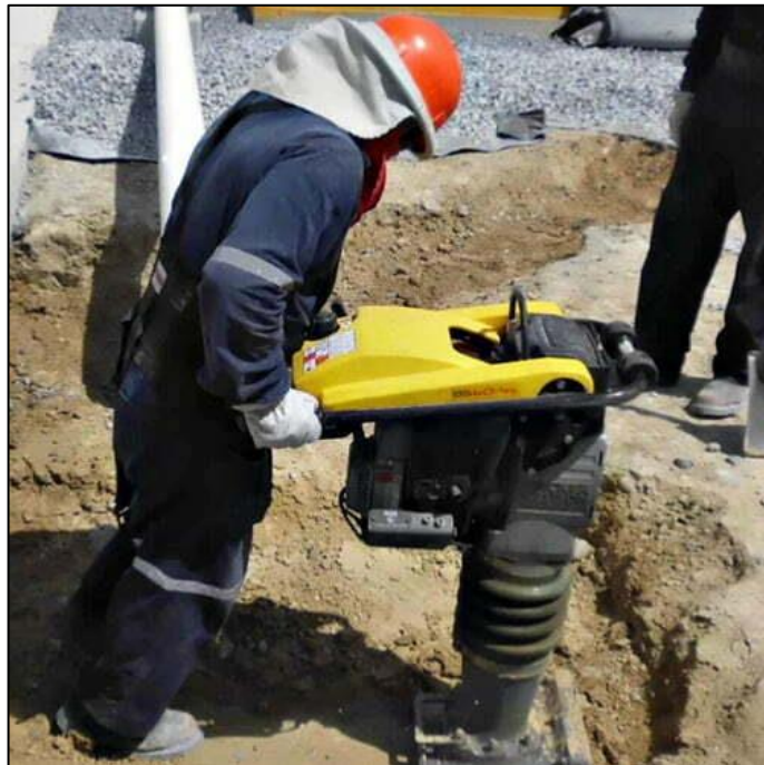
Figura N° 23: Compactación de terreno con canguro compactador. Fuente: Tomada por Alquiros Enriquez.
