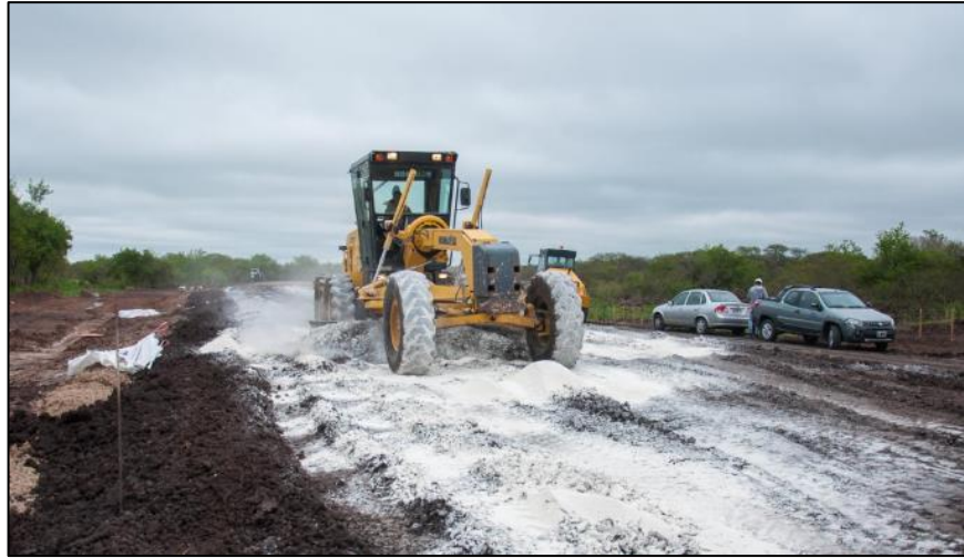
Figura N° 19: Mejoramiento de caminos naturales con sistema con cal Fuente: Tomada por Máxima Online, 2018.
