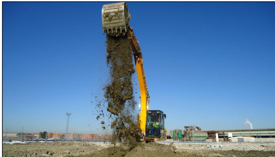
Figura N° 13: Proceso de aireación de suelos Landfarnig. Fuente: Tomada por Interempresas, 2017.
