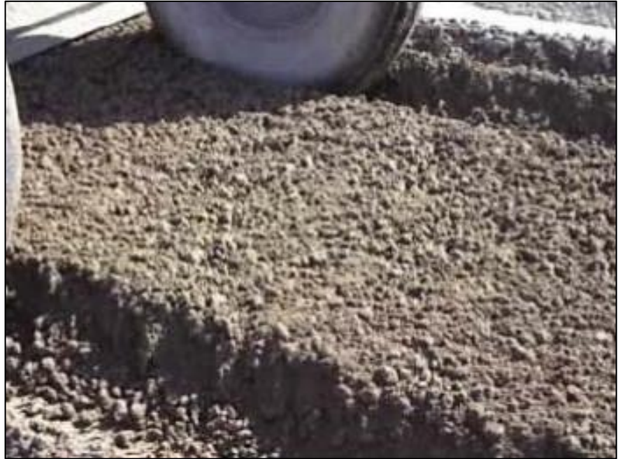
Figura N° 17: Suelo de arcilla floclada con cal. Fuente: Tomada por Nacional Lime Association, 2004.
