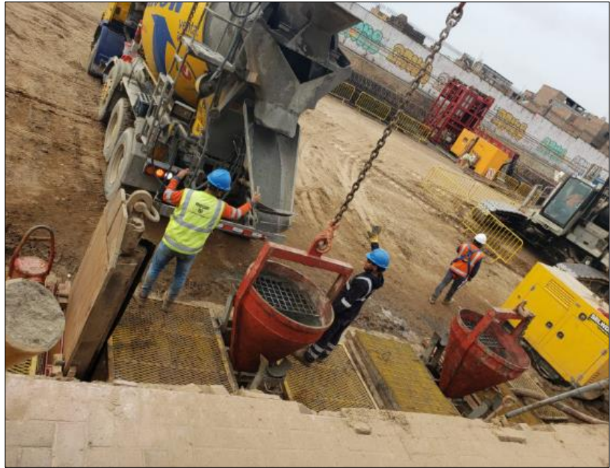
Figura N° 47: Vaciado de concreto muro pantalla. Fuente: Elaboración Propia (2020).
