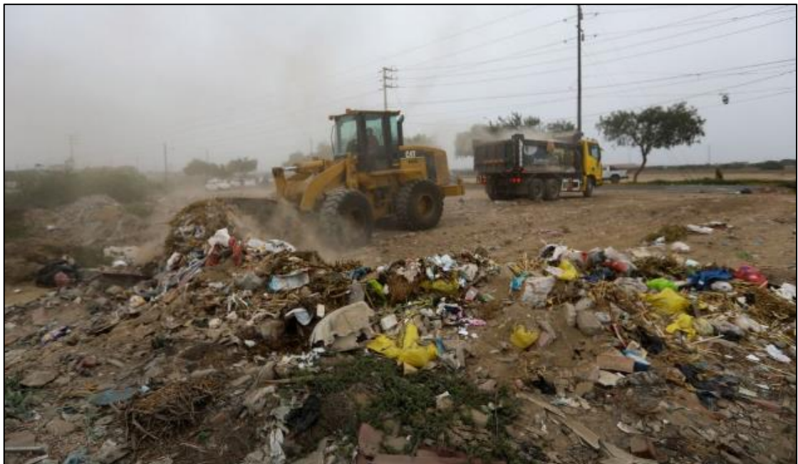
Figura N° 3: Recojo de residuos de la construcción. Fuente: Tomado de La Republica, 2021.
