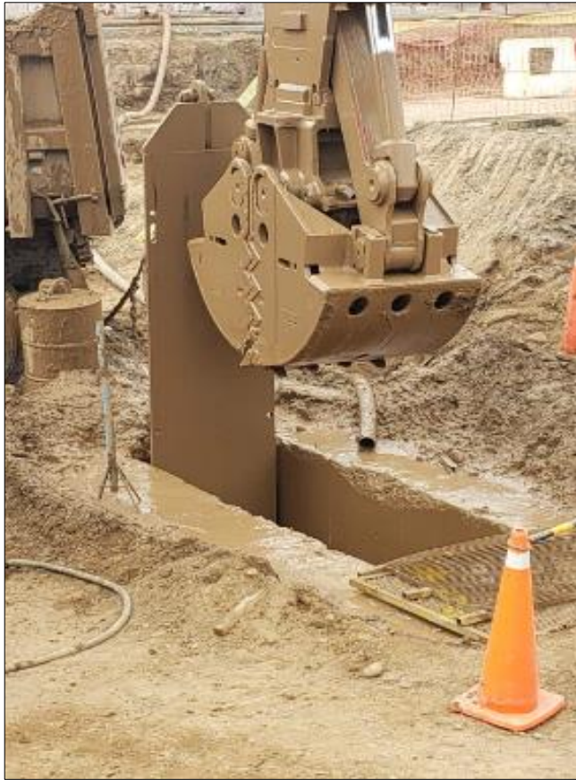
Figura N° 43: Perforación de muros pantallas. Fuente: Elaboración Propia (2020).
