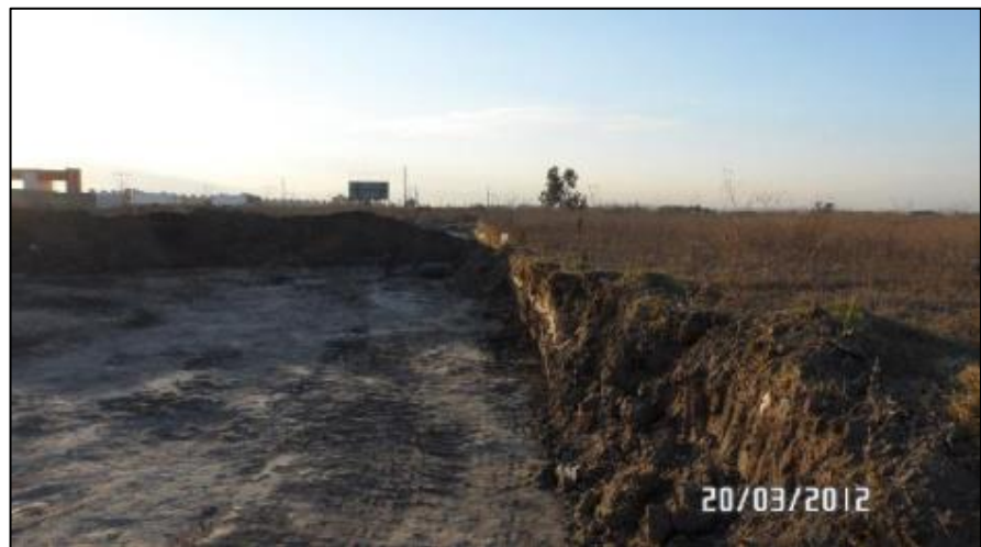
Figura N° 14: Sustitución de suelos. Fuente: Tomada por Doroteo Cid, 2012.
