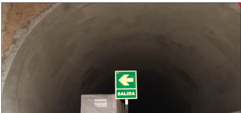
Figura N° 61: Instalación de dovelas de concreto. Fuente: Andina agencia peruana de noticias (2022).
