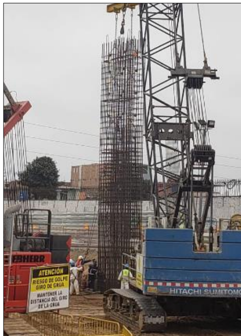
Figura N° 46: Armado de muro pantalla. Fuente: Elaboración Propia (2020).
