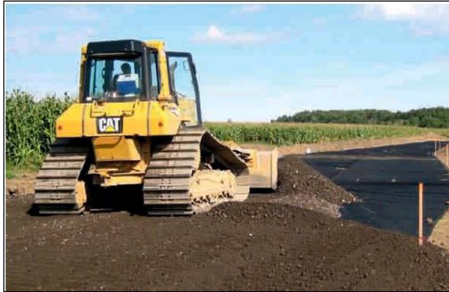
Figura N° 16: Sustitución de suelos en Nicaragua.
