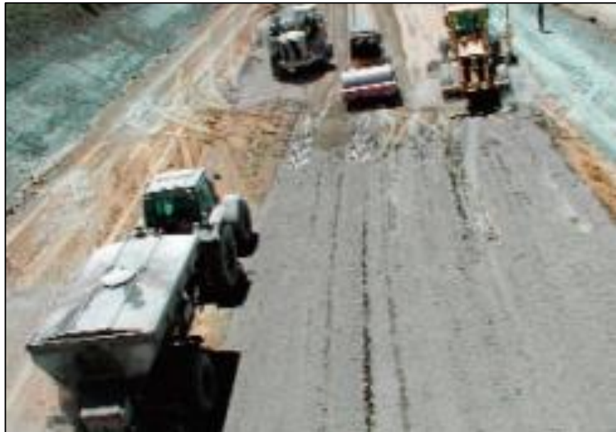
Figura N° 21: Estabilización con cemento. Fuente: Tomada por ANCADE, ANTER & IECA, 2008.
