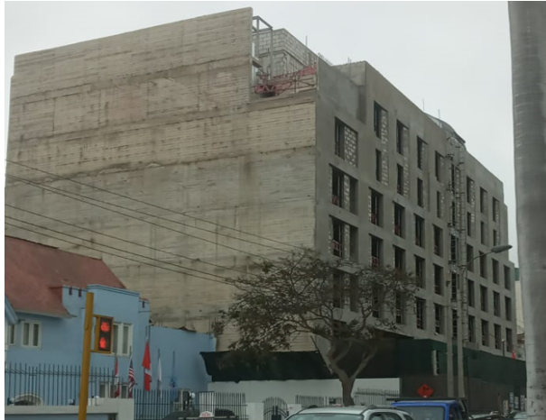
Figura 11: Tomada el 25/08/2020 en etapa de acabados
