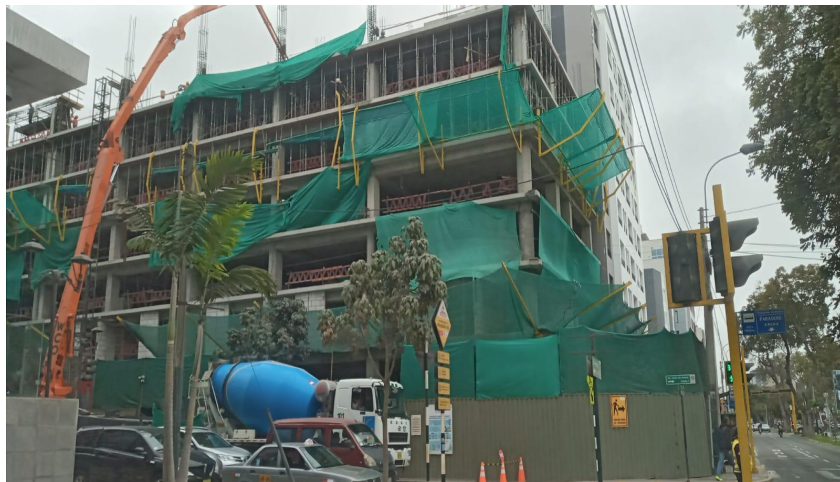
Figura 14: Tomada el 25/09/2022 durante el vaciado de concreto de concreto
