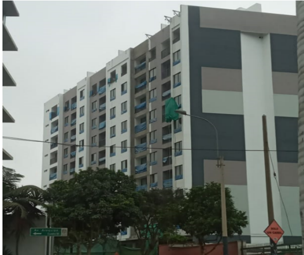
Figura 13: Tomada el 25/08/2022 en etapa de acabados
