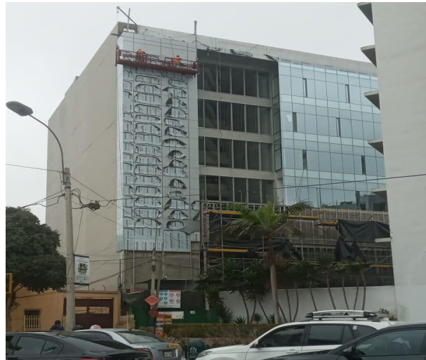
Figura 12: Tomada el 25/08/2022 en etapa de acabados
