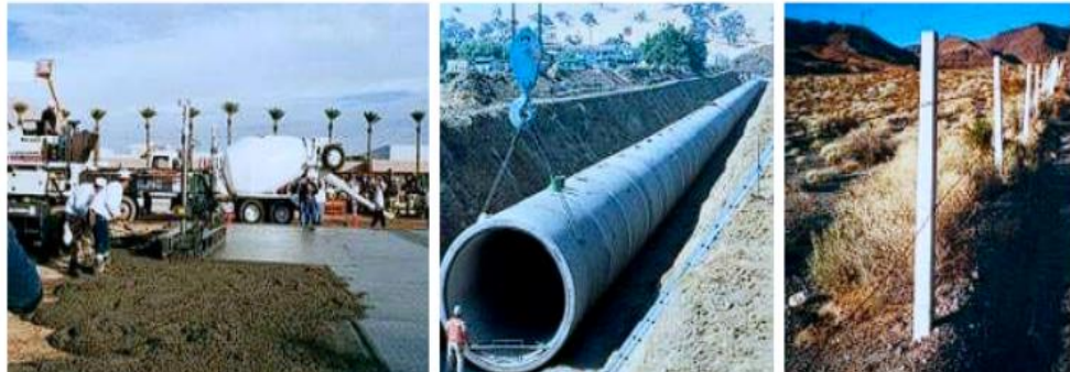
Figura 3 Losas sobre suelo, tuberías y postes de concreto expuestos a suelos con alto contenido de sulfatos.
