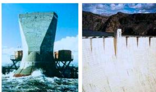
Figura 5 Apoyos espesos de puente y presa. La presa de Hoover, enseñada aquí, usó el cemento tipo IV para controlar el aumento de temperatura. Fuente: (Kosmatka, S. et al, 2004)
