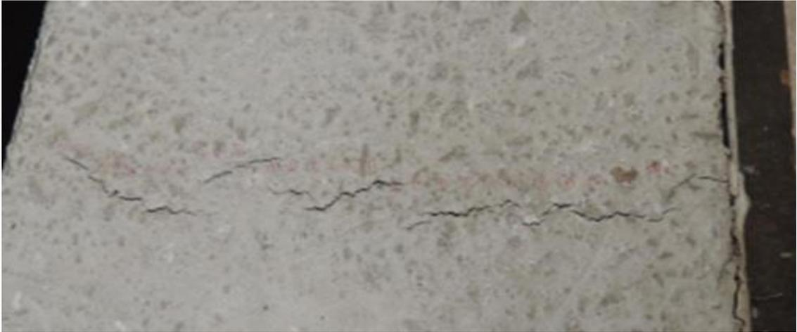
Figura N° 9: Fisuras por contracción plástica en losa.
