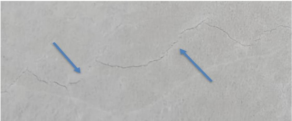
Figura N° 10: Fisuras por contracción plástica en vereda.
