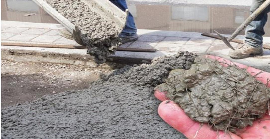
Figura N° 2: Hormigón con adición de fibras
