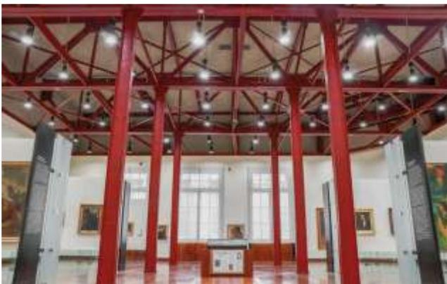
*Figura 12: Columnas de acero en la pinacoteca del 2do piso.*
