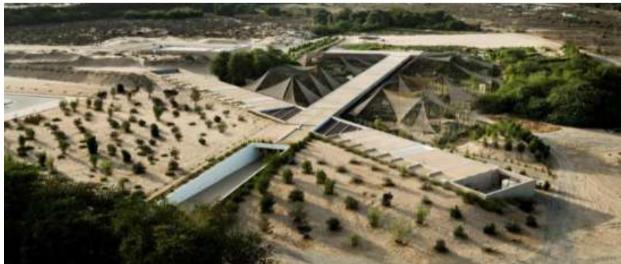
Ilustración 6: Vista área del proyecto.
