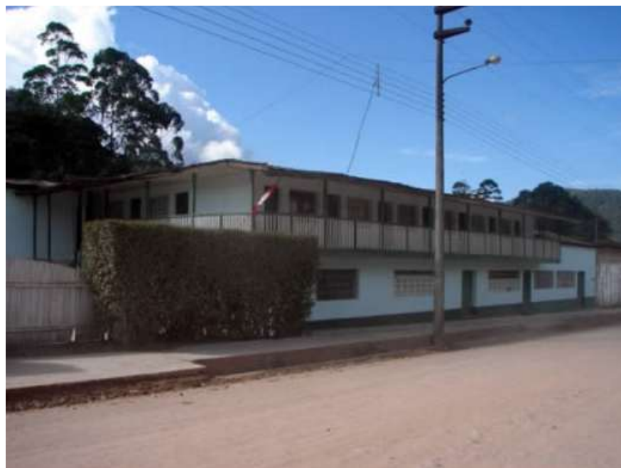
Ilustración 63: Imagen de colegio que muestra elementos arquitectónicos utilizados en el distrito de Villa Rica.
