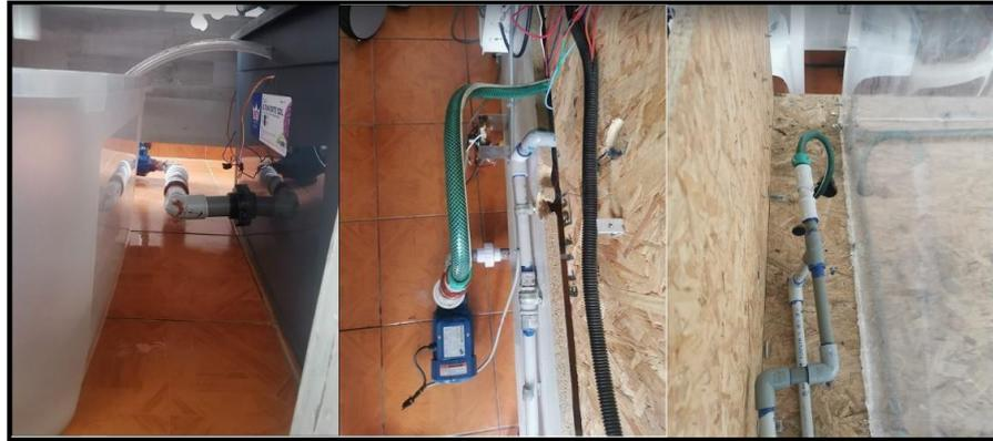
Figura N°26: Entrada y Salida de la Electrobomba de agua
