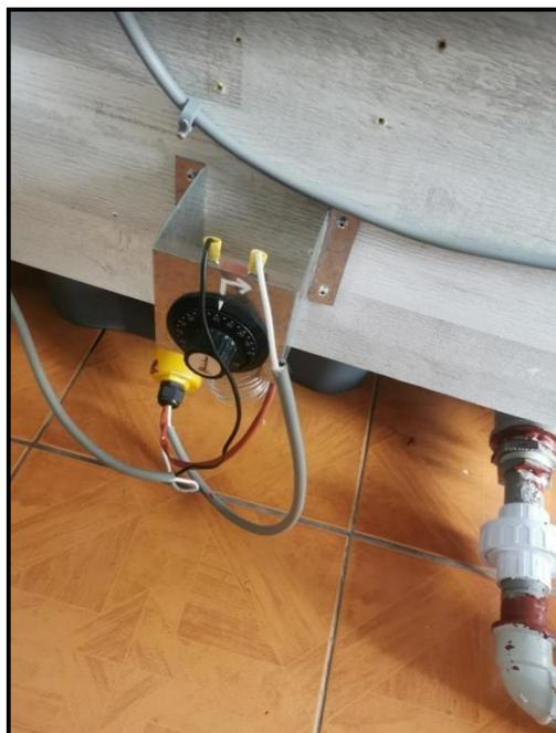
Figura N°43: Termostato de respaldo
