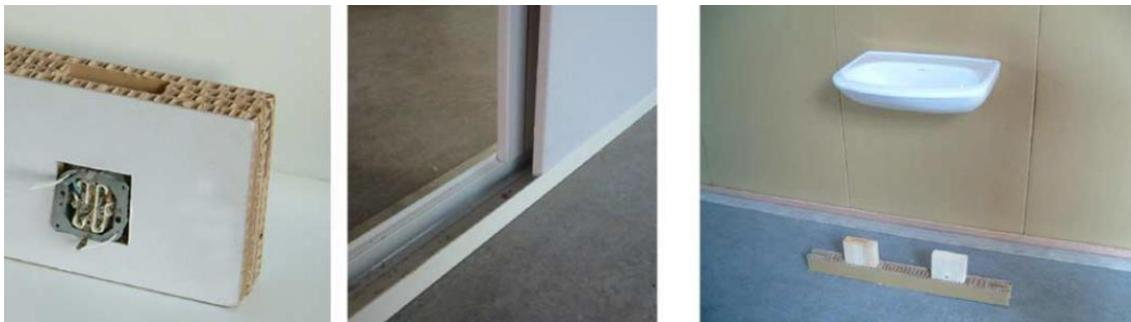
*Nota:* La figura muestra la funcionalidad del sistema de paneles inclusive para la instalación de aparatos sanitarios. Fuente: Cassandro-Cajiao (2018)
