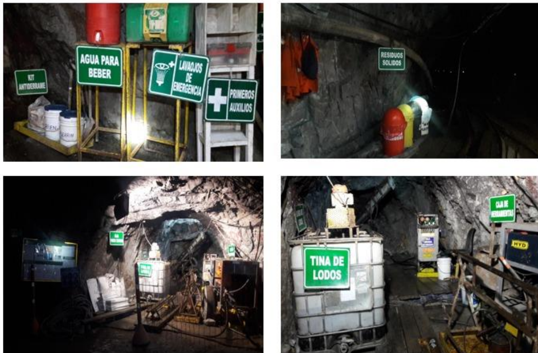
Figura A11: Señalización de áreas de trabajo.
