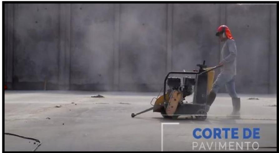
Figura N° 43: Cortes de pavimento
