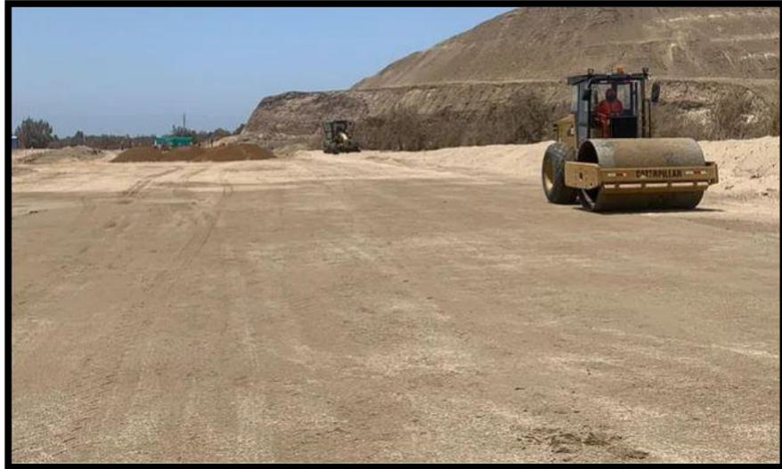
Figura N° 33: Nivelación, conformación y compactado de terreno
