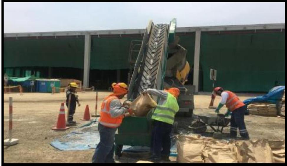
Figura N° 32: Colocación de fibra de acero en el concreto
