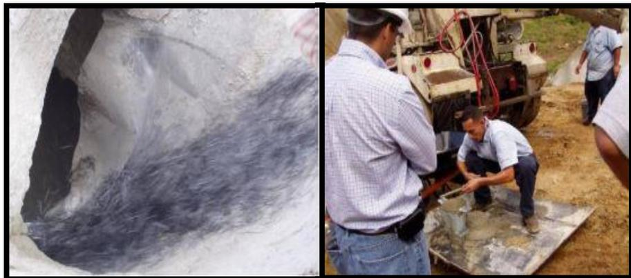
Figura N° 36: Incorporación de fibras de acero al mixer-ensayos de slump del concreto con fibras de acero
