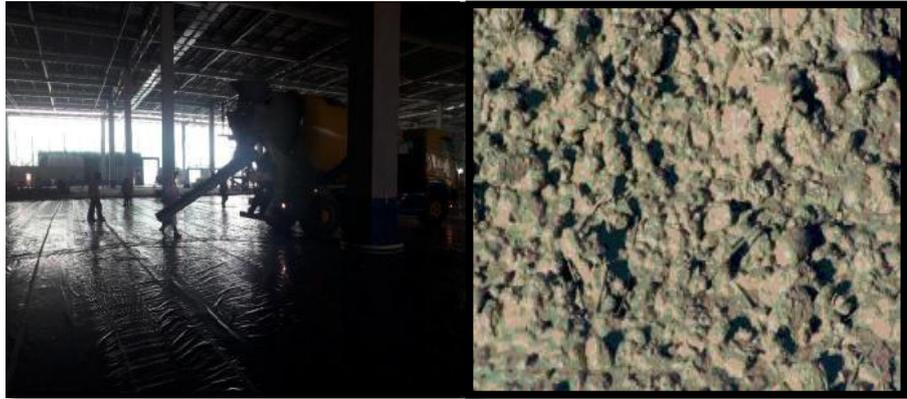
Figura N° 37: Mezclado del concreto con la fibra de acero
