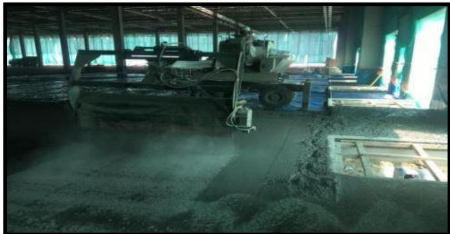
Figura N° 45: Colocación de endurecedores de capa de rodadura
