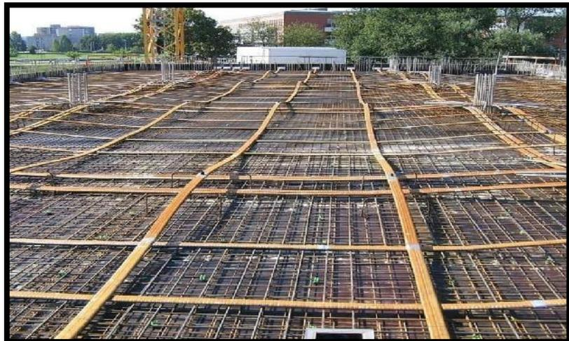
Figura N° 8: Losas postensadas
