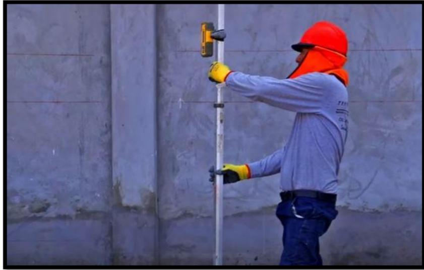
Figura N° 41: Nivelación óptica con láser de losas industriales
