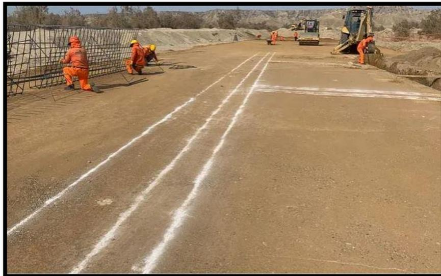
Figura N° 34: Trazos para sectorizar las losas
