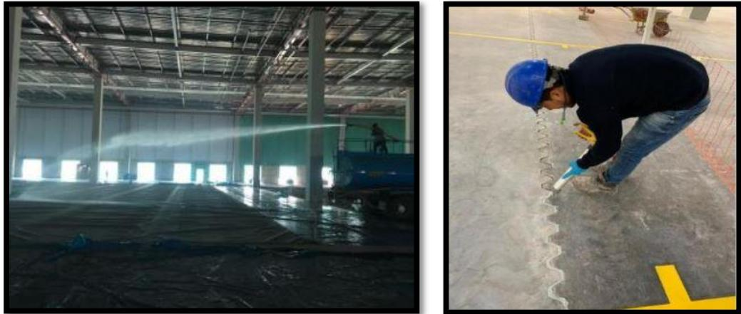
Figura N° 44: Curado y sellado de juntas en losas industriales
