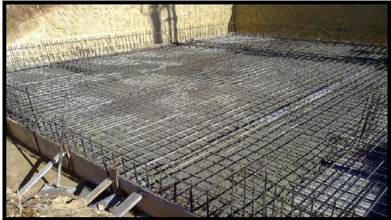
Figura N° 7: Losas con refuerzo de acero corrugado
