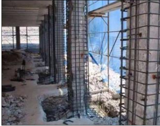
Figura 9: Encamisado de columnas
