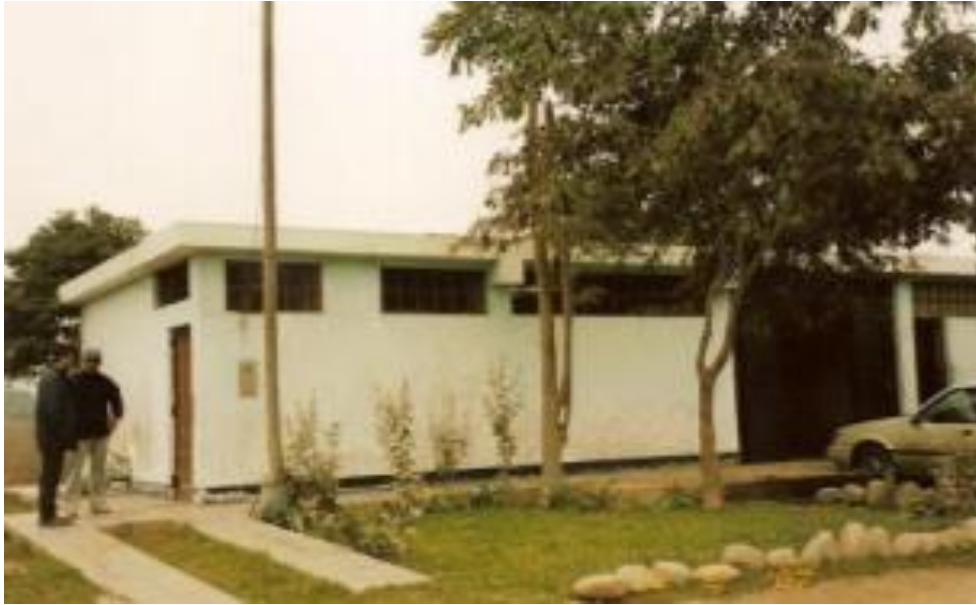
Figura 17: Caseta de Bombeo ubicado en La Huaca– EMAPA Huaral.
