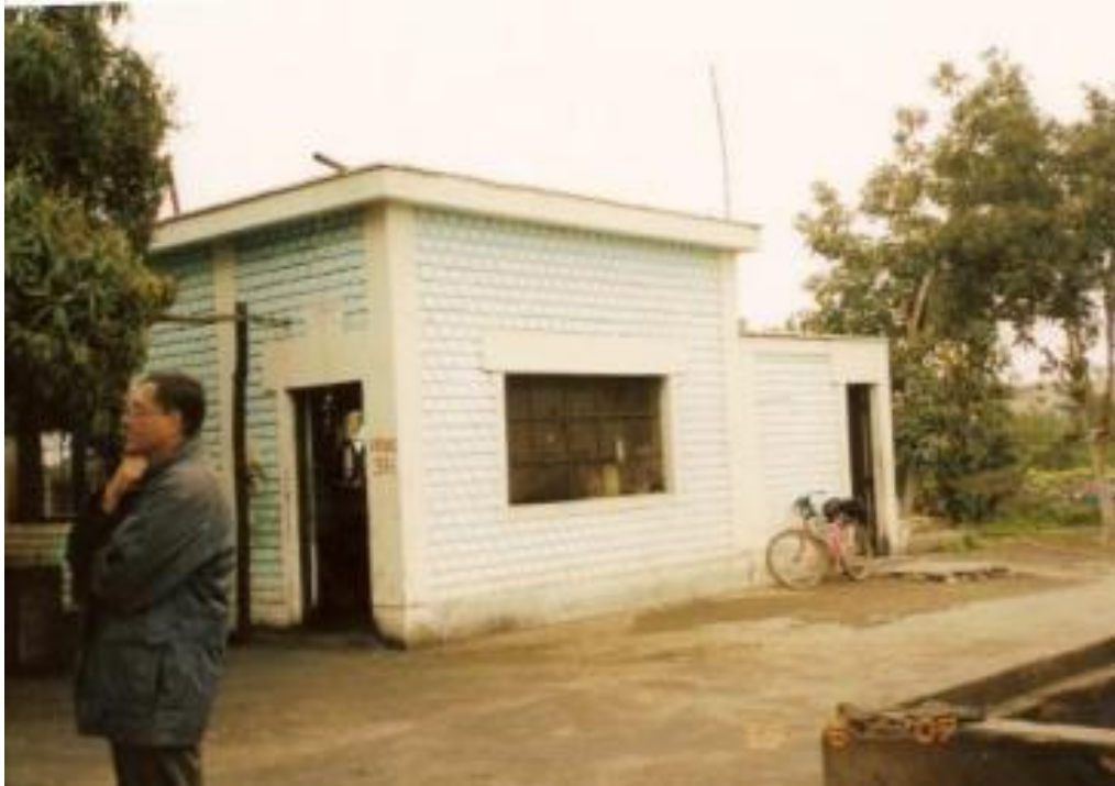
Figura 15: Caseta de Bombeo ubicado en los granados – EMAPA Huaral.
