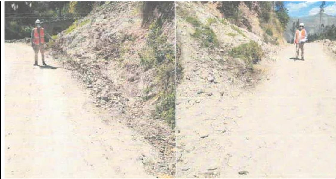
Evidencias de derrumbes mayor a 1m3, denota falta de desquinche y limpieza de derrumbes.
