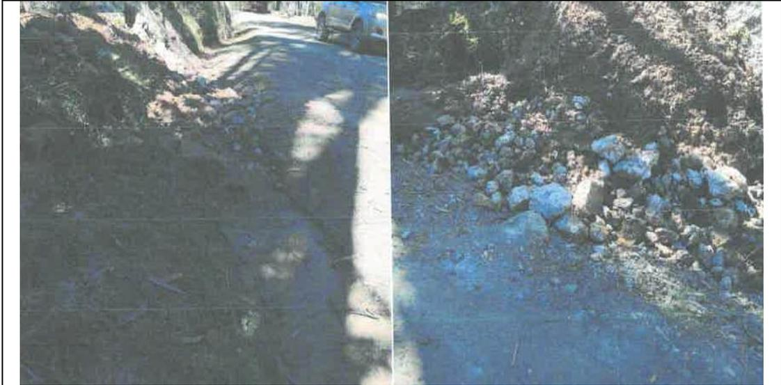
Evidencias de derrumbes mayor a 1m<sup>3</sup>, denota falta de desquinche y limpieza de derrumbes.
