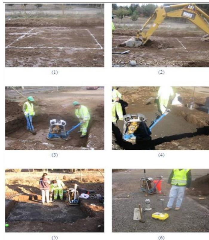
Figura 03: proceso constructivo del experimento relleno
