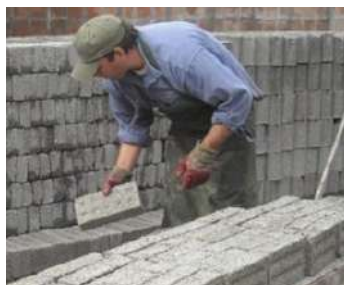
Muro de Ladrillo Ecológico, 2016
