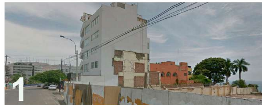
Edificio multifamiliar de 4 pisos al lado izquierdo del terreno
