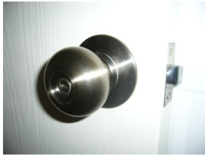
Detalle de cerradura de puerta interior
