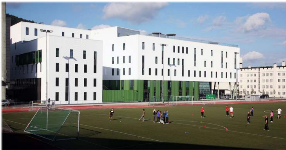
Fig N°11, Hospital psiquiátrico de Kronstad
