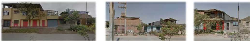
Fig. N° 36,37,38 , Zona comercio vecinal fachada norte , Fuente: Google Earth
