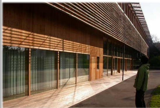
Fig. N°53, Fachada Rehab Basel , Suiza. Herzon & de Meuron
