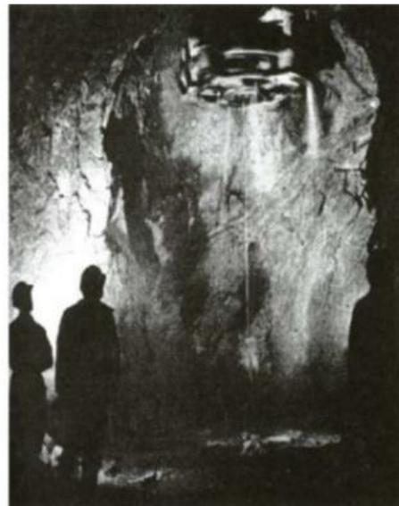
Figura 3. Perforación de chimenea subterránea. Inicio de perforación rimado
