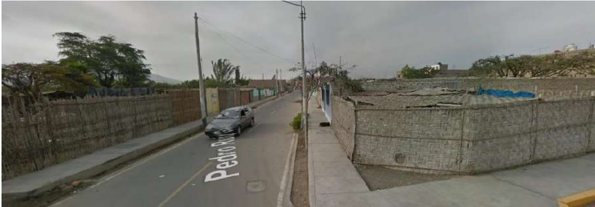
IMAGEN 32: VIVIENDA PRECARIA-ÑEPEÑA. FUENTE: GOOGLE STREET VIEW.
