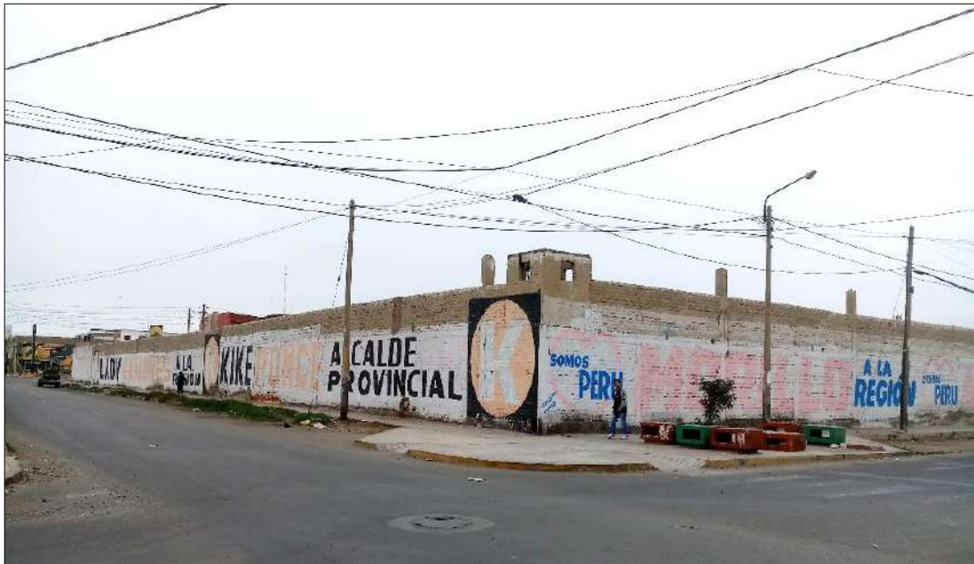
IMAGEN 44: VISTA DE LA INTERSECCION DE PROLOG. LEONCIO PRADO CON JR. DRENAJE. FUENTE: PROPIA-SETIEMBRE 2019.
