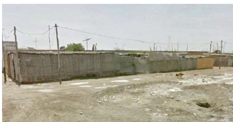
IMAGEN 36: VIVIENDAS DE MATERIALES PRECARIOS EN CHIMBOTE. FUENTE: GOOGLE EARTH.
