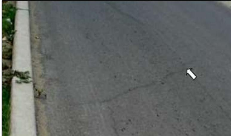
Figura N°27: Fisura parabólica o por deslizamiento.
