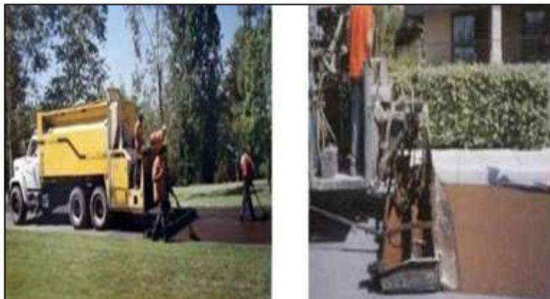
Figura N°42: Aplicación de lechada asfáltica y micro aglomerante
