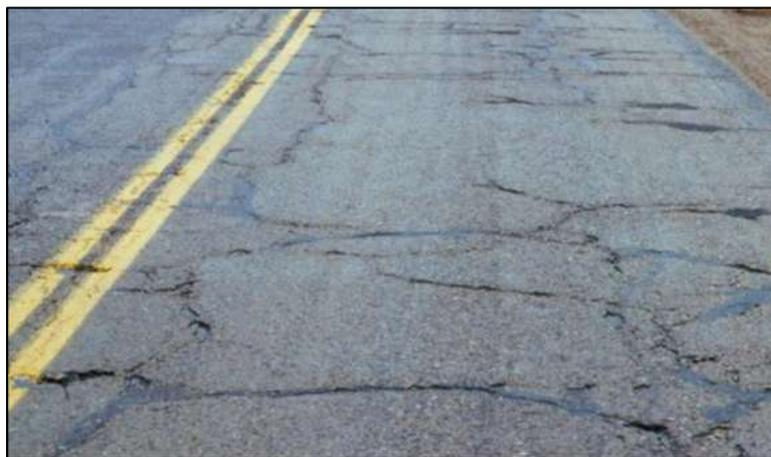
Figura N°11: Agrietamiento en bloque.
