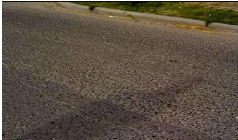
Figura N°26: Peladura por intemperismo y desprendimiento de agregados.
