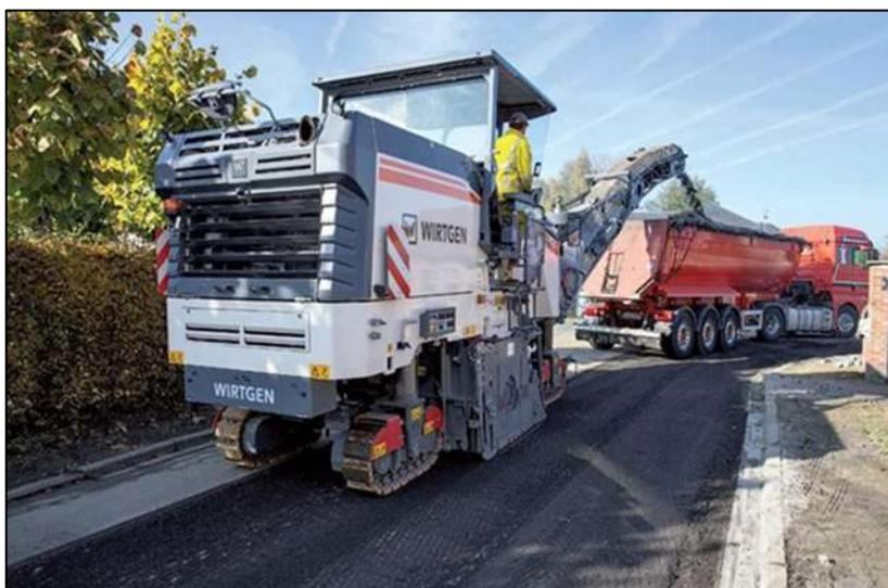
Figura N°46: Maquina fresadora, pavimento y material fresado
