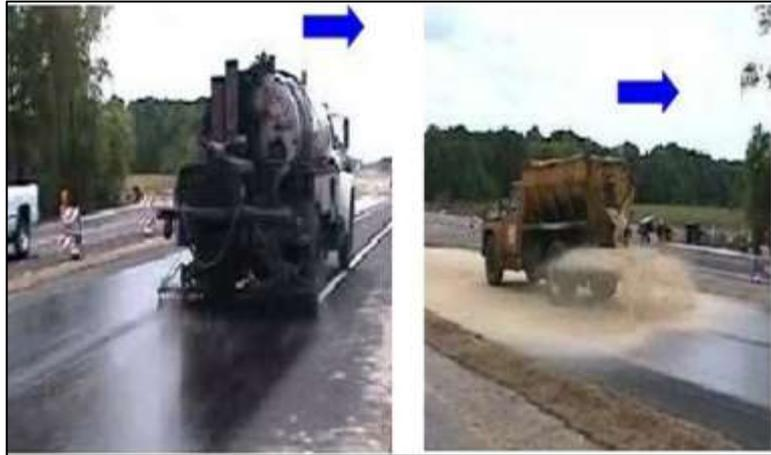
Figura N°39: Procedimiento típico sello arena-asfalto
