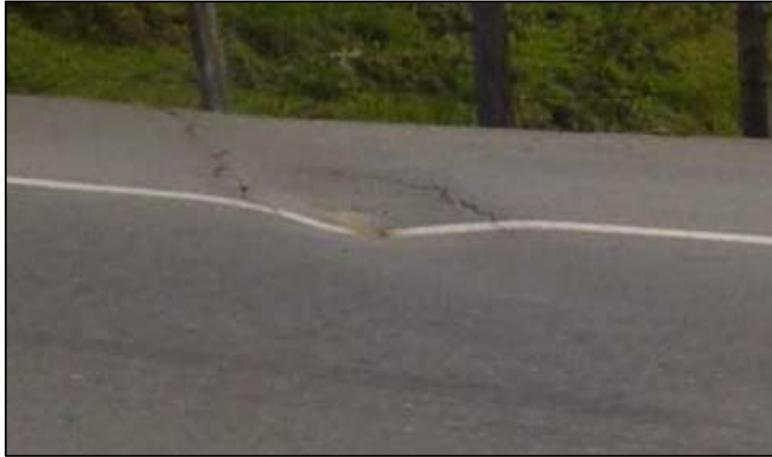
Figura N°13: Hundimiento.
