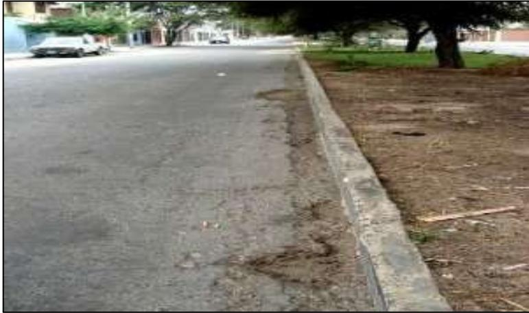
Figura N°16: Fisura de borde.
