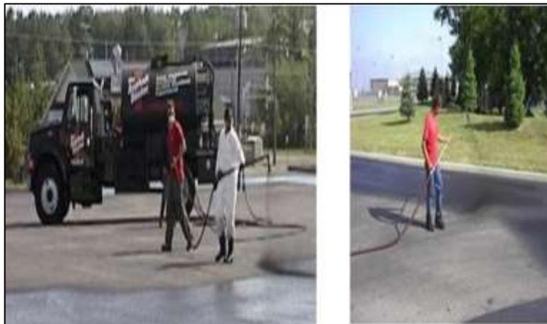
Figura N°40: Procedimiento típico de riego negro
