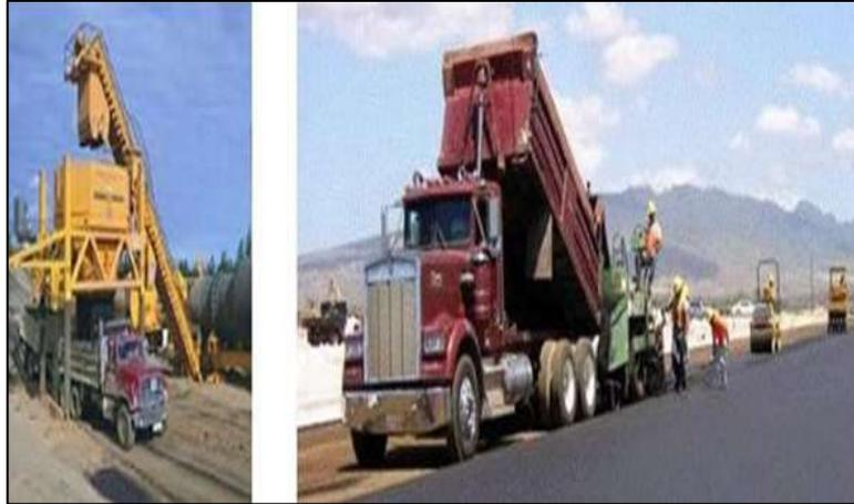
Figura N°44: Sobre carpeta de asfalto.
