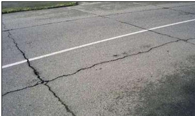
Figura N°23: Fisura de reflexión de juntas
