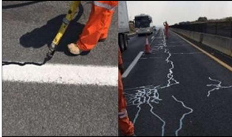
Figura N°37: Sellado de grietas con asfalto
