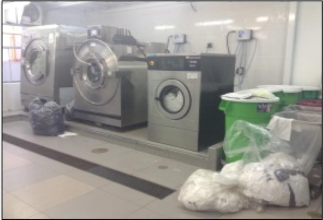
Figura 25. Área de Lavandería
