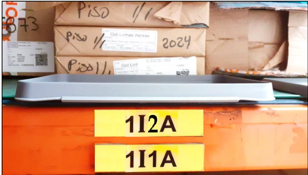
Figura 56. Etiqueta amarilla colocada en la viga del rack.
