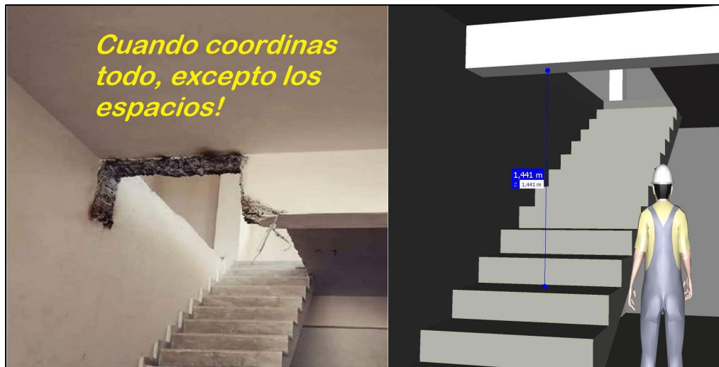
Figura N° 20: Errores de espacio de una escalera Fuente: FB 3M Civil Engineering Solutions 3MCES
