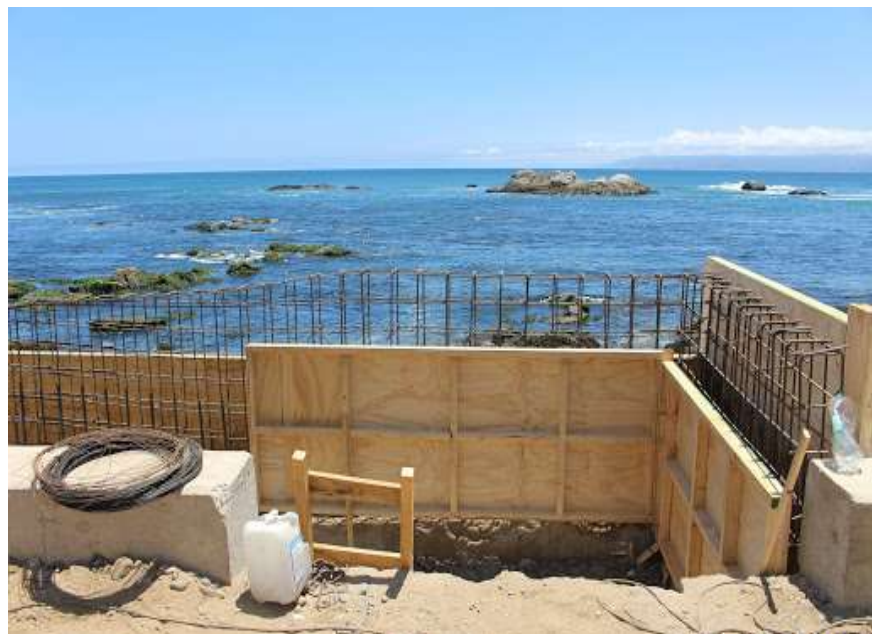
Construcción de muro costero de concreto armado
