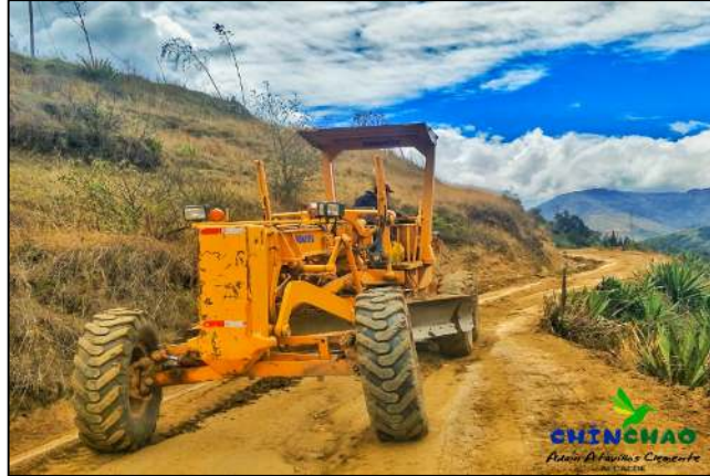
Figura 57. Trabajos de nivelación y compactación de la superficie de rodadura
