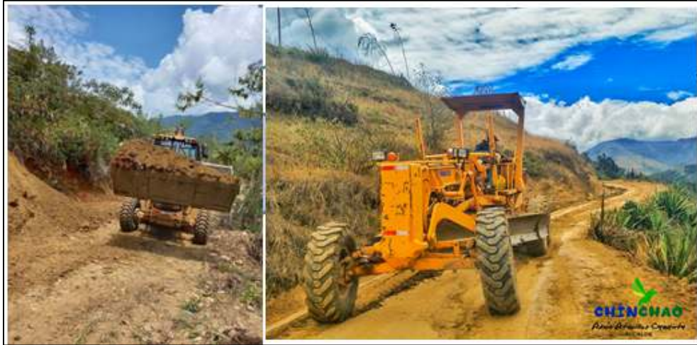
Figura 58. Cargador frontal y Motoniveladora haciendo trabajos de mantenimiento
