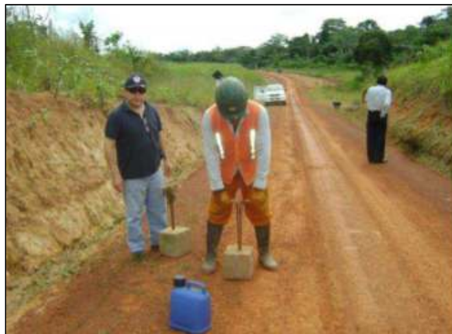
Figura 56. Compactación de baches (Bacheo), en un Mantenimiento Rutinario.
