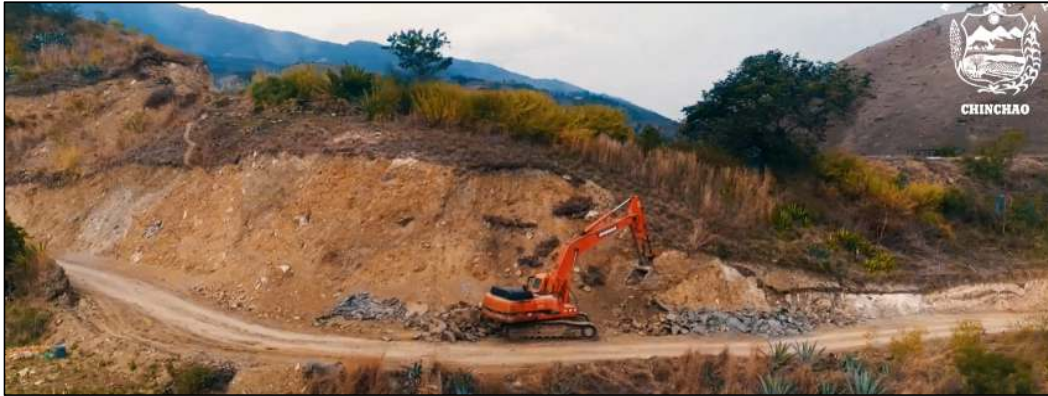
Figura 55. Trabajos de reposición de afirmado
