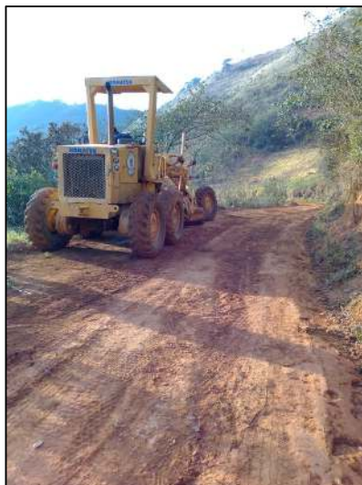
Figura 54. Trabajados de perfilados y nivelación
