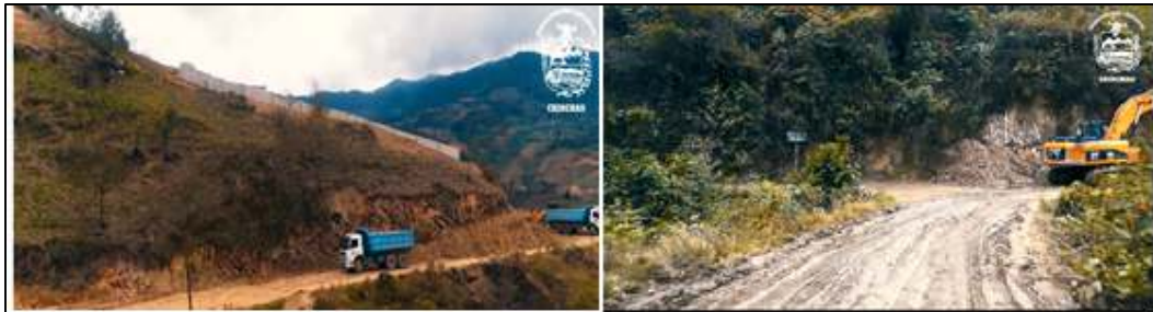
Figura 59. Camiones volcadores y excavadoras haciendo actividades de mantenimiento.
