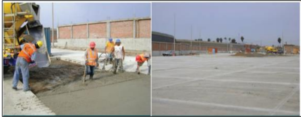
Figura N° 27: Ejecución de obra Almacén Cormin, Lima- Perú
