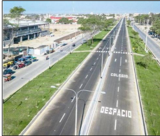
Figura N° 26: Obra vial concluida de la Av. Sánchez Cerro tramo Av. Gullman – Av. Chulucanas
