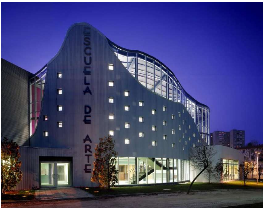
Figura 1. Vista fachada principal de la escuela de artes en Guadalajara
