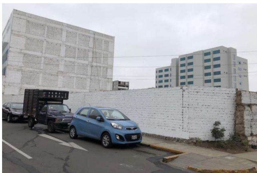
Figura 27. Vista del exterior del terreno 2 – Alameda del Alba
