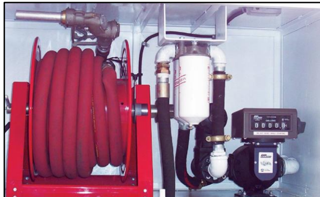
Figura 5: Sistema de abastecimientos en Cisternas Fuente: https://www.efreyre.com/
