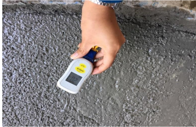
Figura 9: Medición de temperatura del concreto en estado fresco Fuente: Elaboración propia
