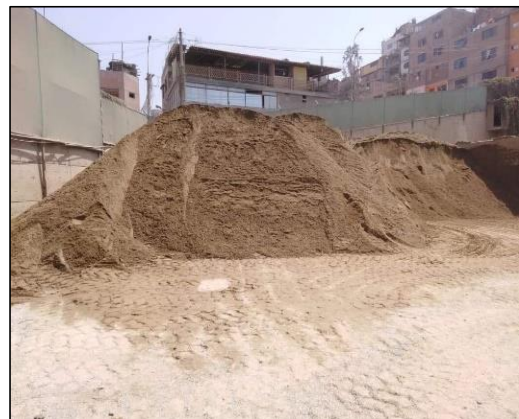
Figura 3: Agregado fino Fuente: Elaboración propia
