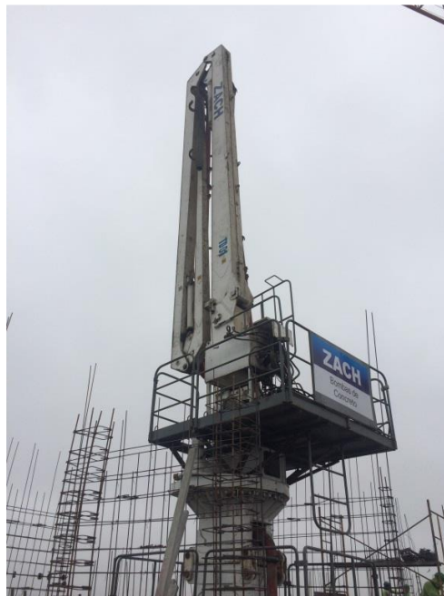
Figura 24 TDH en posición vertical para el telescopaje Fuente: Propia
