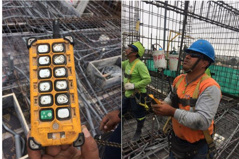
Figura 25 Control remoto para manipular la TDH Fuente: Propia
