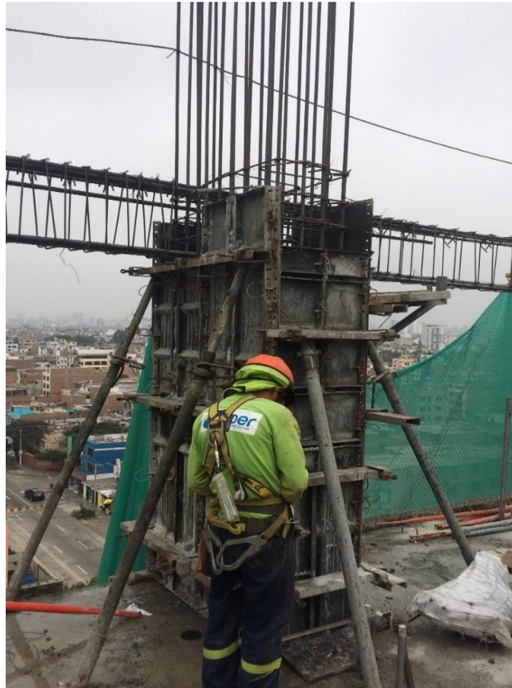
Figura 43 Vaciado de placas y columnas del sector 1 Fuente: Propia
