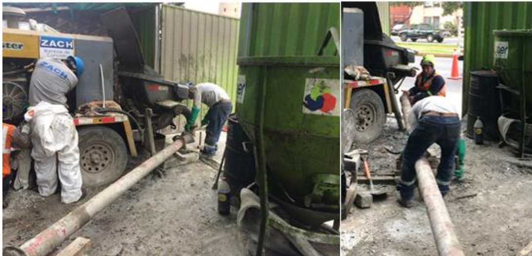
Figura 28 Nivelación de las tuberías para la conexión con la bomba estacionaria Fuente: Propia
