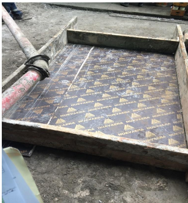
Figura 29 Cajón de madera con fenólico para recibir excesos del concreto Fuente: Propia
