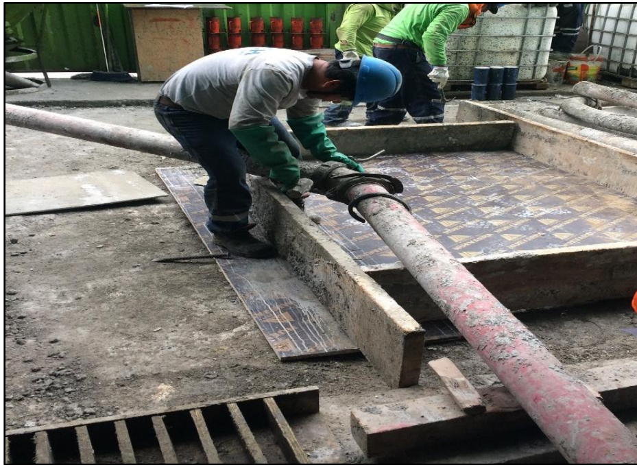
Fotografía N° 1: Instalación de las tuberías iniciales del sistema de bombeo con la TDH
