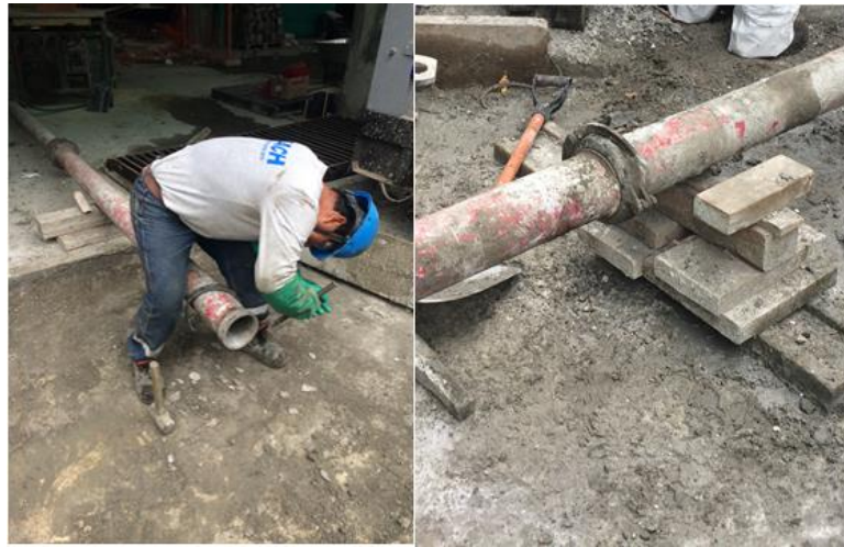
Figura 27 Instalación de acoplamientos de seguridad en las tuberías metálicas Fuente: Propia
