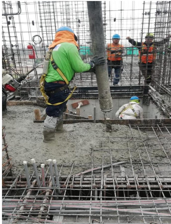
Figura 40 Vaciado de losa del Sector 3 Fuente: Propia
