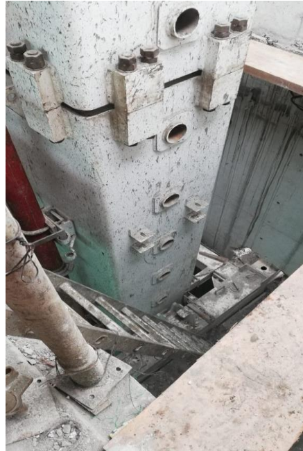
Figura 21 Preparación de la torre para telescopaje Fuente: Propia
