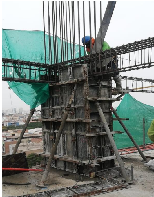
Figura 49 Vaciado de placas del sector 3 Fuente: Propia
