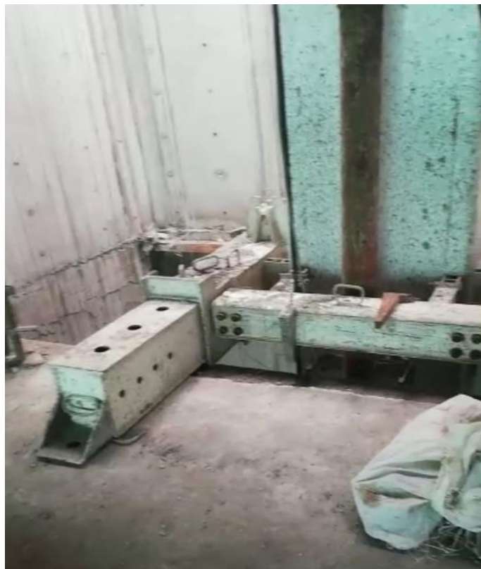
Figura 16 Pasadas al mismo nivel de losas Fuente: Propia
