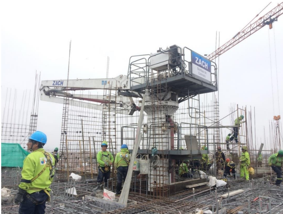
Figura 15 Sistema modular sin contrapeso de la TDH en la obra Modo Student Residence Fuente: Propia
