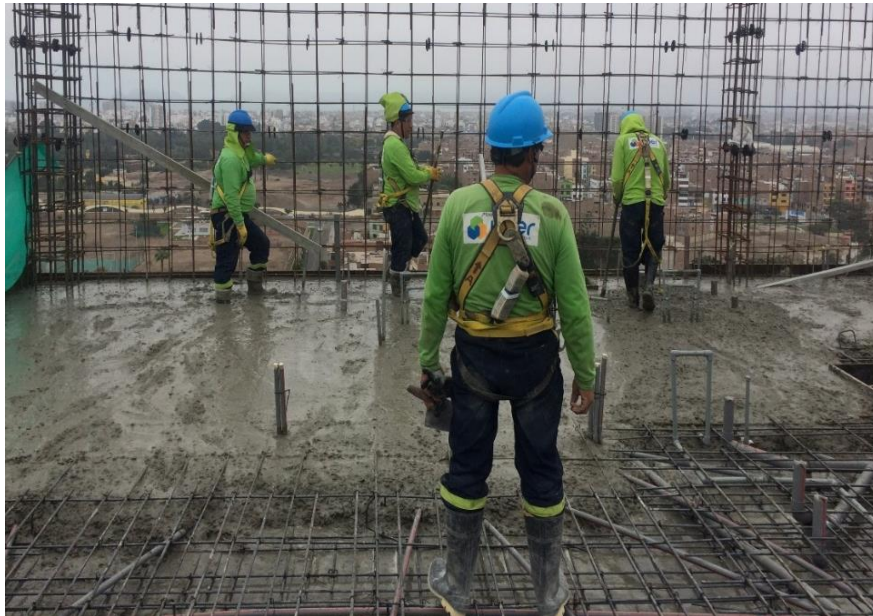
Figura 37 Vaciado de losa del Sector 2 Fuente: Propia
