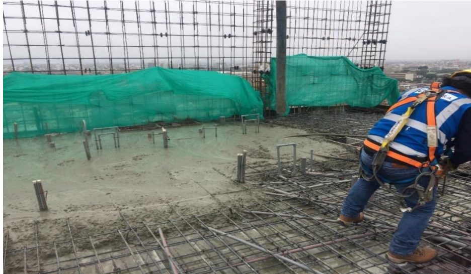
Figura 34 Vaciado de losa y vigas del sector 1 Fuente: Propia
