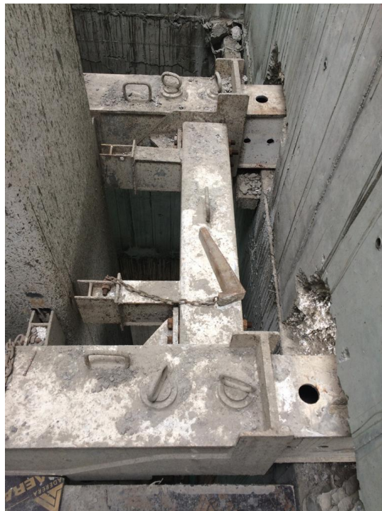
Figura 18 Vigas retractiles atravesando los muros Fuente: Propia
