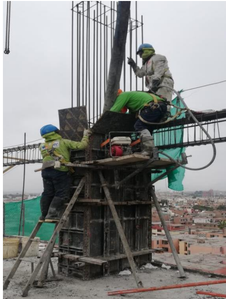
Figura 46 Vaciado de placas y columnas del sector 2 Fuente: Propia
