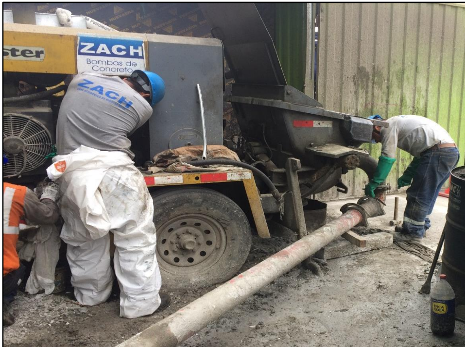
Fotografía N° 2: Preparación de la lechada en la bomba estacionaria
