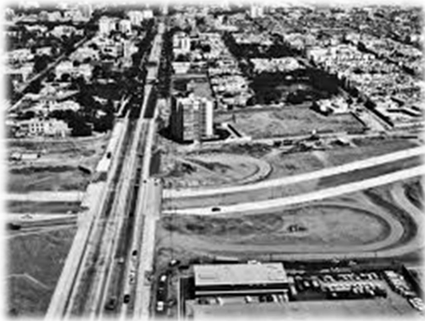
Figura 13: Zona de estudio en 1967 con el demolido edificio Seoane. Fuente: (Revista en Lima, 2016)
