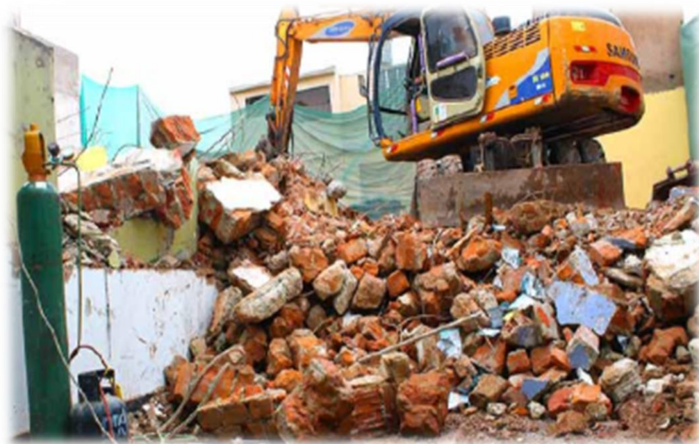
Figura 7: Demolición sin segregación de residuos Fuente: (Democame, 2019)
