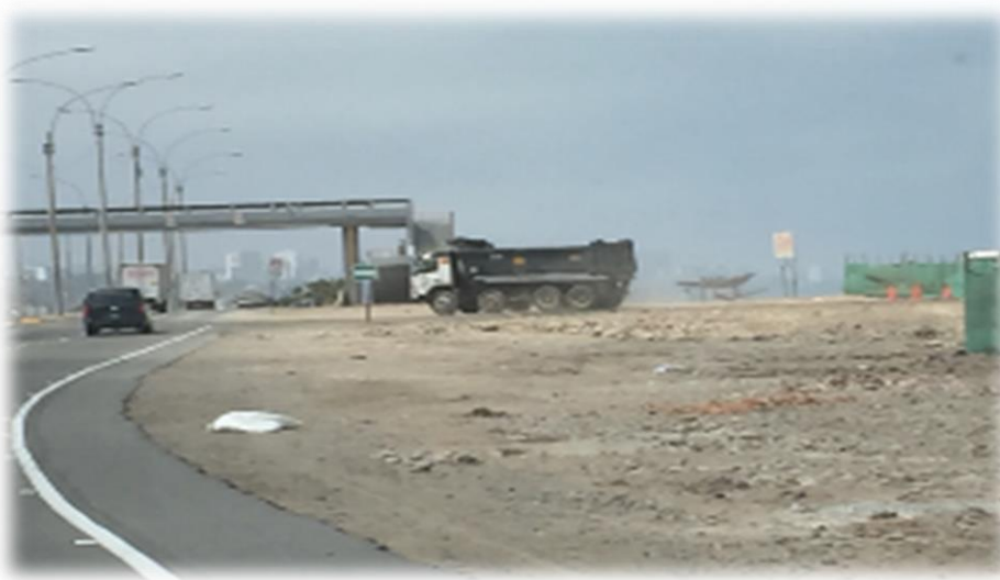
Figura 2: Zona de ingreso de camiones que transportan desmonte a playas Fuente: Propia
