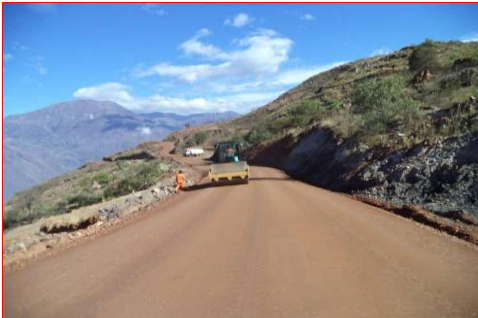
Fig. N°60. Compactación de Material Granular
