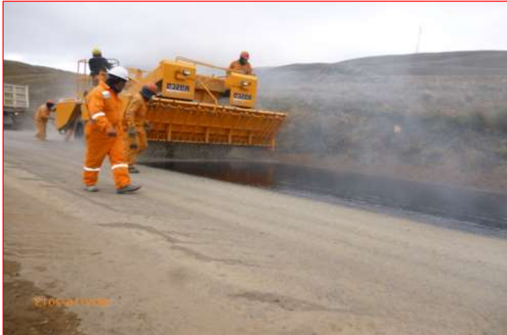
Fig. N°67. Aplicación de Sello Asfaltico
