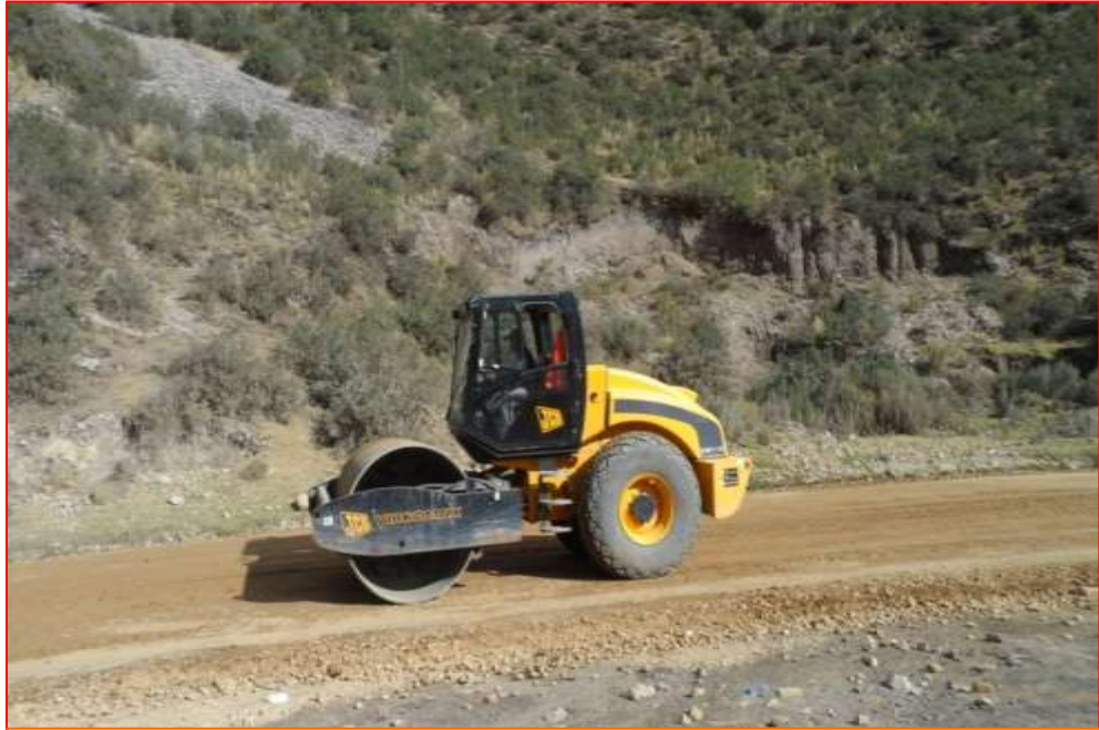
Fig. N°59. Compactación de Material Granular
