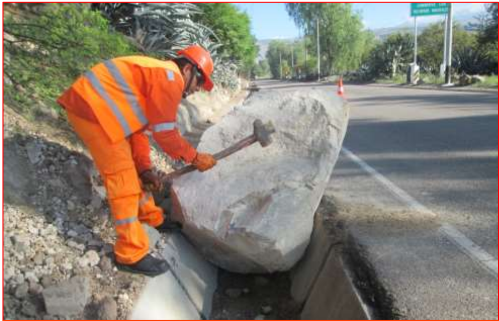
Fig. N° 39. Limpieza de cunetas
