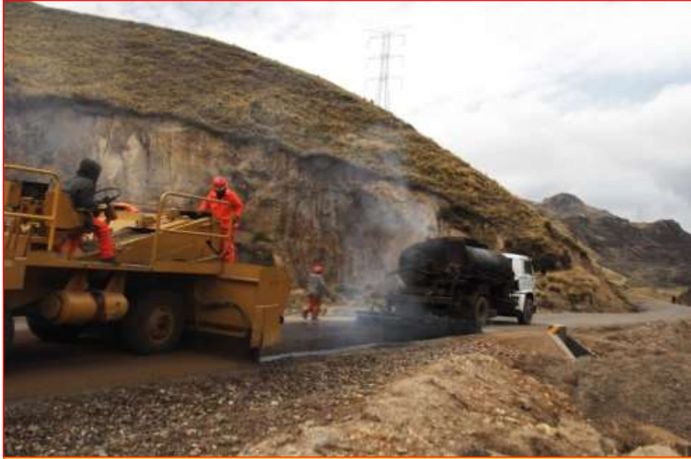
Fig. N°63. Arenado después de imprimación.
