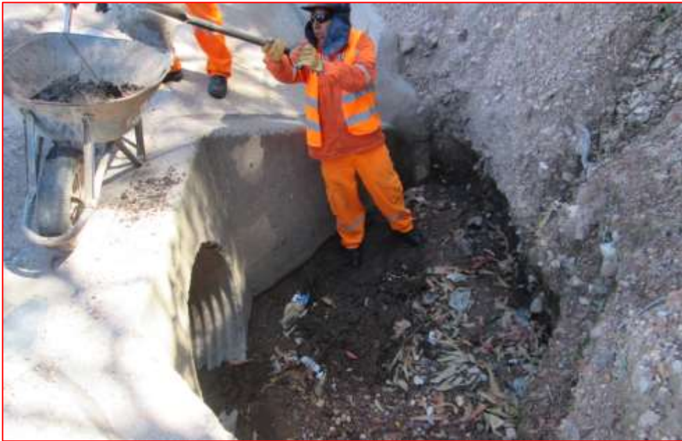
Fig. N°36. Limpieza de Alcantarilla
