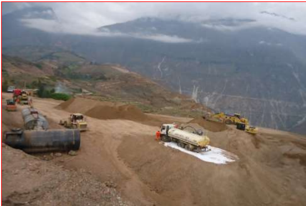
Fig. N°50. Producción de Material para recarga granular
