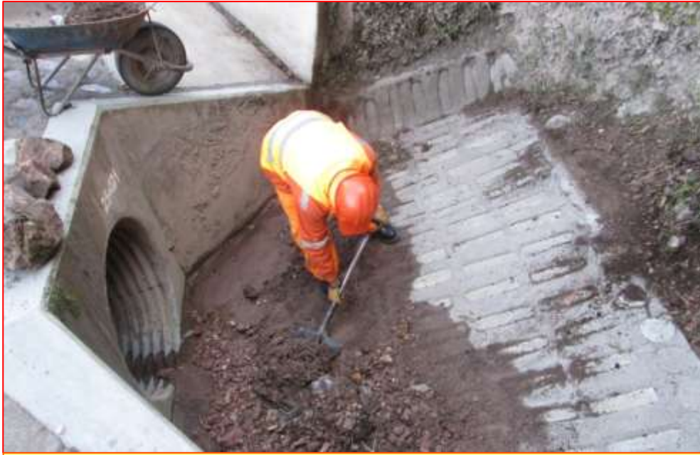
Fig. N°35. Limpieza de Alcantarilla
