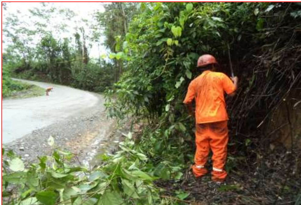
Fig. N°32. Desbroce de Maleza
