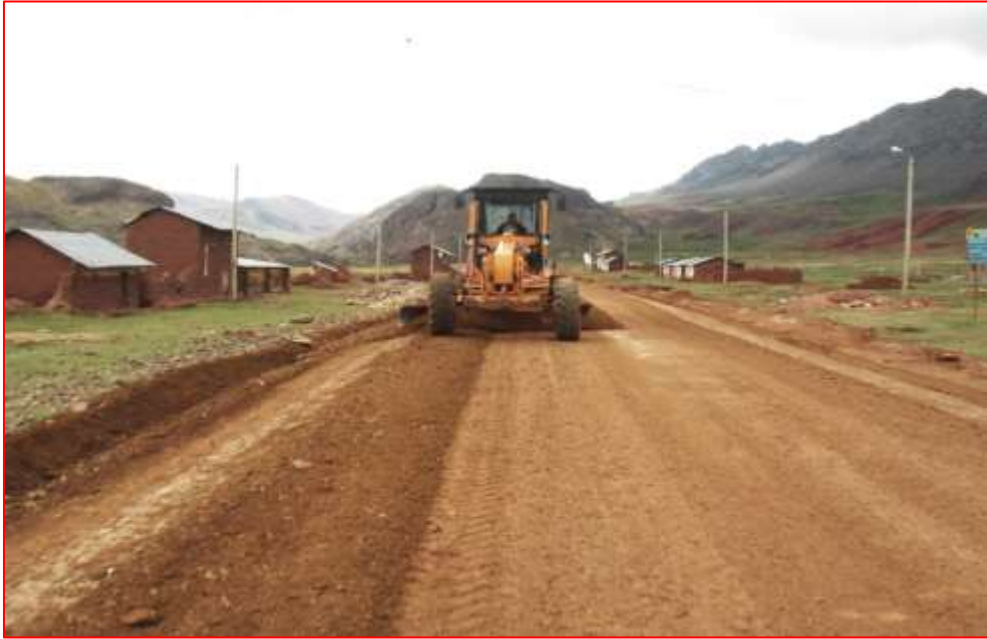
Fig. N°57. Perfilado y refinado en recarga de capa granular
