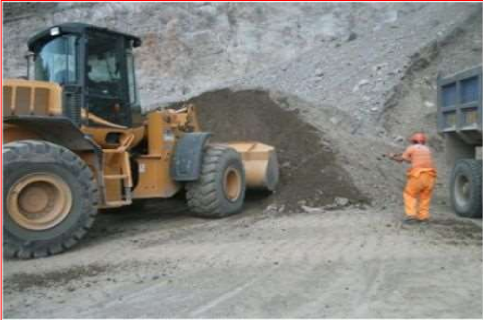
Fig. N°47. Extracción de Material para recarga granular
