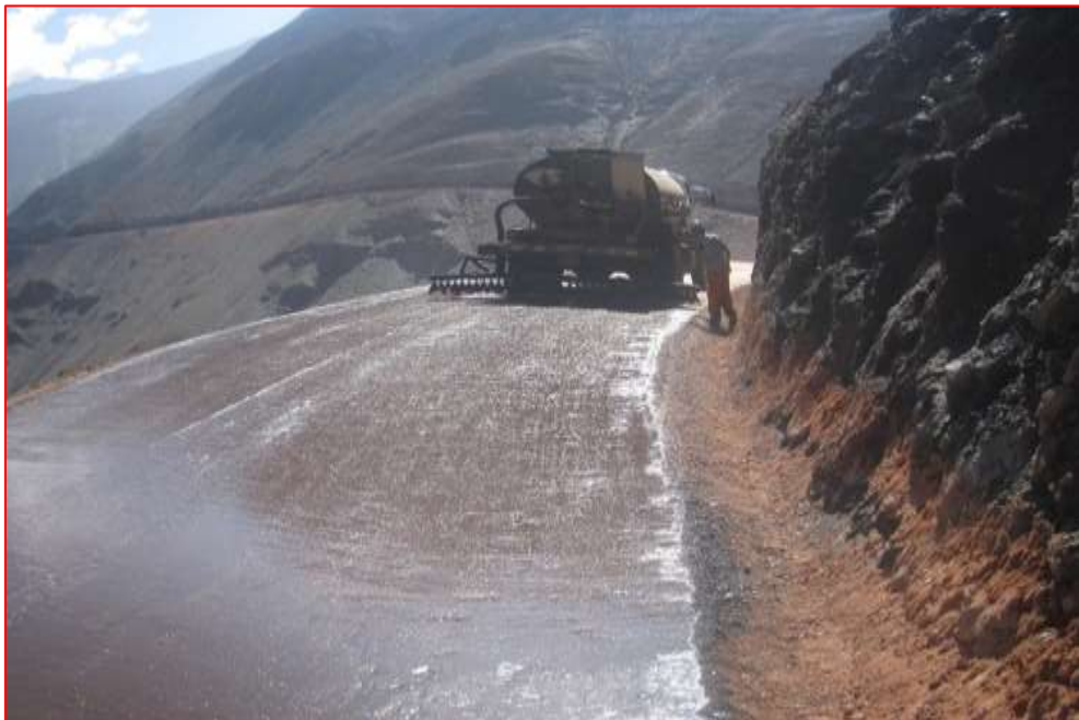
Fig. N°64. Arenado después de imprimación.
