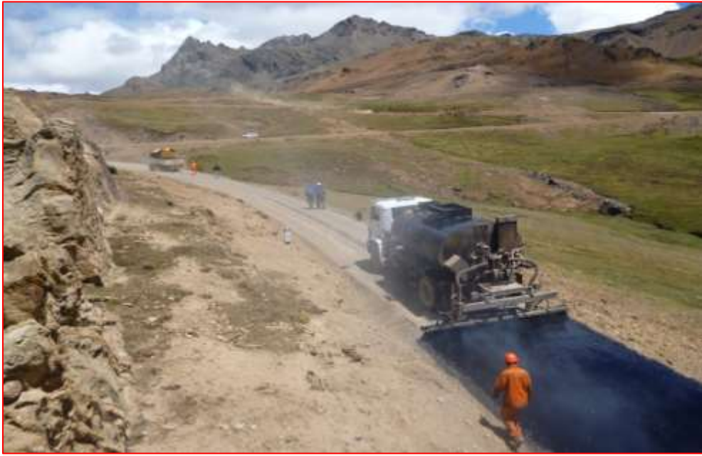
Fig. N°61. Aplicación de Emulsión/Imprimación
