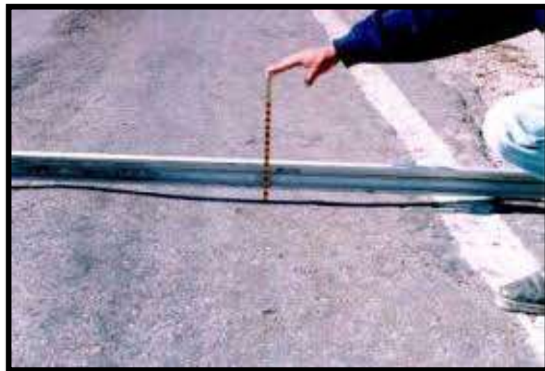
Figura 6: Medición de daño sobre la carpeta Fuente: Fuente Propia
