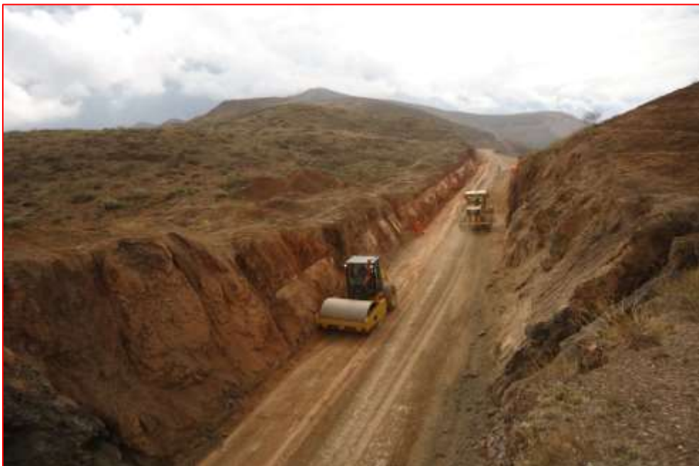
Fig. N°58. Perfilado y refinado en recarga de capa granular
