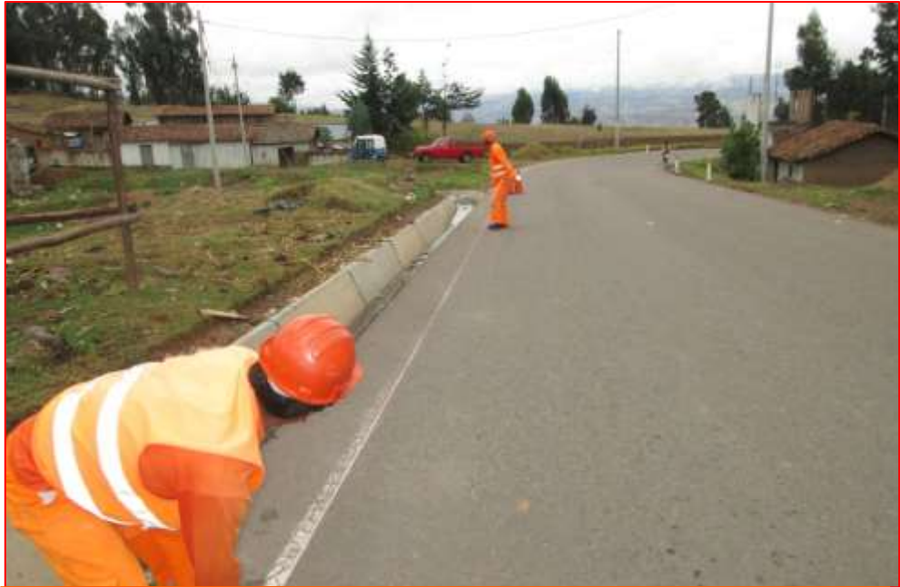
Fig. N°45. Repintado de señales
