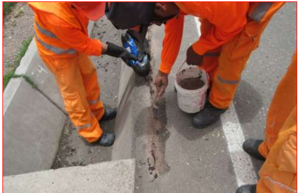
Fig. N°28. Bacheo asfáltico
