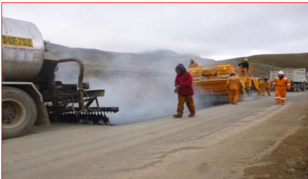
Fig. N°66. Aplicación de Sello Asfáltico
