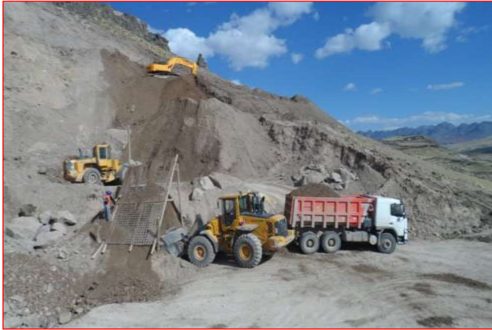
Fig. N°49. Producción de Material para recarga granular
