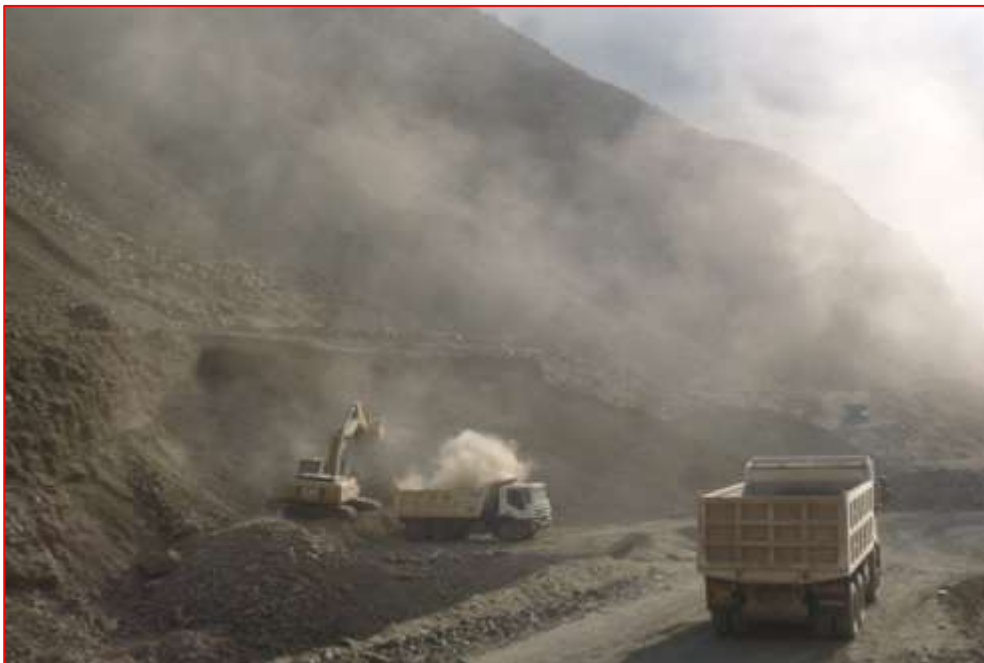
Fig. N°48. Extracción de Material para recarga granular
