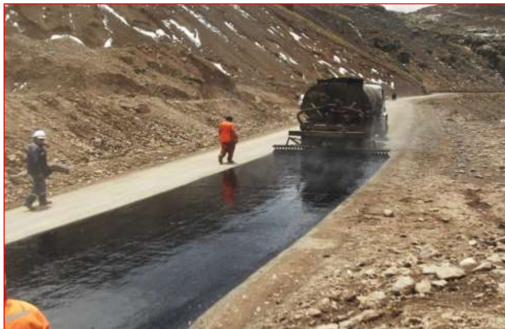
Fig. N°62. Aplicación de Emulsión/Imprimación
