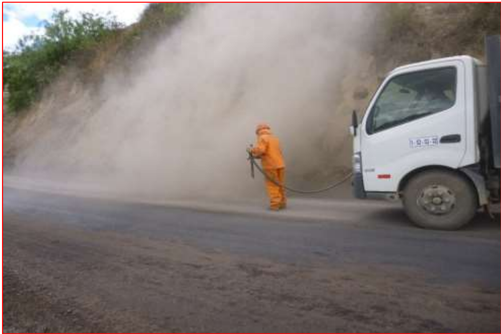
Fig. N°65. Limpieza de plataforma de carretera para aplicación de Sello Asfáltico
