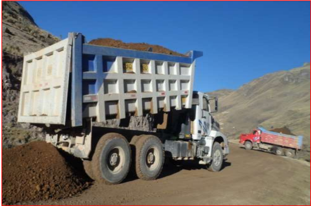
Fig. N°51. Carguío y transporte de Material Granular
