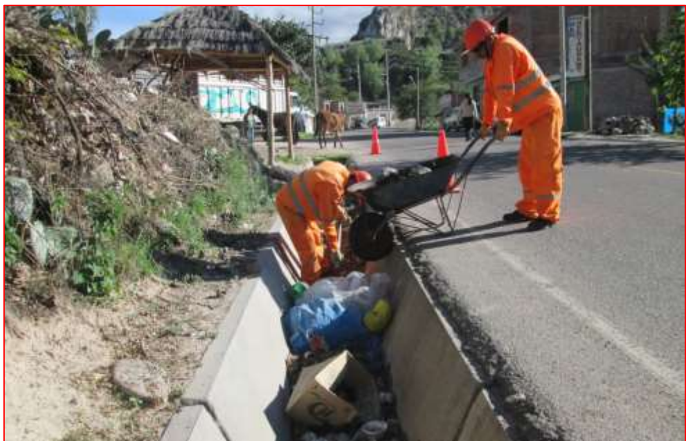
Fig. N° 40. Limpieza de cunetas
