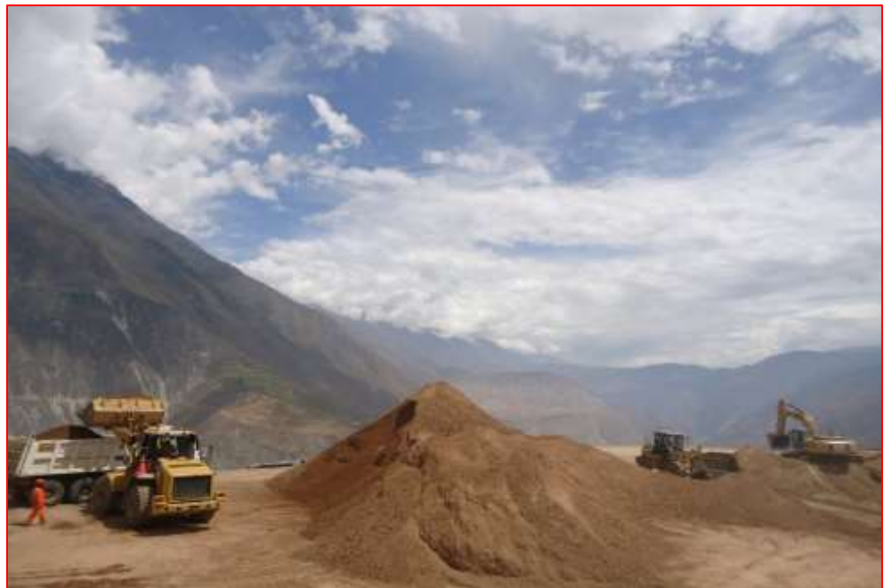
Fig. N°52. Carguío y transporte de Material Granular
