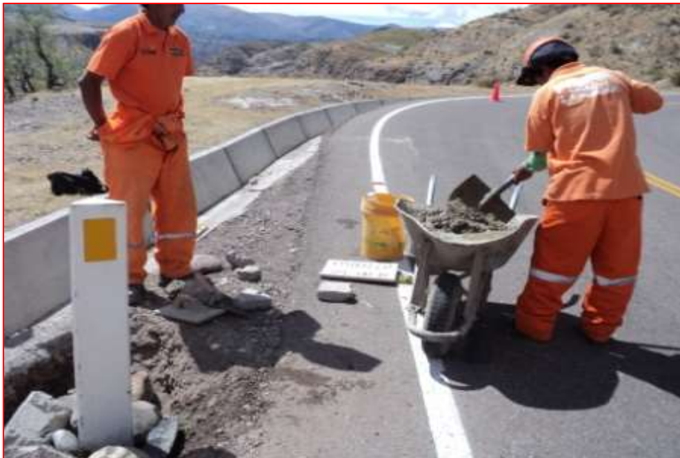
Fig. N°44. Repintado de señales
