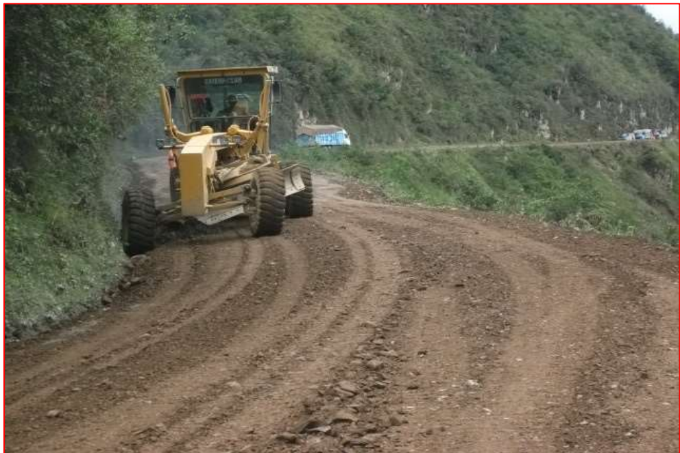
Fig. N°56. Perfilado y refinado en recarga de capa granular
