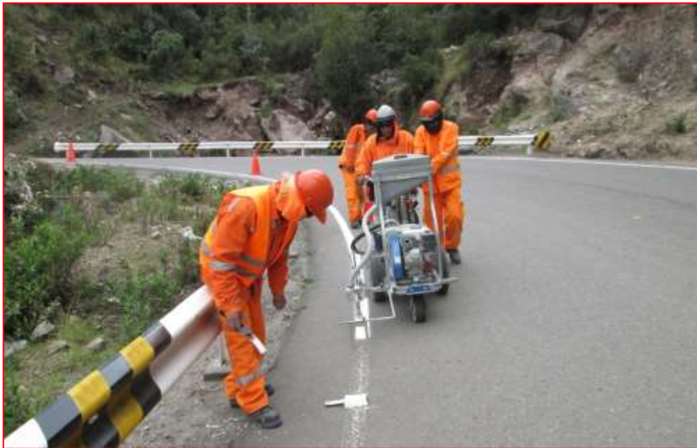
Fig. N°46. Repintado de señales
