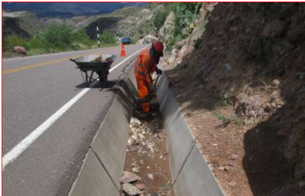
Fig. N° 38. Limpieza de cunetas
