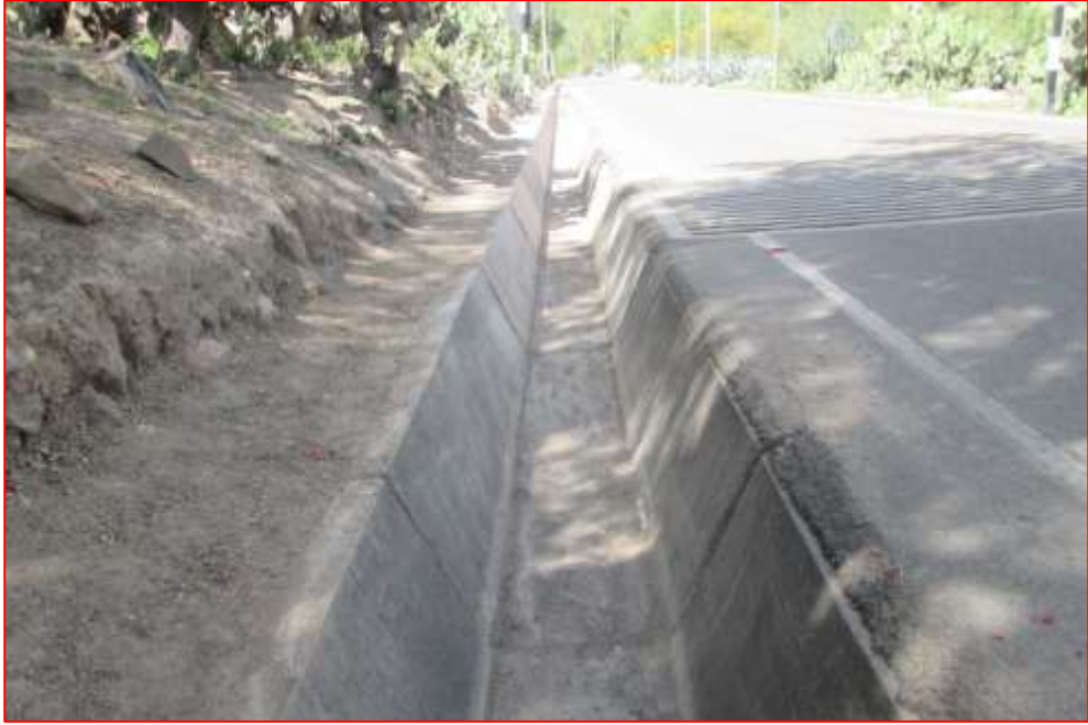
Fig. N°41. Limpieza de cunetas
