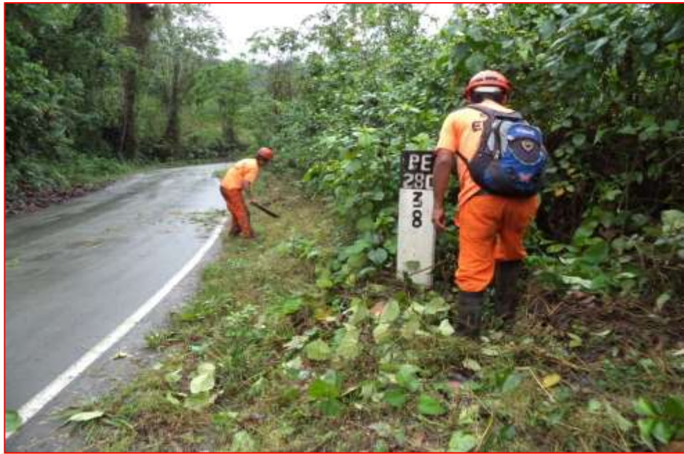
Fig. N°31. Desbroce de Maleza
