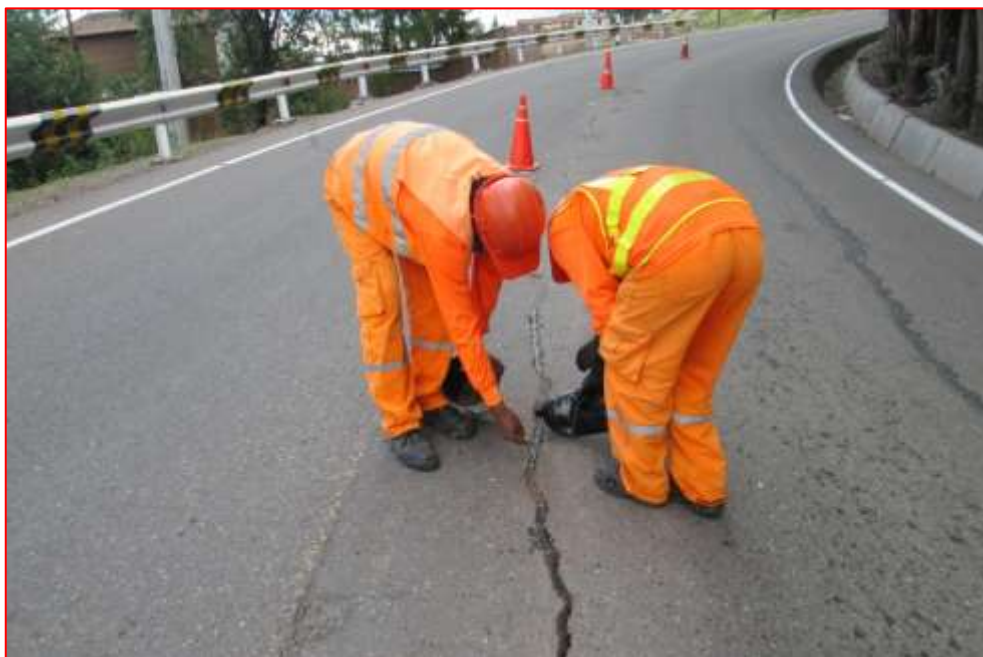
Fig. N°29. Bacheo asfáltico
