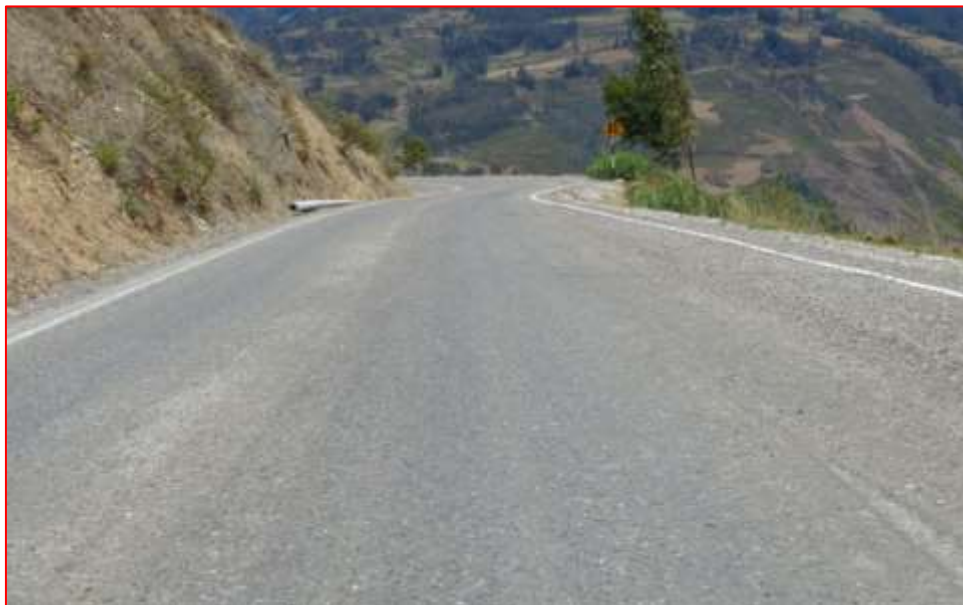
Fig. N°70. Acabado de Sello Asfaltico mas Gravilla
