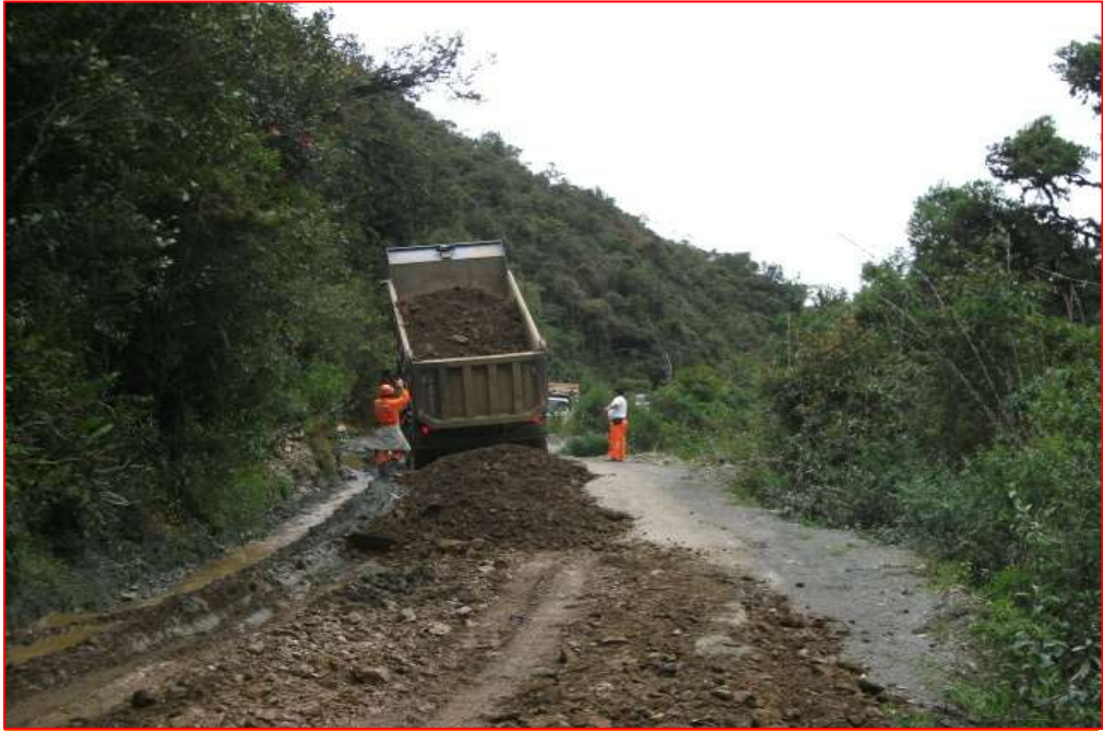
Fig. N°55. Colocación de Material Granular
