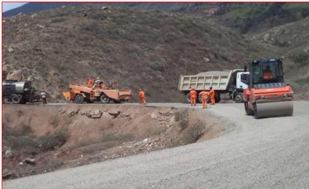
Fig. N°68. Compactado después de aplicación del Sello Asfaltico
