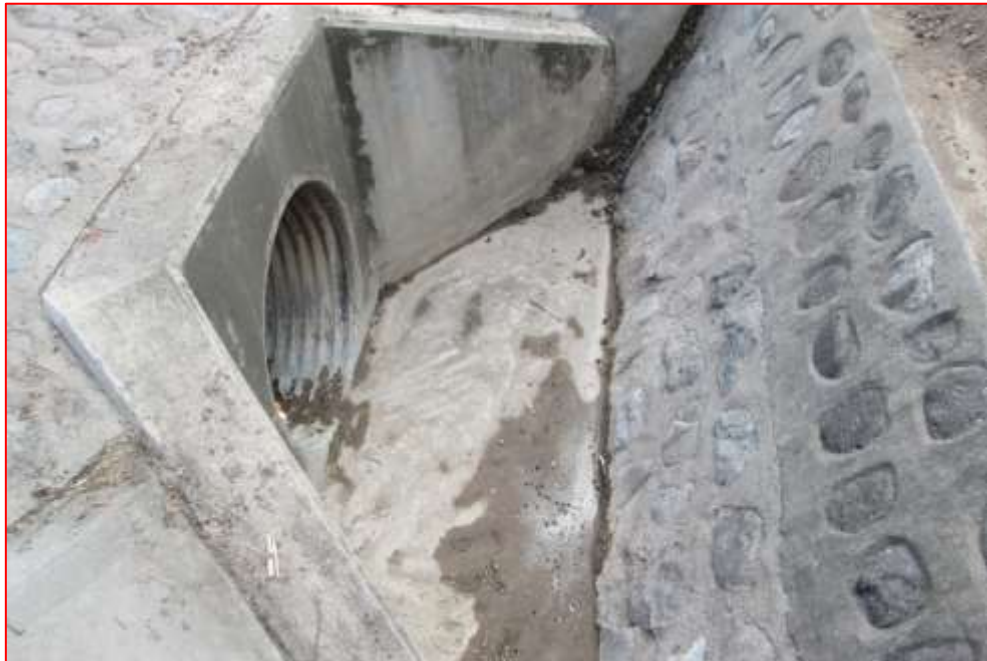
Foto N° 37. Limpieza de Alcantarilla
