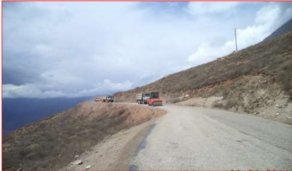
Fig. N°69. Compactado después de aplicación del Sello Asfaltico
