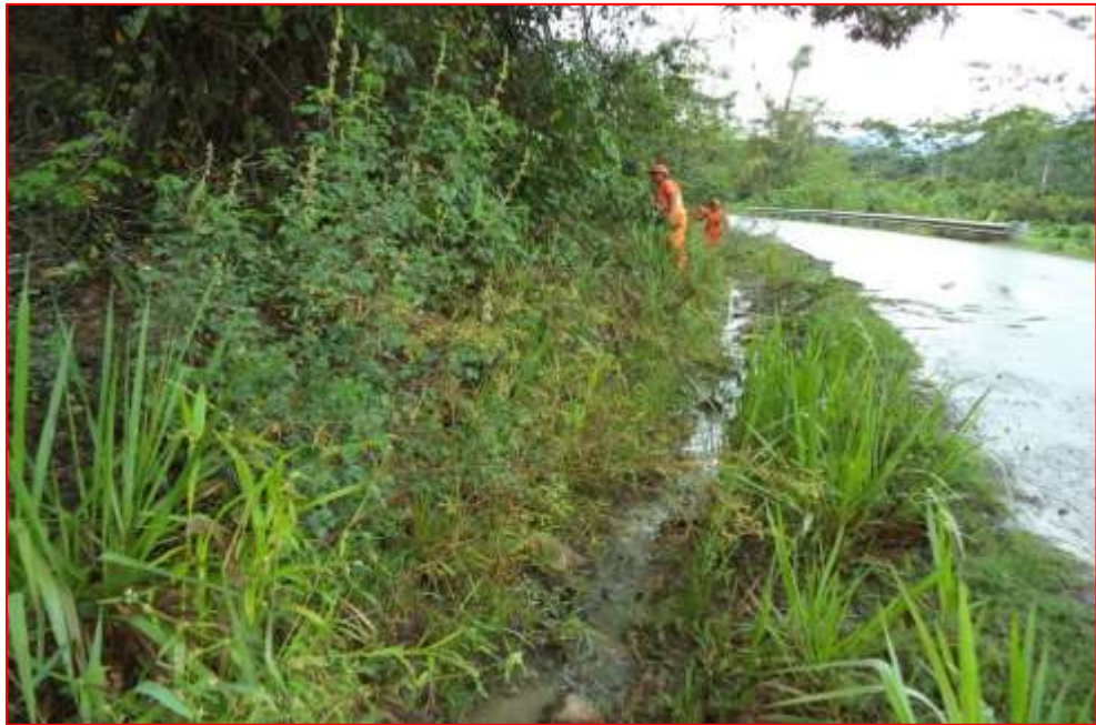
Fig. N°33. Desbroce de Maleza
