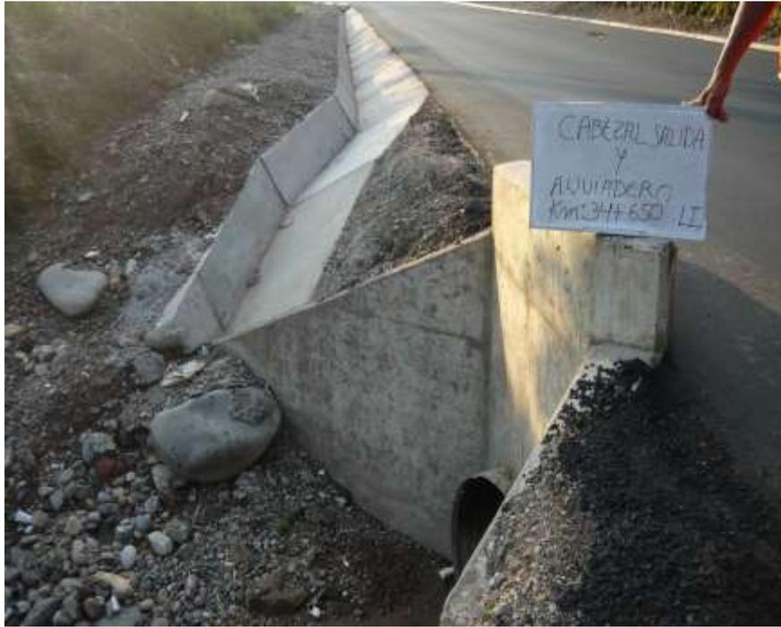
Figura 14. Cabezal de Salida, lado izquierdo.
