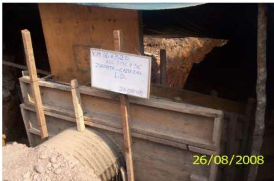
Figura 37. Fotografía en tiempo real, de la alcantarilla
