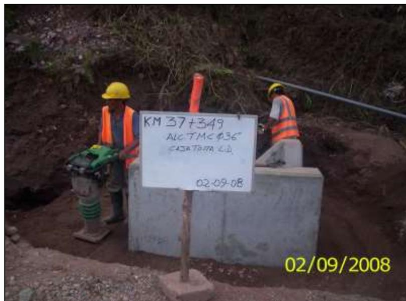
Figura 1. Estructura de entrada, Caja Toma.
