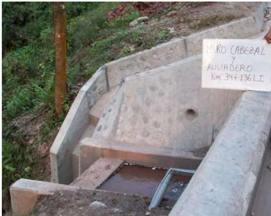
Figura 13. Muro Cabezal y aliviadero, lado izquierdo.
