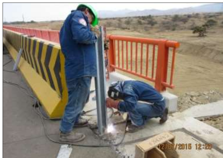
Figura 42.- Soldeo de poste a la placa de acero galvanizado.
