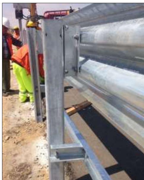
Figura 35.- Montaje de vigas triple onda sin torque final.
