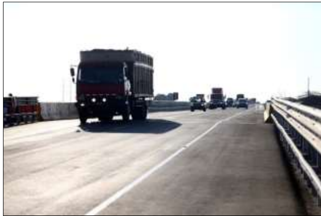
Figura 45.- Vista de barreras de seguridad y de transición/conexión operativas.
