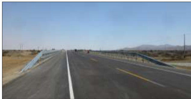
Figura 46.- Vista de terminales de barreras operativas.
