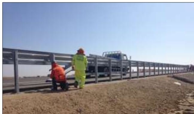
Figura 37.- Torque final de los elementos de barreras de contención o seguridad.
