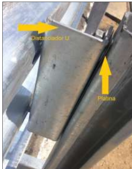
Figura 33.- Montaje de espaciadores y platina para viga triple onda.
