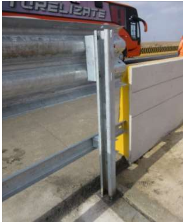
Figura 47.- Diferencia de altura en zona de transición y conexión.
