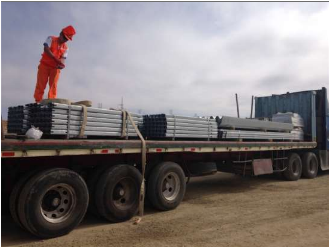
Figura 21.- Llegada a obra de elementos que conforman las barreras y terminales.
