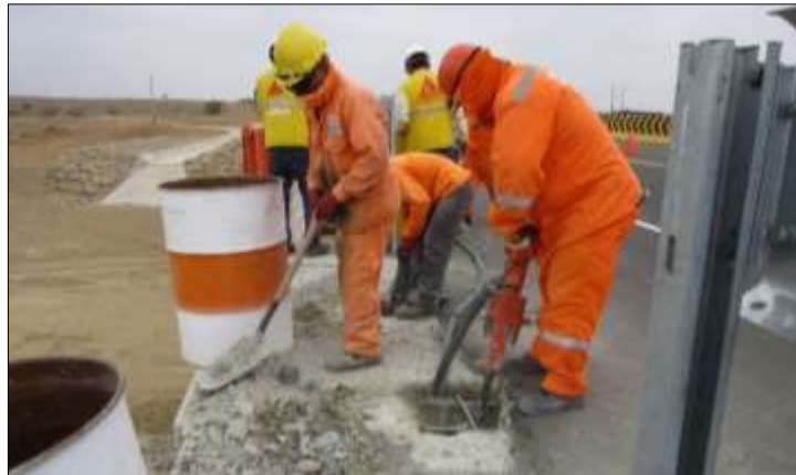
Figura 43.- Perforación de la losa del estribo del puente Manuela.
