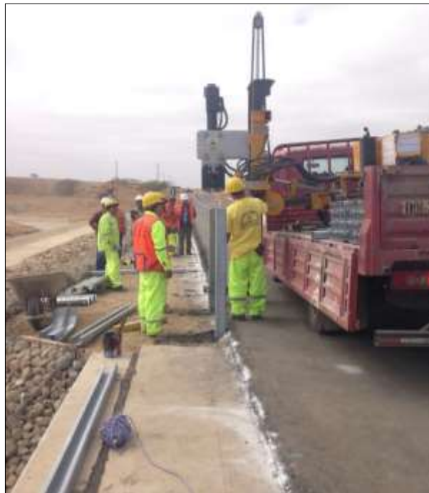
Figura 27.- Lineamiento 3 (equipo de hincado de postes).
