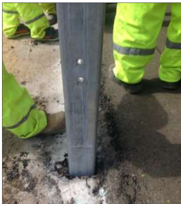
Figura 29.- Lineamiento 3 (marca de profundidad de hincado de poste).
