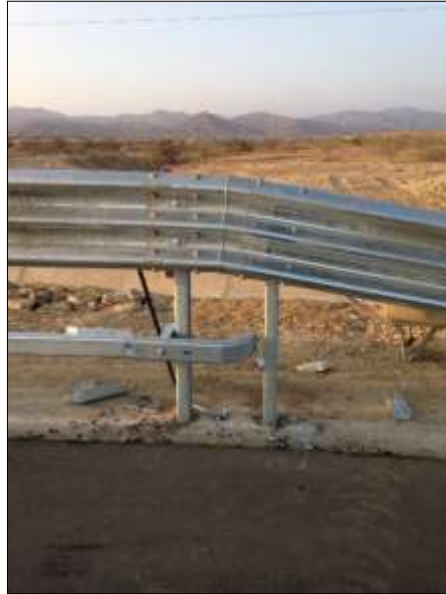
Figura 39.- Detalle de terminal de barrera (abatido simple).
