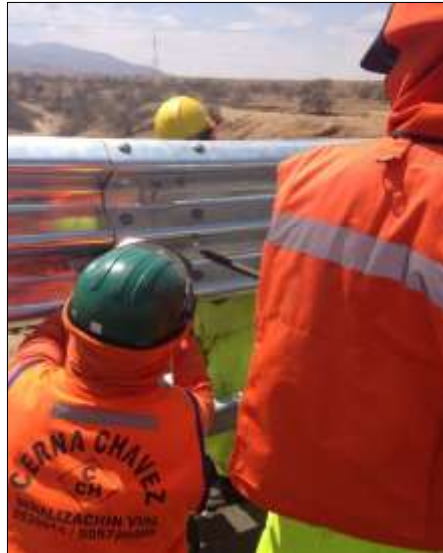
Figura 36.- Empalme de vigas triple onda.
