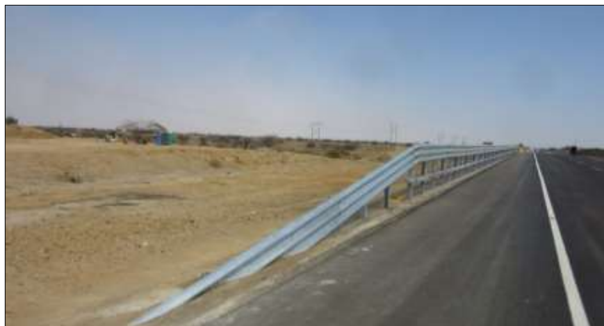
Figura 40.- Vista panorámica terminal de barrera (abatido simple).
