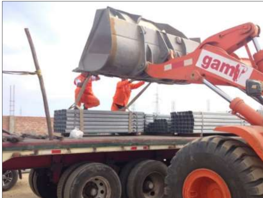
Figura 22.- Descarga de elementos que conforman las barreras y terminales.
