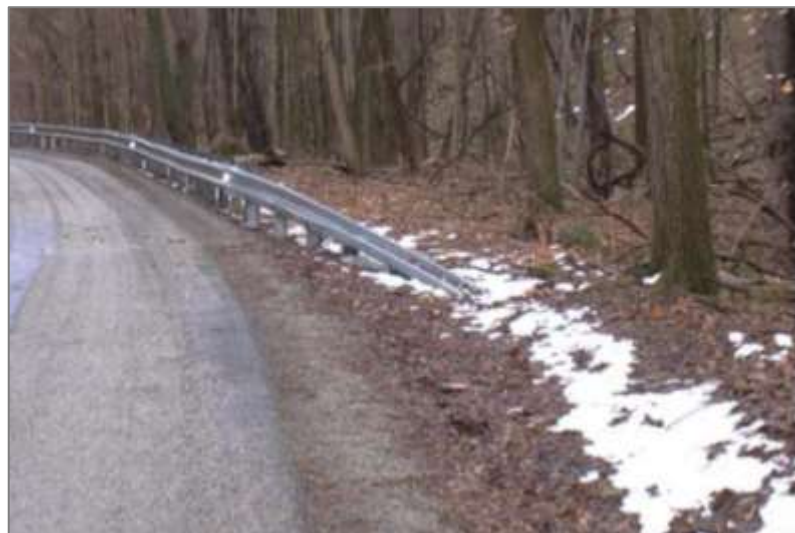
Figura 5.- Terminal Abatido Simple en una Carretera.
