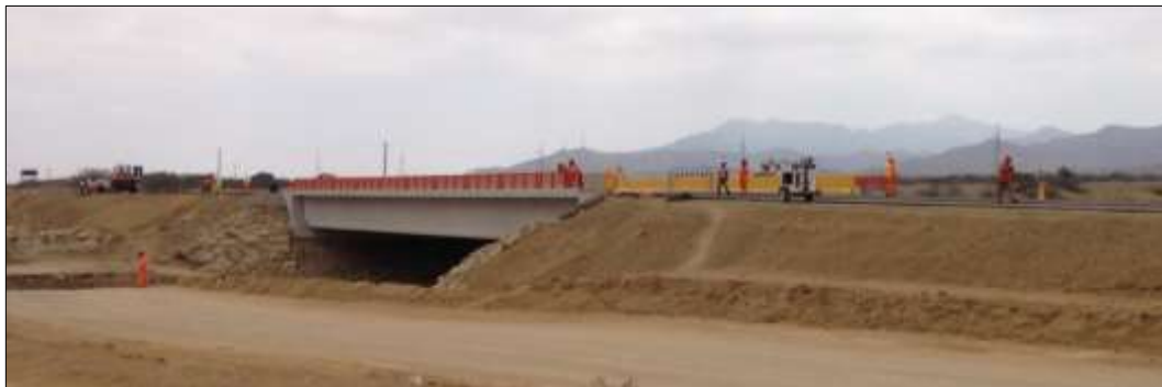
Figura 18.- Vista panorámica de la zona de trabajo.
