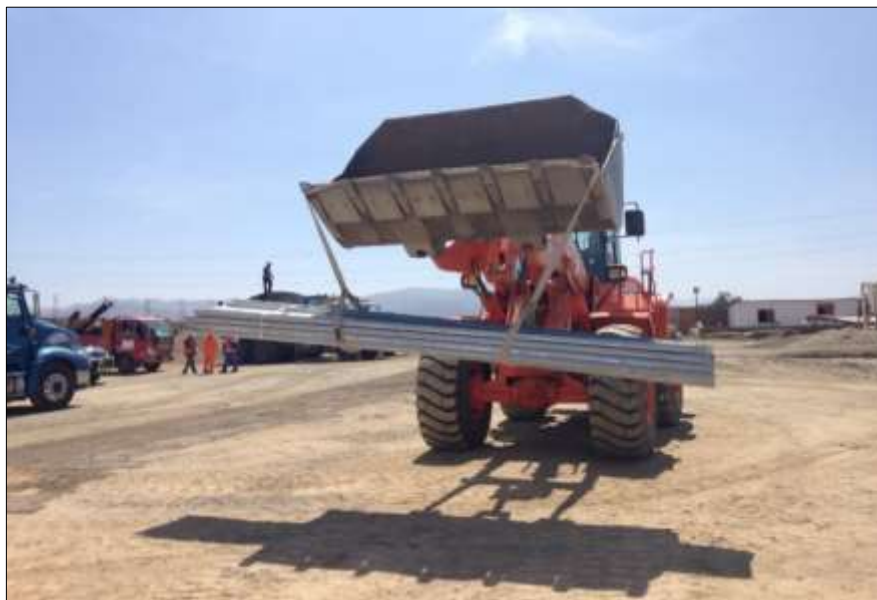
Figura 23.- Apilamiento de elementos que conforman las barreras y terminales.
