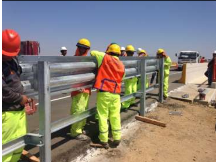
Figura 34.- Montaje de vigas triple onda sin torque final.
