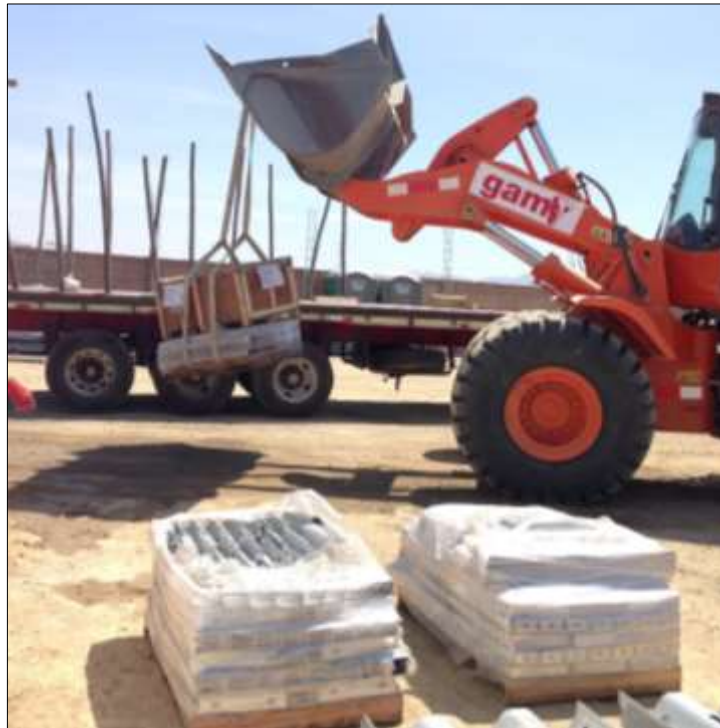
Figura 25.- Almacenamiento de elementos que conforman las barreras y terminales.
