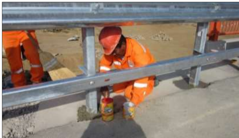
Figura 44.- Perforación de la losa del estribo del puente Manuela.
