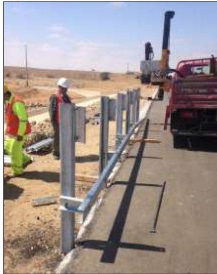
Figura 32.- Montaje de espaciadores y presentación de viga inferior.
