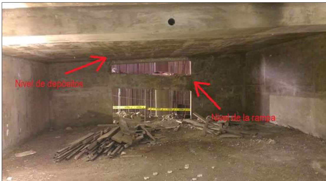
Figura N° 4.07: Foto real de solución de viga en rampa de estacionamientos. (FUENTE: Constructora Arcadia SAC)
