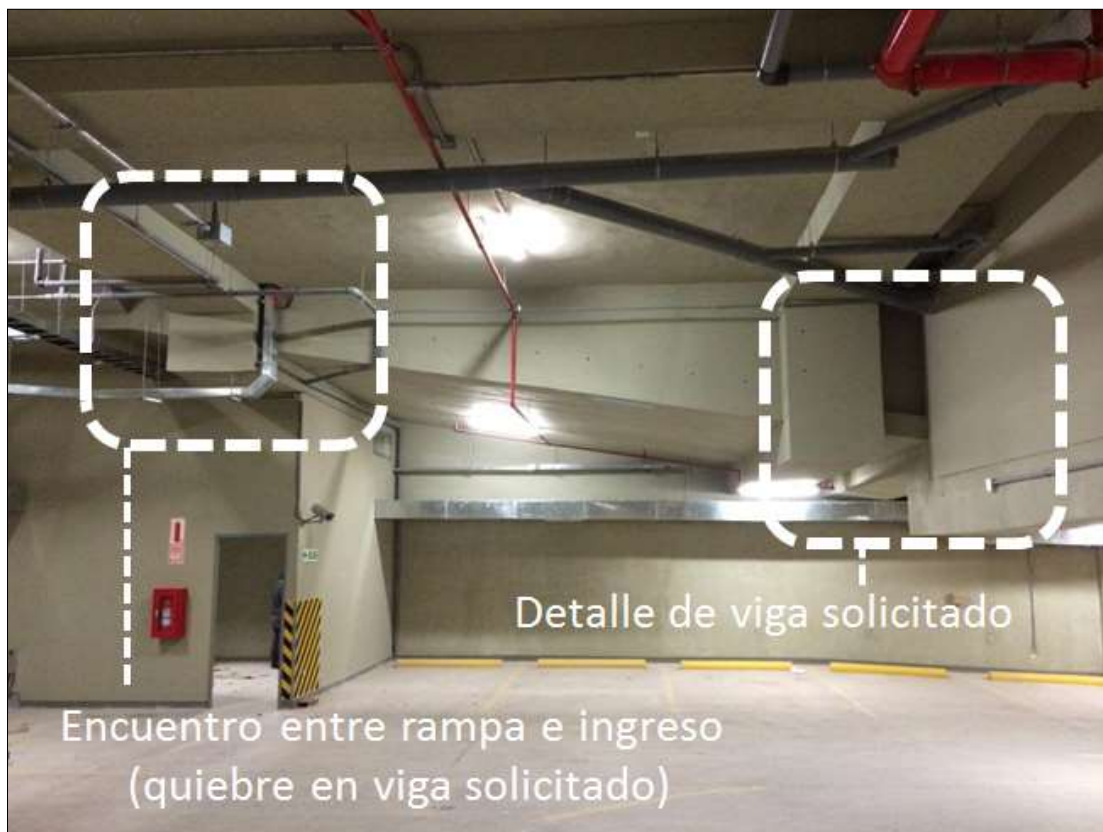
Figura N° 4.11: Foto real de detalle de viga en frizo de rampa en sótano. (FUENTE: Constructora Arcadia SAC)
