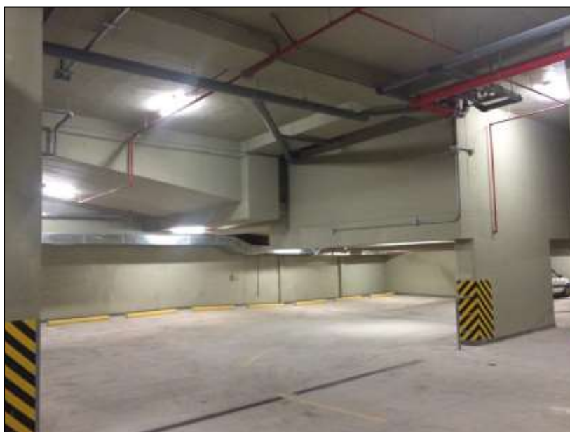
Figura N° 2.07: Vista Real del Sótano 1 – Proyecto Pacific Tower.
