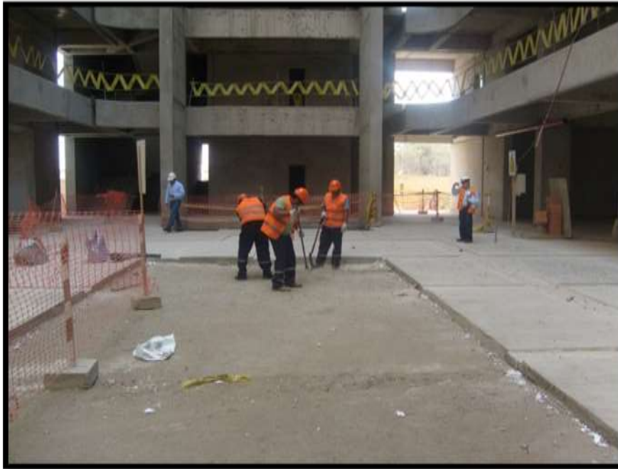
Figura Nro.14- Fuente: Imagen de Calicata realizada por el Ing. Rivasplata.
