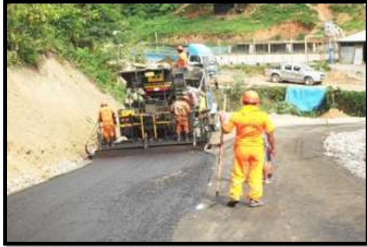
Foto N° 57. Aplicación del Slurry Seal con MacroPaver.
