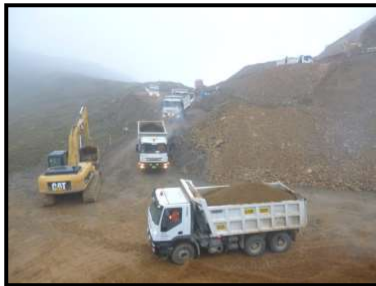
Foto N° 46. Transporte de material granular
