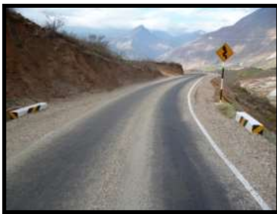
FIGURA N° 28 PRESENCIA DE EXUDACION
