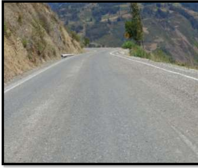
Foto N° 39. Acabado de OTTA SEAL
