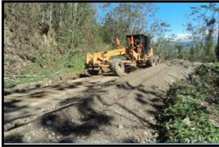
Foto N° 49. Batido de material para base estabilizada.
