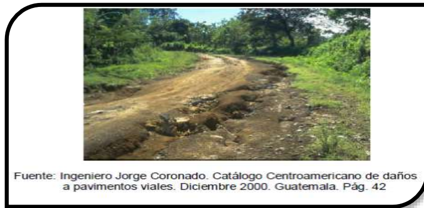
FIGURA N° 3 DRENAJE INADECUADO
