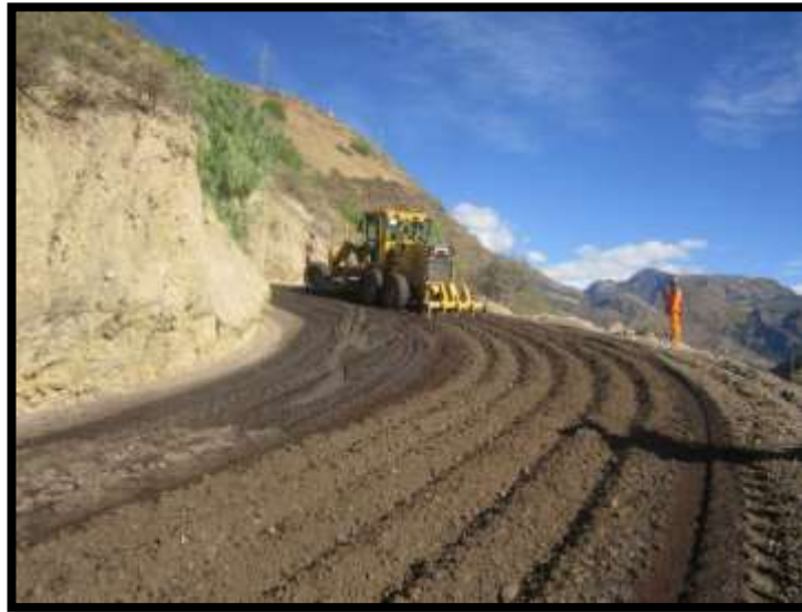
Foto N° 50. Batido de material
