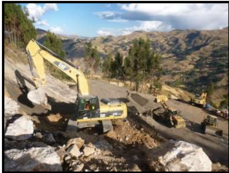
Foto N° 42. Extracción de material integral para capa granular.
