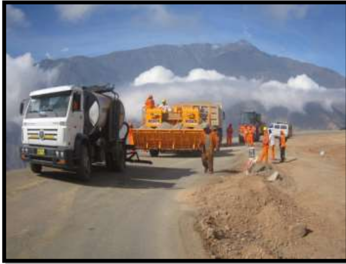
Foto N° 33. Se aprecia TREN DE ASFALTO
