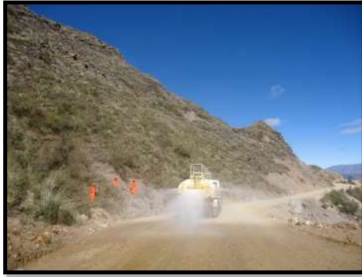
Foto N° 45. Riego de subrasante antes de la descarga de material granular.
