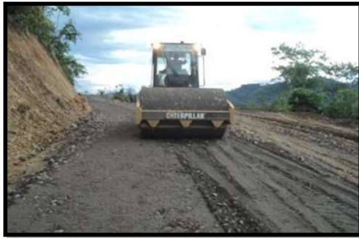
Foto N° 52. Compactación de base estabilizada
