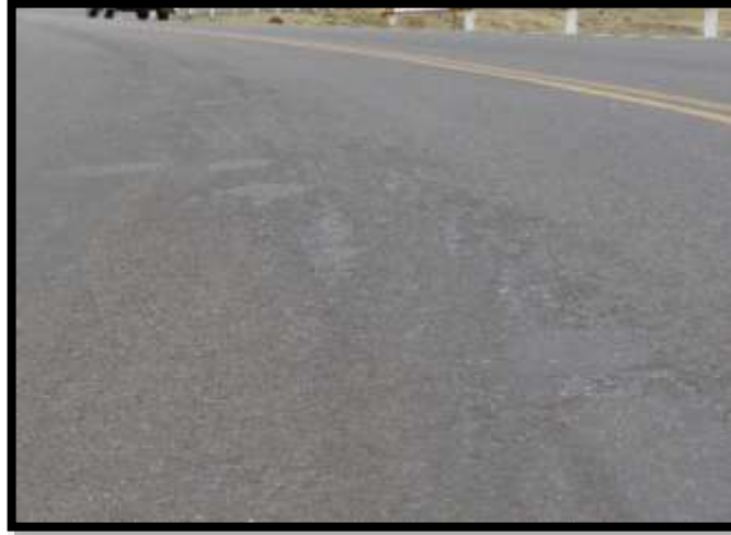
Foto N° 65. Plataforma después del curado.
