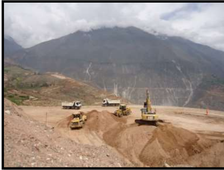
Foto N° 07. Carguío y transporte de material granular.
