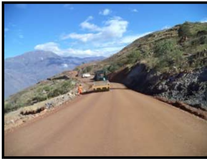
Foto N° 24. Compactado de capa material granular.
