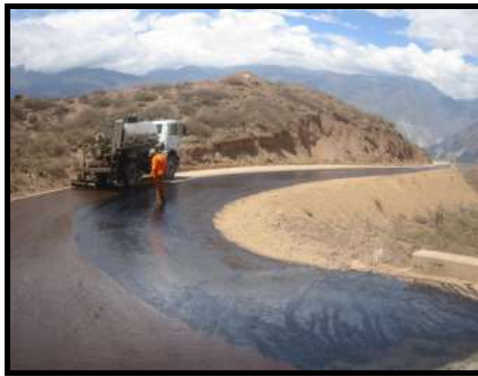
Foto N° 26. Riego asfáltico/imprimación.
