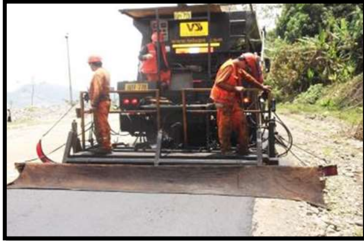
Foto N° 59. Aplicación del Slurry Seal con MacroPaver.
