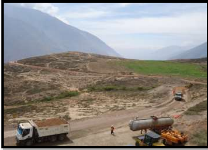
Foto N° 11. Transporte de material granular.
