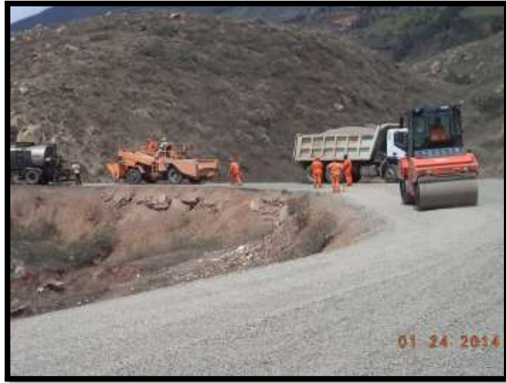
Foto N° 35. Compactado después de aplicación del OTTA SEAL
