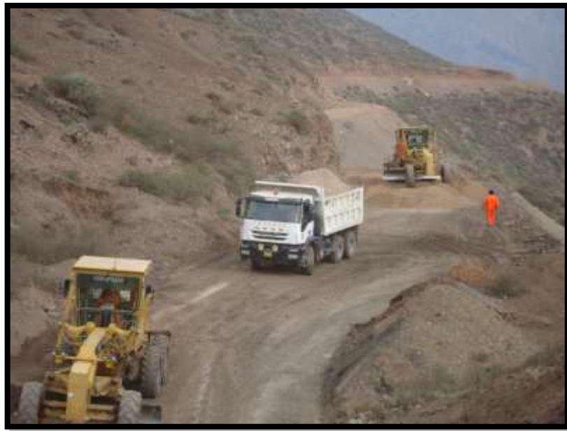
Foto N° 14. Descarga de material granular.
