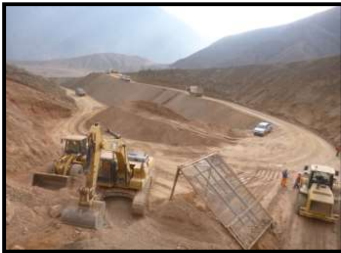
Foto N° 02. Extracción de material para capa granular.
