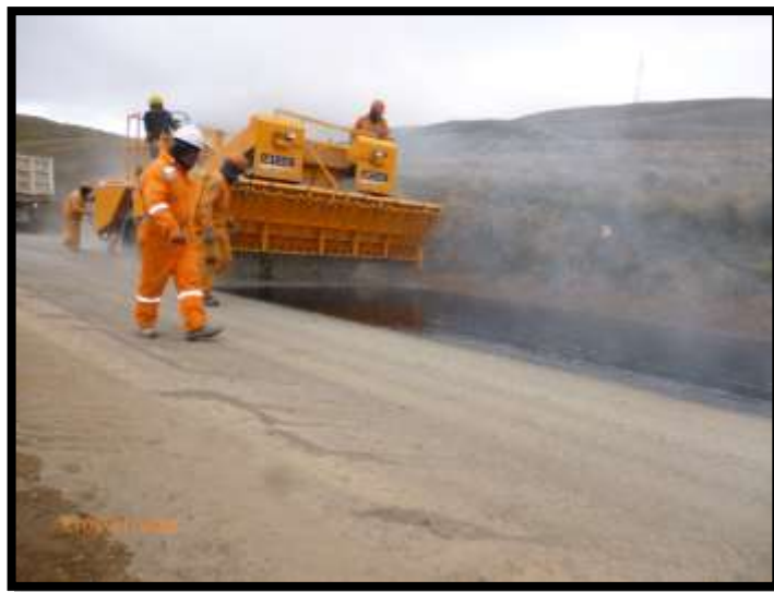
Foto N° 32. Aplicación de OTTA SEAL
