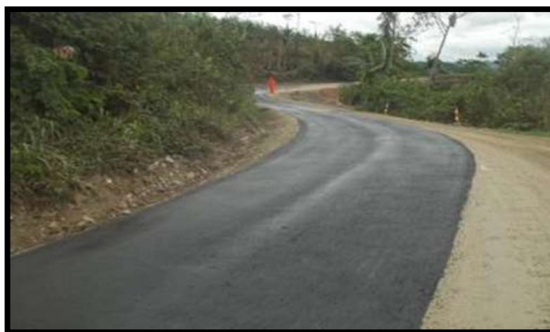
Foto N° 62. Calzada con tratamiento Slurry Seal
