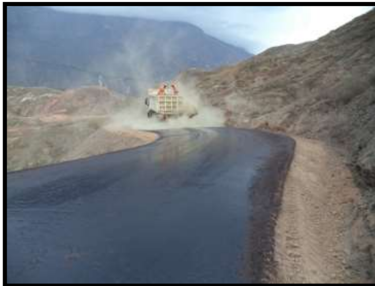
Foto N° 28. Arenado después de imprimación.
