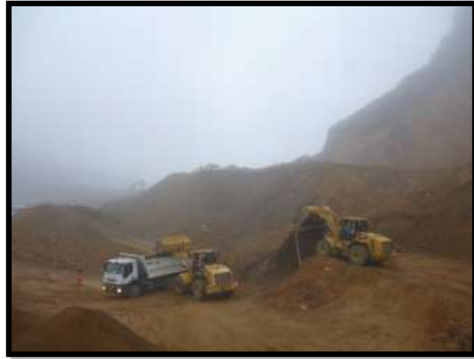
Foto N° 43. Producción de material para capa granular
