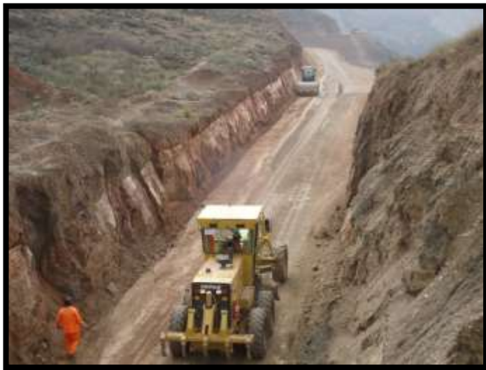
Foto N° 18. Pre compactado después del batido de material granular.
