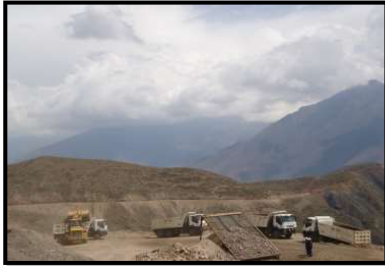
Foto N° 03. Eliminación de material excedente hacia al botadero.
