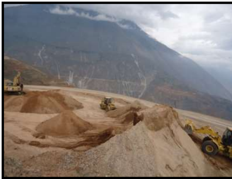
Foto N° 06. Producción de material para capa granular.
