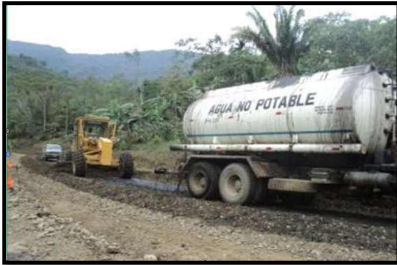
Foto N° 48. Riego de emulsión en la base para batir con motoniveladora
