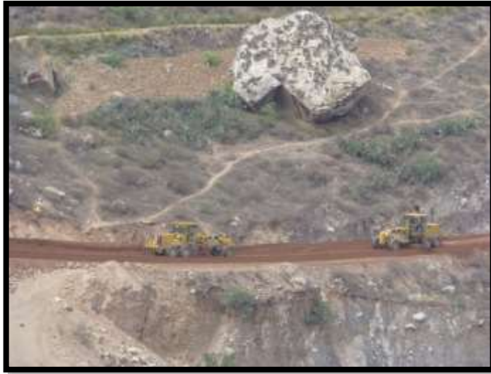
Foto N° 17. Mezclado y batido de material granular.
