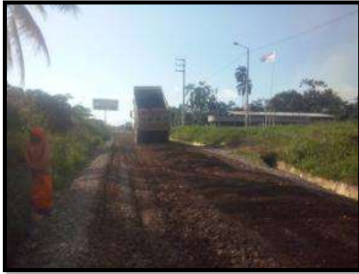
Foto N° 47. Descarga de material granular con volquete.
