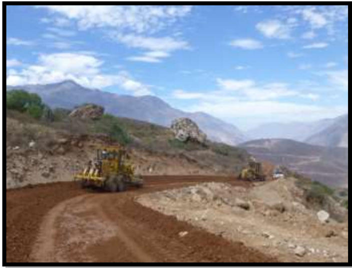
Foto N° 16. Mezclado y batido de material granular.
