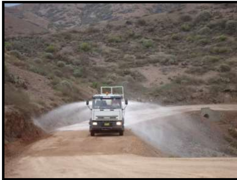
Foto N° 10. Riego de la subrasante antes de la descarga de material granular.
