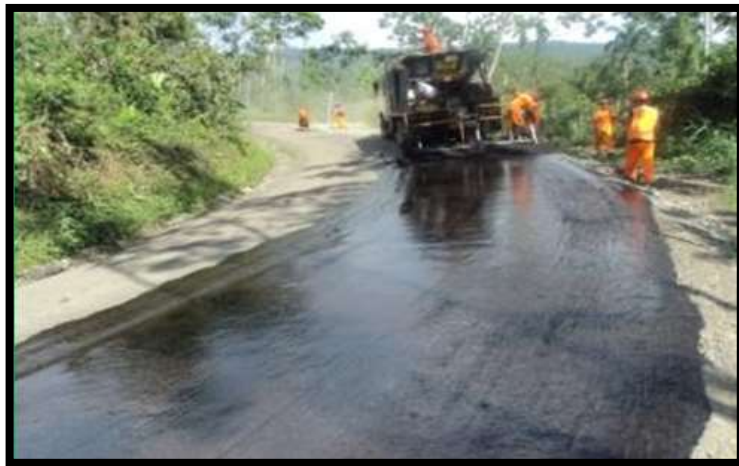
Foto N° 60. Riego de Slurry Seal con MacroPaver.
