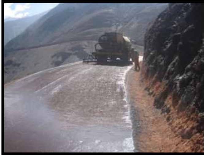
Foto N° 27. Riego asfáltico/imprimación.
