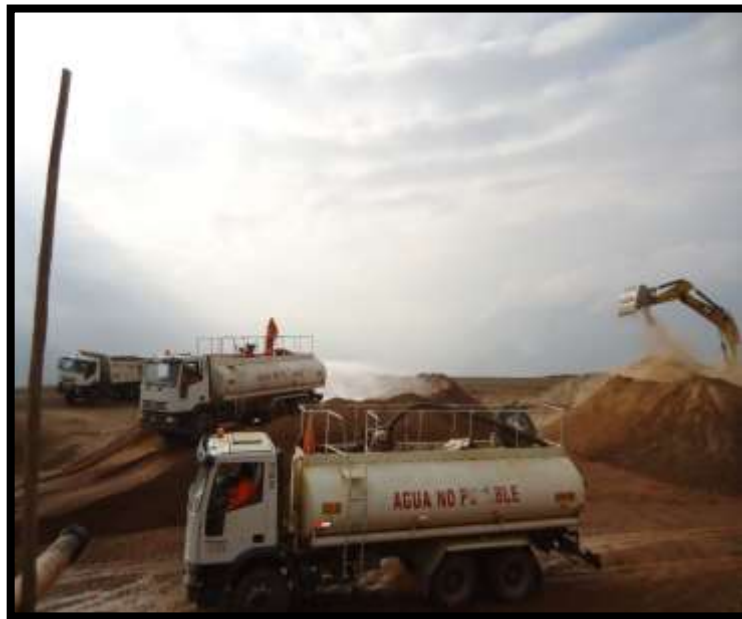
Foto N° 04. Producción de material para capa granular.
