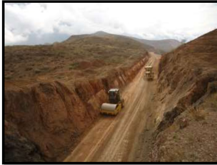
Foto N° 23. Perfilado y refinado en recarga de capa granular.
