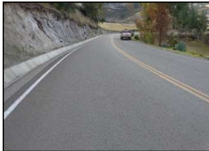
Foto N° 66. Acabado de Slurry Seal en el tramo de estudio
