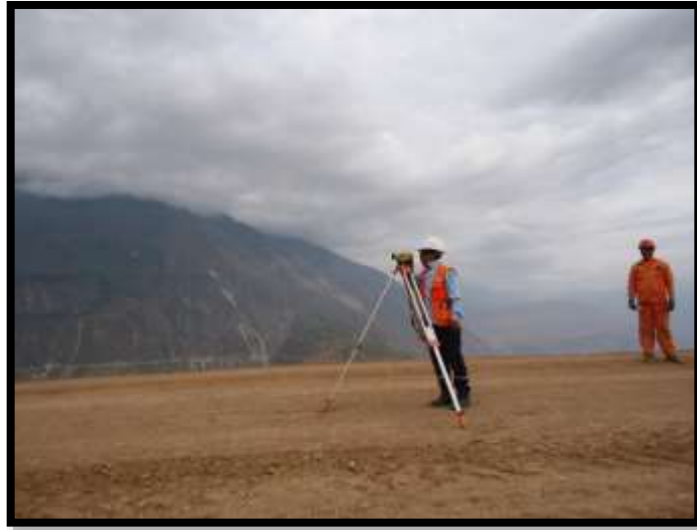
Foto N° 19. Plantillado en capa de base granular.
