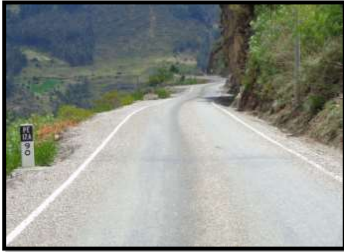
Foto N° 37. Curado de OTTA SEAL
