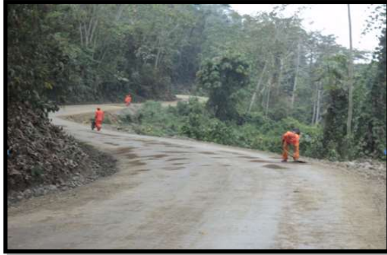
Foto N° 53. Base estabilizada con emulsión.
