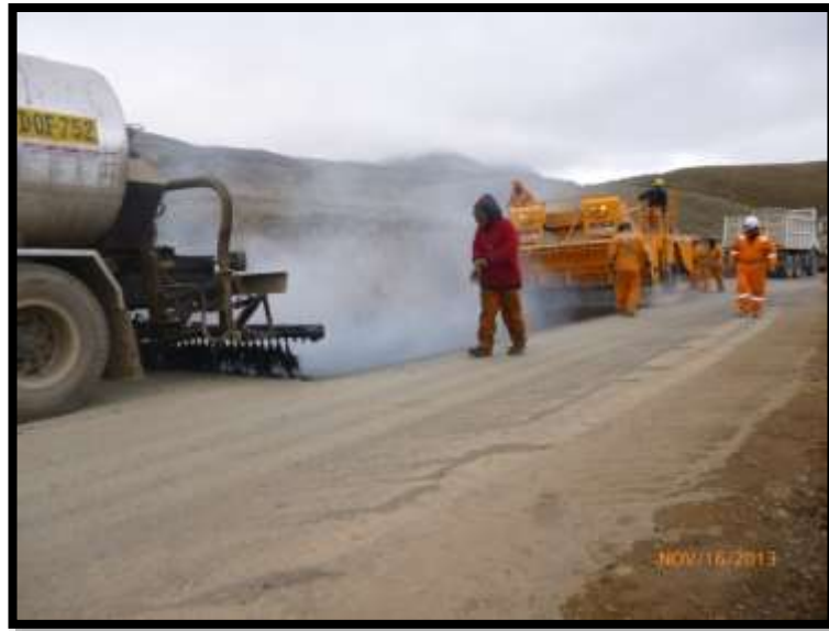
Foto N° 31. Aplicación de OTTA SEAL
