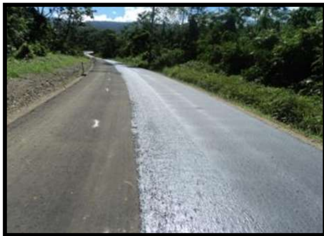
Foto N° 63. Calzada con tratamiento Slurry Seal
