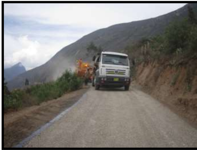
Foto N° 34. Se aprecia TREN DE ASFALTO
