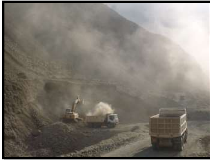
Foto N° 01. Extracción de material para capa granular.
