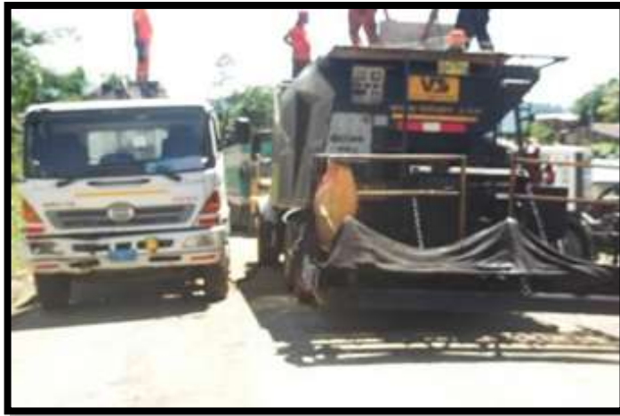
Foto N° 56. Llenado de Material al Macropaver para aplicar Slurry Seal
