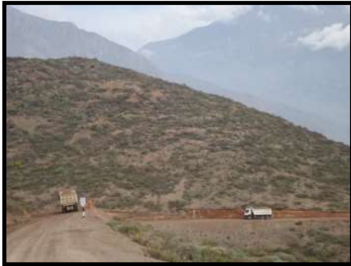
Foto N° 12. Transporte de material granular.
