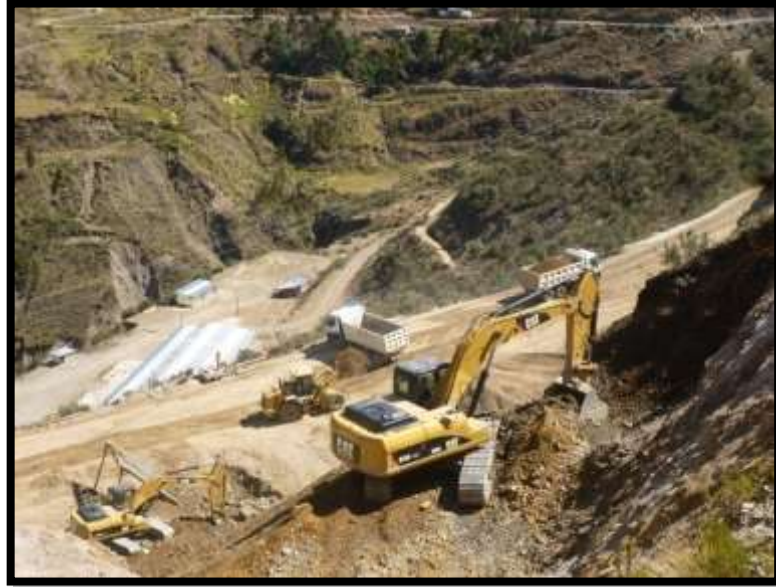
Foto N° 41. Extracción de material integral para capa granular.
