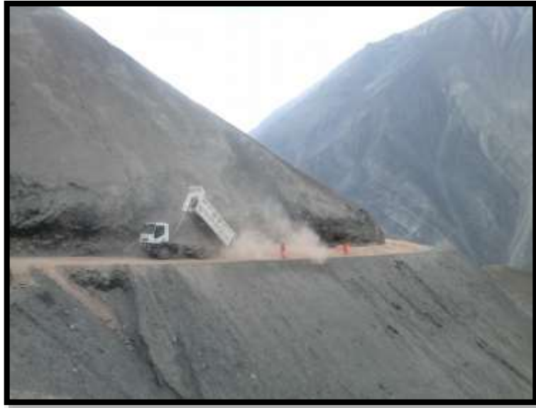
Foto N° 13. Descarga de material granular.
