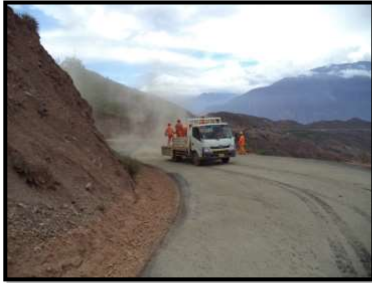
Foto N° 29. Arenado después de imprimación.
