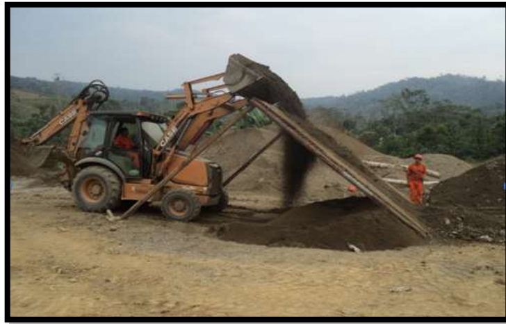
Foto N° 54. Producción de Material para Slurry Seal
