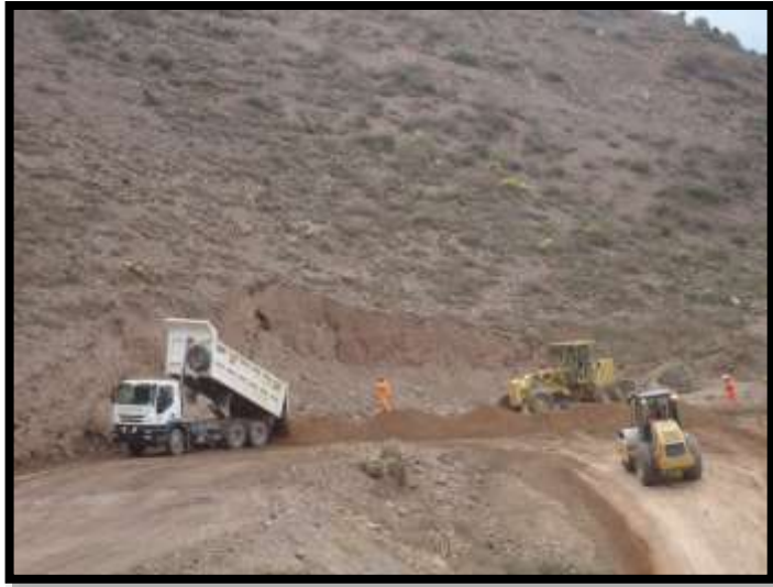
Foto N° 15. Descarga y extendido de material granular.
