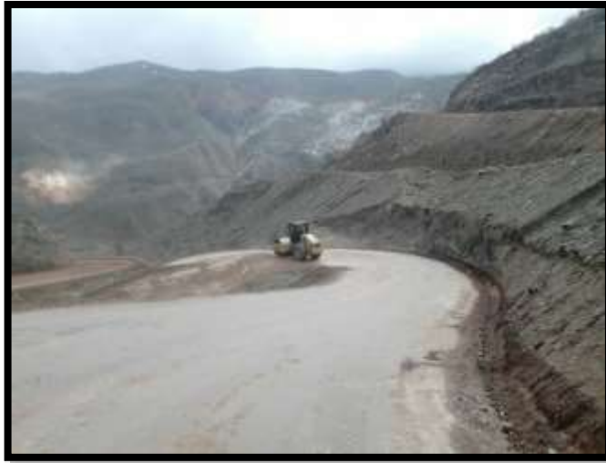
Foto N° 25. Compactado de capa material granular.
