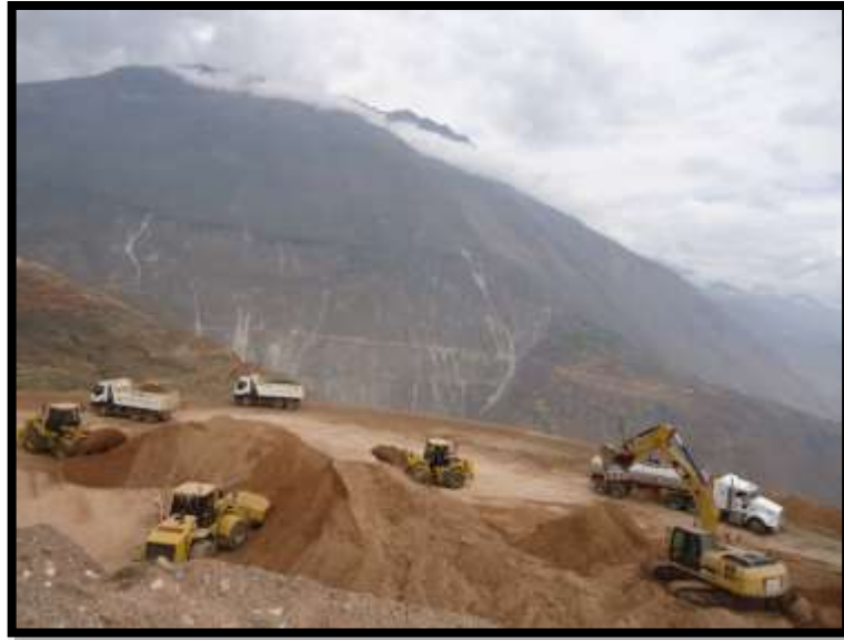
Foto N° 09. Carguío y transporte de material granular.
