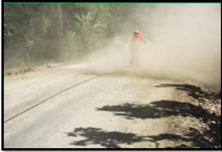
Foto N° 55. Limpieza de base para aplicación de Slurry Seal.
