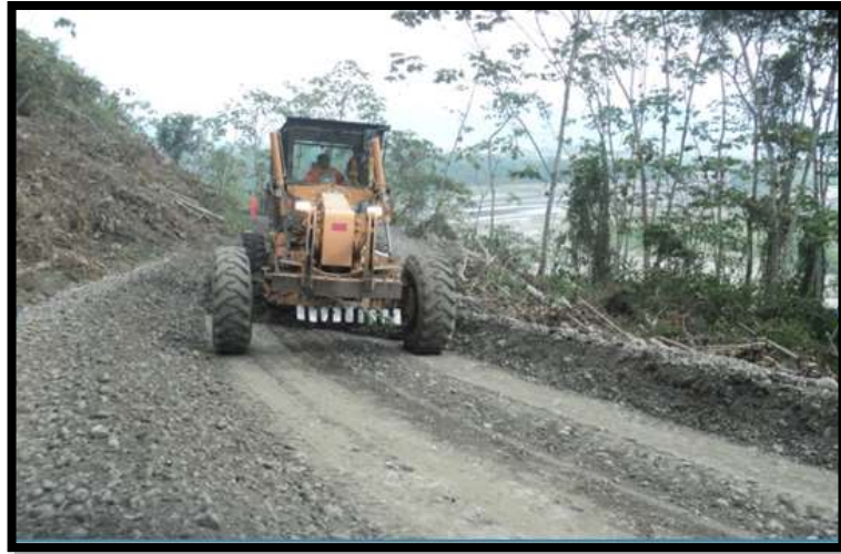
Foto N° 51. Batido de material.
