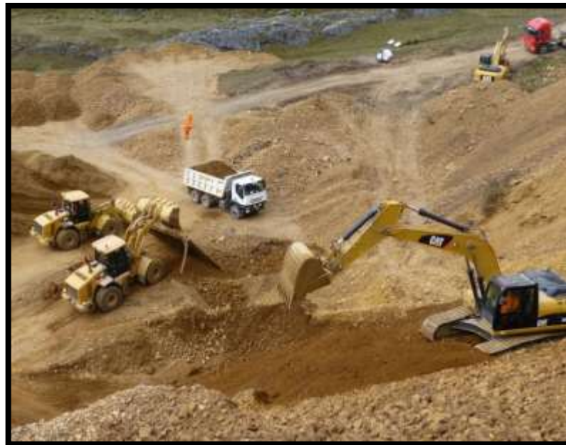
Foto N° 44. Producción de material para capa granular
