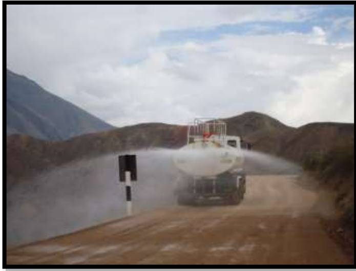
Foto N° 21. Riego en material granular durante la conformación.
