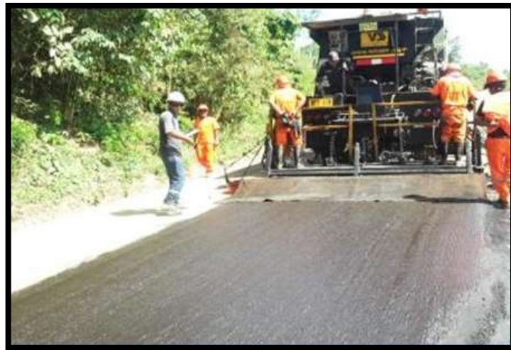
Foto N° 58. Aplicación del Slurry Seal con MacroPaver.
