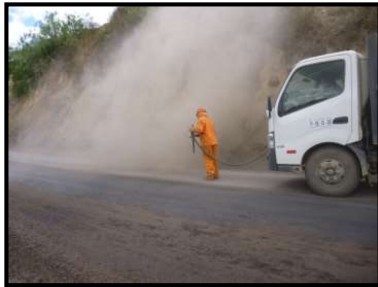
Foto N° 30. Limpieza de plataforma de carretera para aplicación de OTTA SEAL
