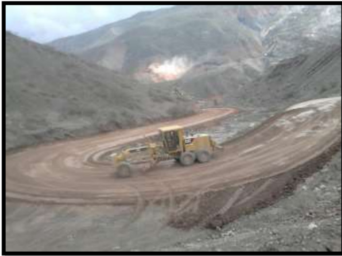
Foto N° 22. Perfilado y refinado en recarga de capa granular.
