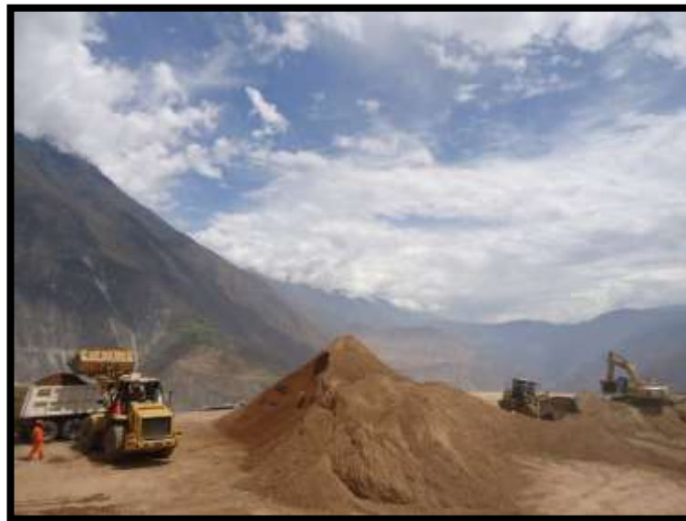
Foto N° 08. Carguío y transporte de material granular.
