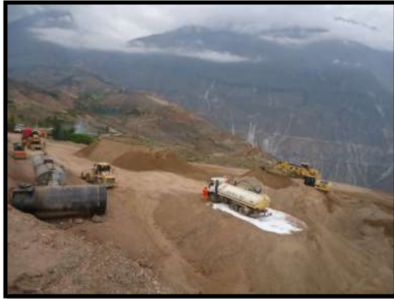
Foto N° 05. Producción de material para capa granular
