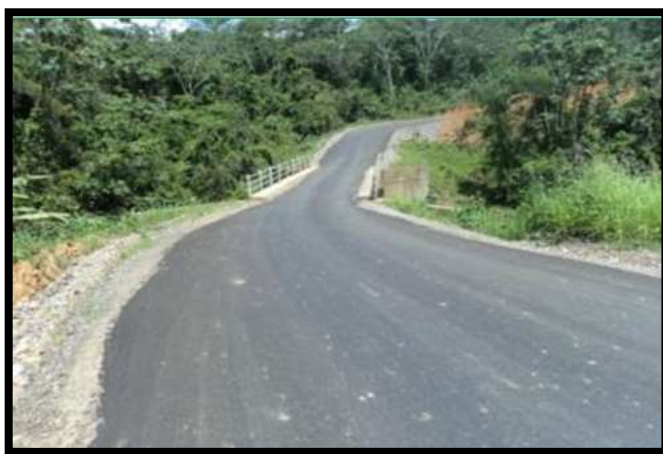
Foto N° 64. Calzada con tratamiento Slurry Seal
