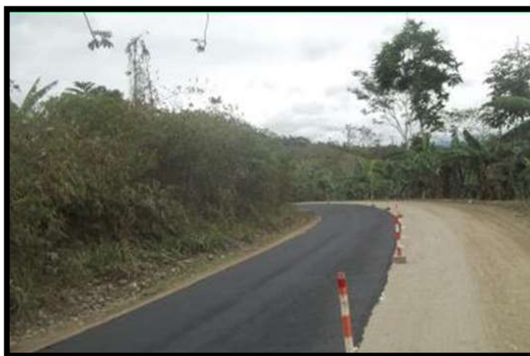
Foto N° 61. Calzada con tratamiento Slurry Seal
