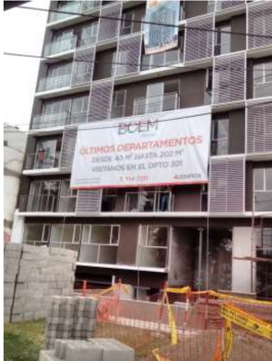
Foto N° 3 Fachada del edificio con material para los últimos acabados.
