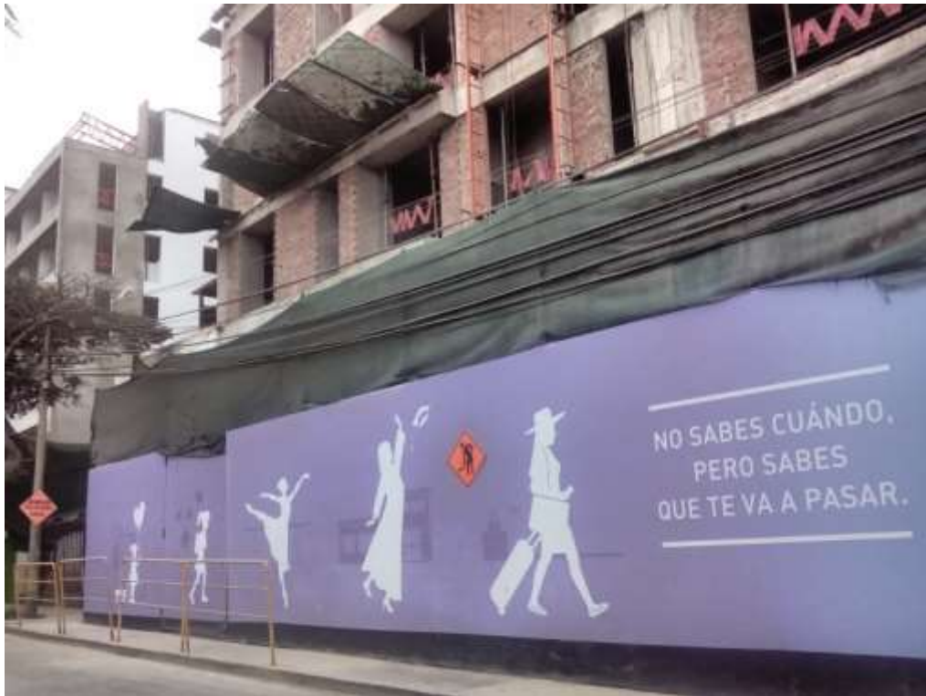
Foto N° 1 Cerco perimétrico y el edificio aún en construcción.
