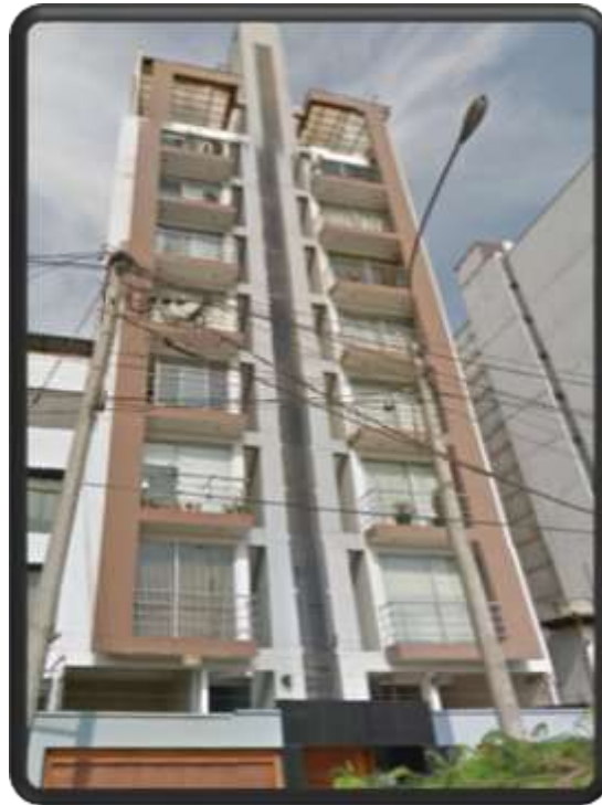
Figura 41: Vista Real - Edificio de 8 pisos.
