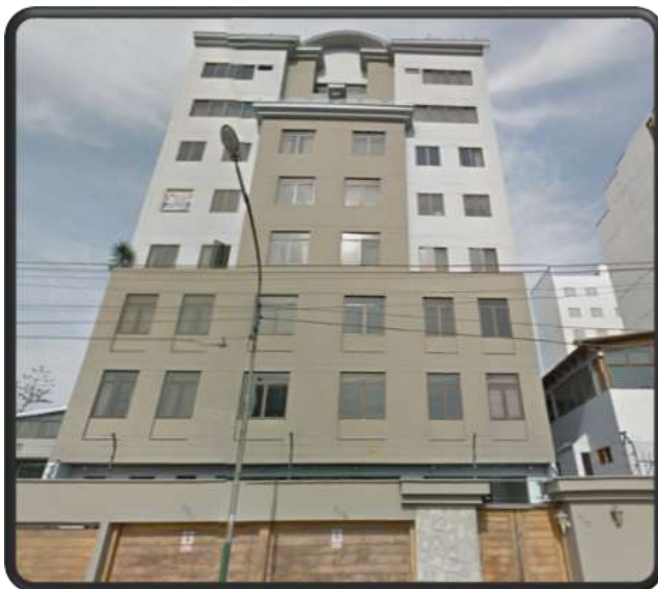
Figura 47: Vista Real - Edificio de 8 pisos y azotea.
