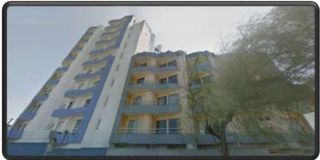
Figura 53: Vista Real - Edificio de 14 pisos.
