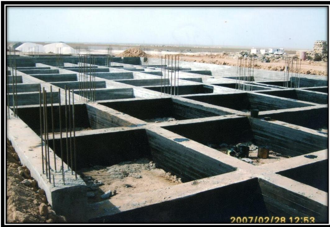
Foto 35: Edificio de Control. Cimentación corrida finalizada.
