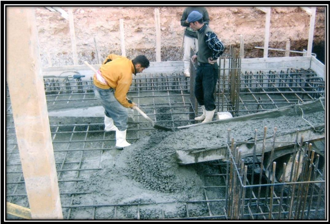
Foto 28: Vaciado de Concreto del Seccionador.
