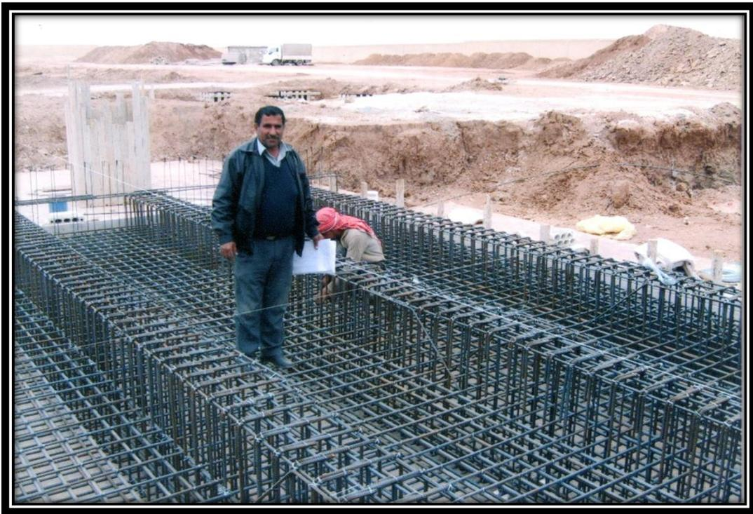
Foto 17: Estructura de fierro de la base del Transformador de Potencia.
