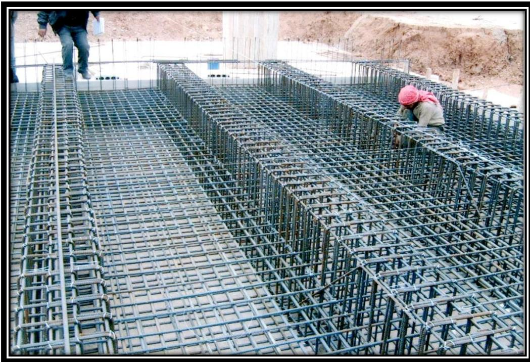
Foto 16: Estructura de fierro de la base del Transformador de Potencia e Inductor de Puesta a Tierra.
