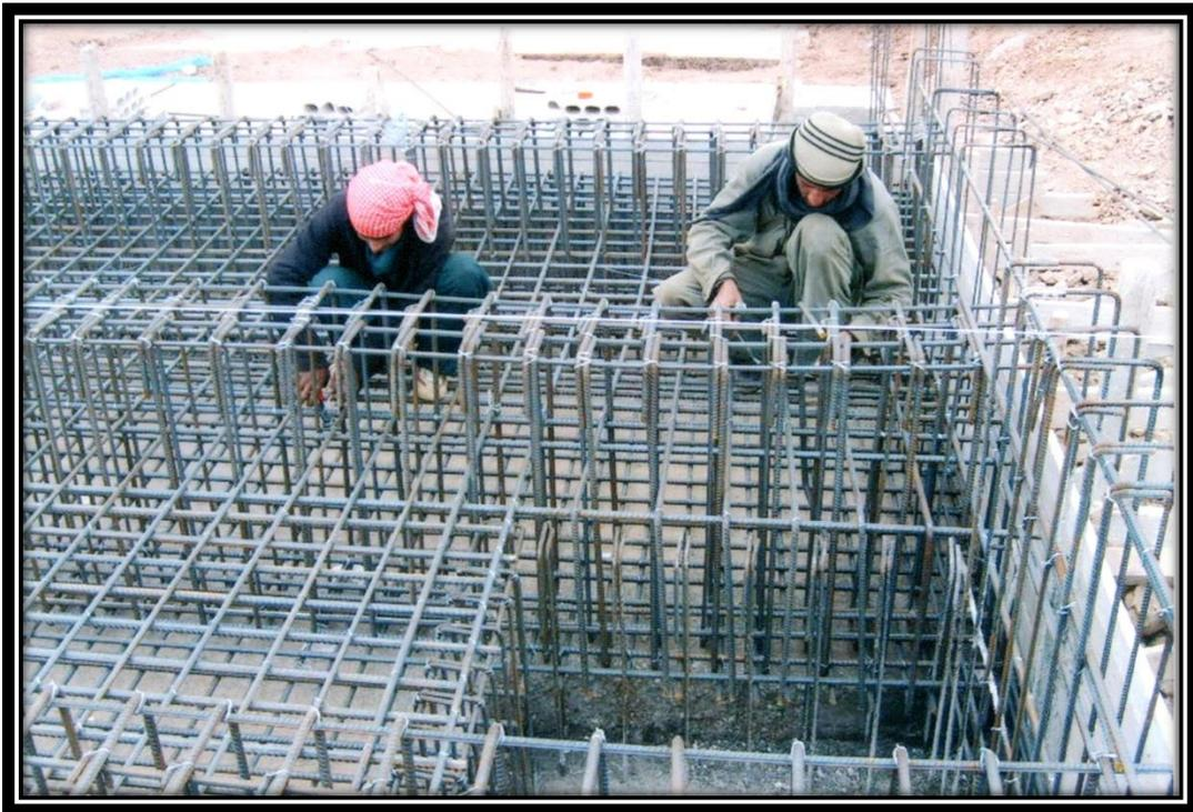
Foto 18: Estructura de fierro de la base del Transformador de Corriente.
