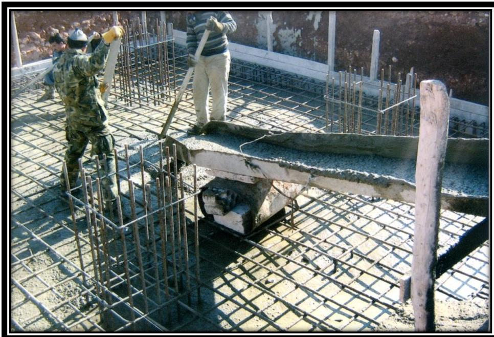
Foto 25: Vaciado de concreto del piso y zapatas del Edificio de Control; zona de Banco de Condensadores.
