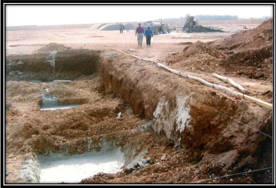
Foto 15: Zona del Seccionador y Pararrayos. Excavación y Solado.
