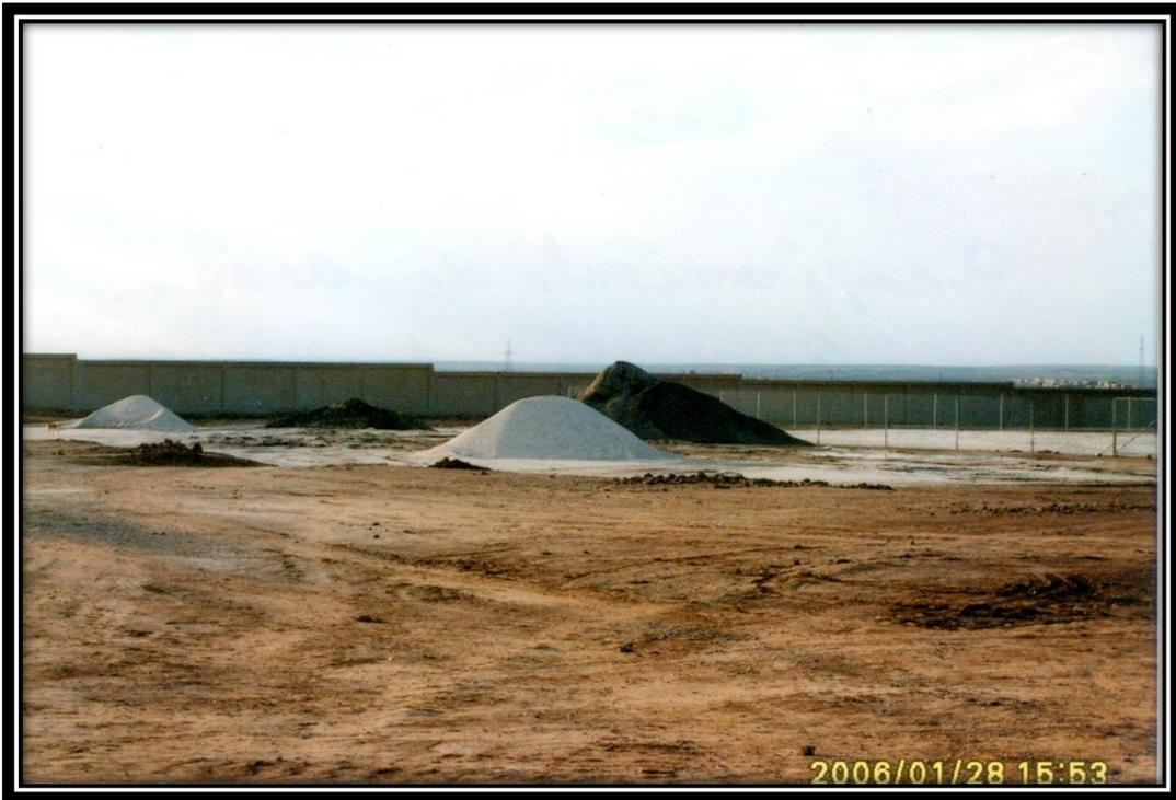
Foto 23: Acopiamiento de arena y grava para el concreto de las fundaciones.
