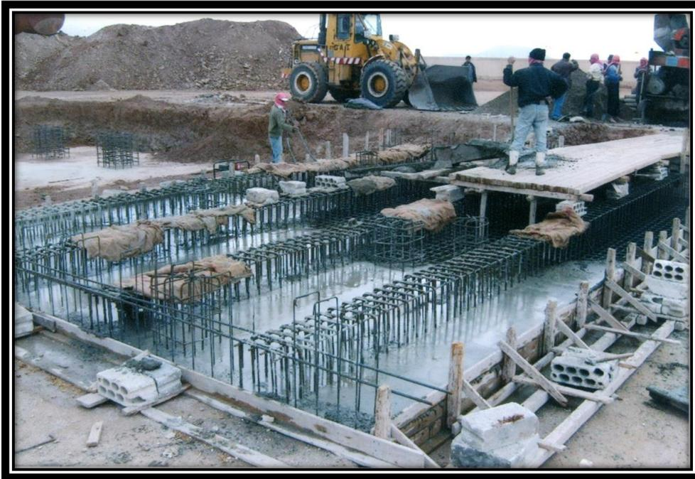
Foto 29: Vaciado de concreto del Edificio de Control.
