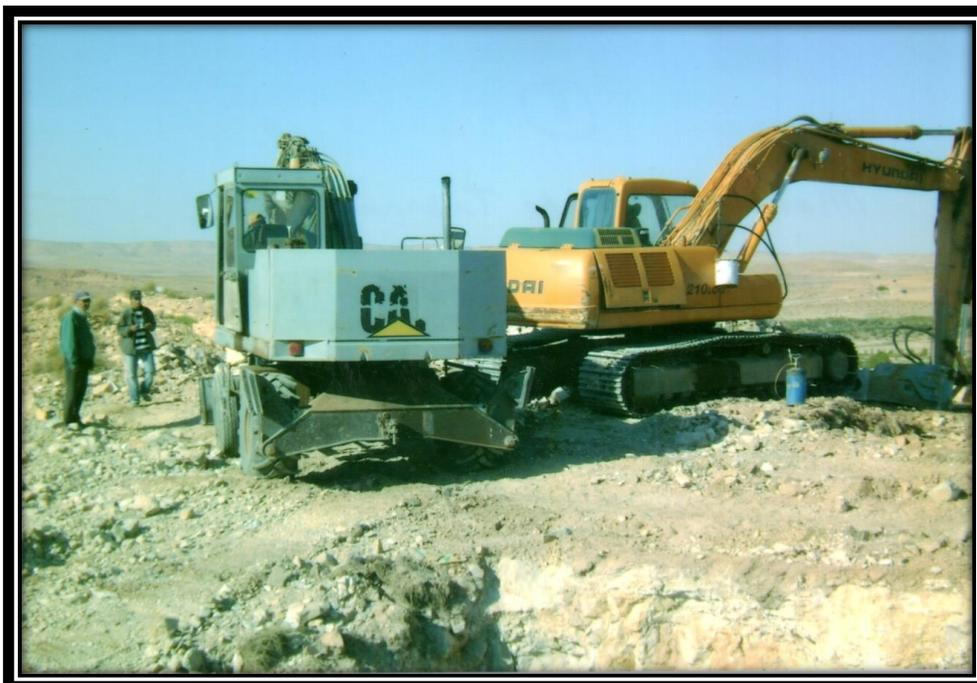
Foto 6: Movimiento de tierra masiva. Equipo de excavación roca suelta.
