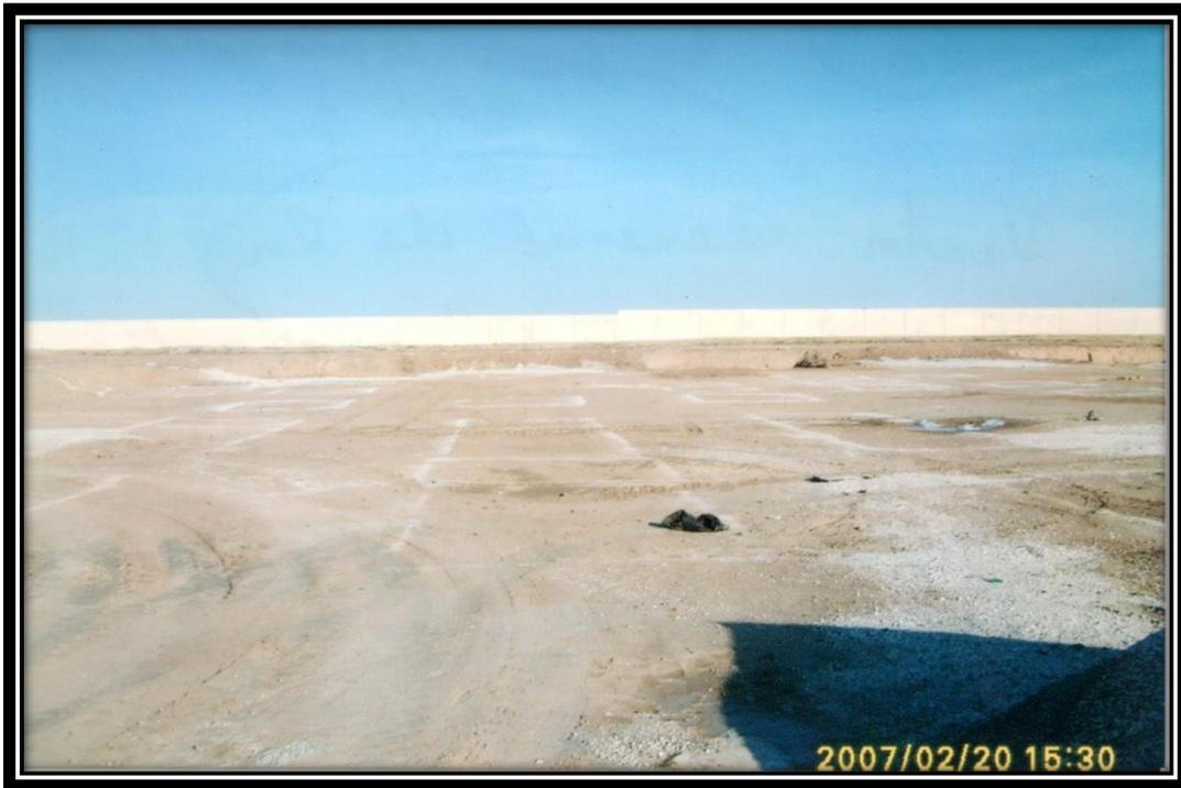
Foto 9: Vista general de la Subestación de Aleppo explanada al 100% antes de iniciarse las excavaciones de las bases de los equipos. Nótese, al fondo, el cerco de ladrillos y el trazo con yeso de las fundaciones a excavar.
