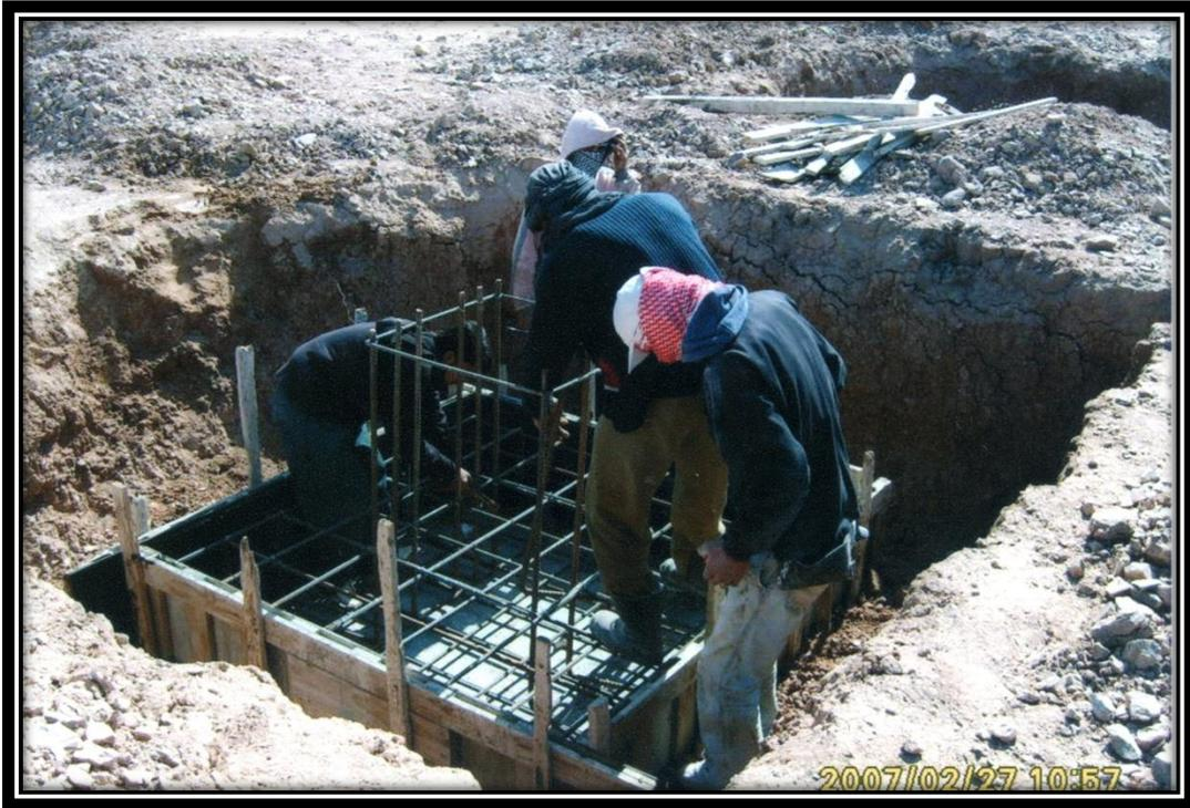
Foto 20: Estructura de fierro del Pórtico principal de la Subestación.
