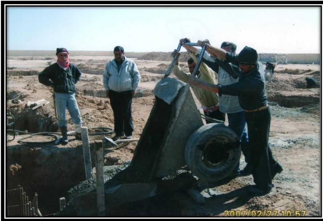
Foto 26: Vaciado de concreto de la Base del Pararrayos Principal.
