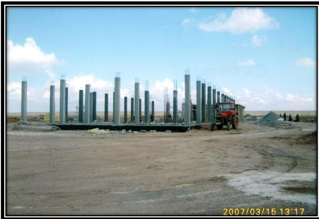
Foto 36: Columnas de concreto armado del Edificio de Control.
