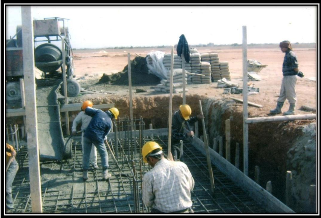
Foto 27: Vaciado de concreto de la base del Interruptor de Potencia.
