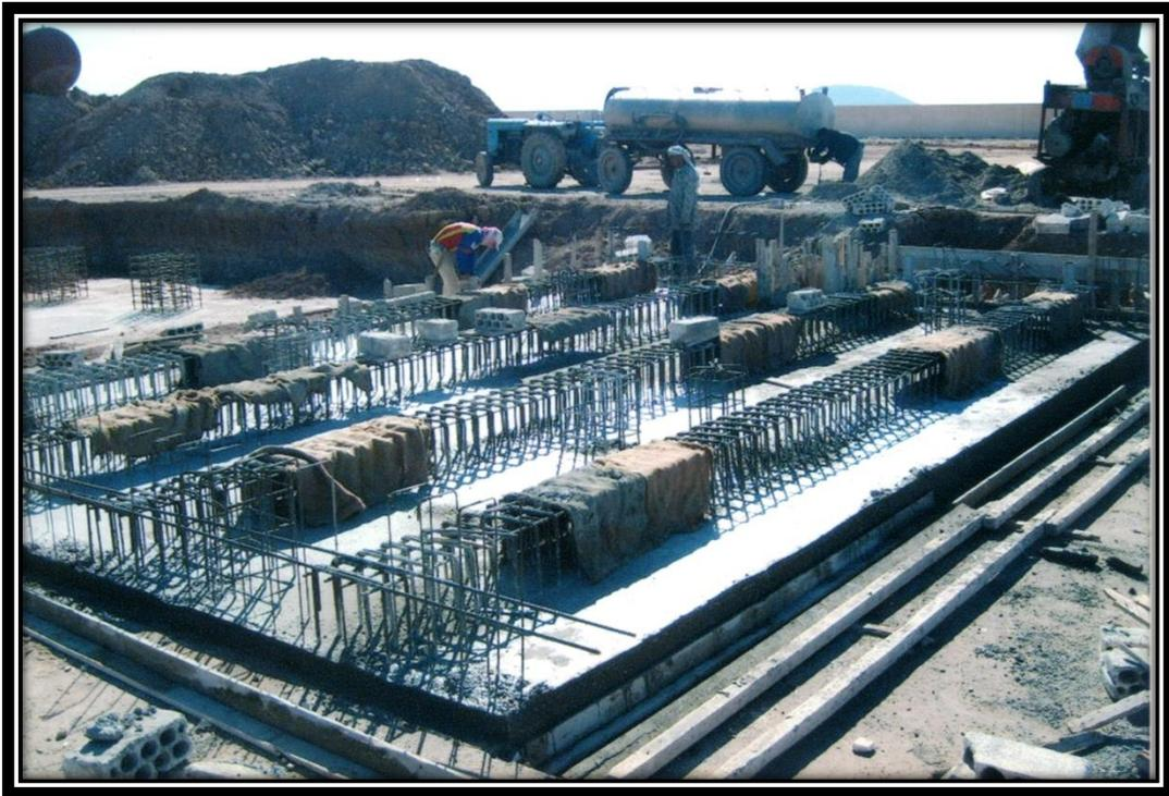
Foto 21: Estructura de fierro del Edificio de Control. Sala de Baterías.
