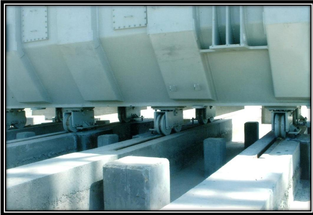
Foto 37: Base del Transformador de Potencia ya instalado con rieles.
