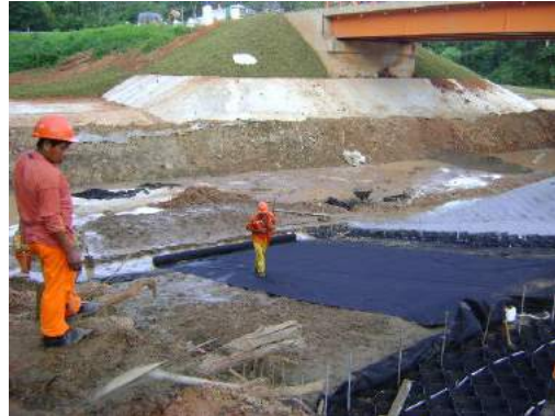
Tendido de geotextil
