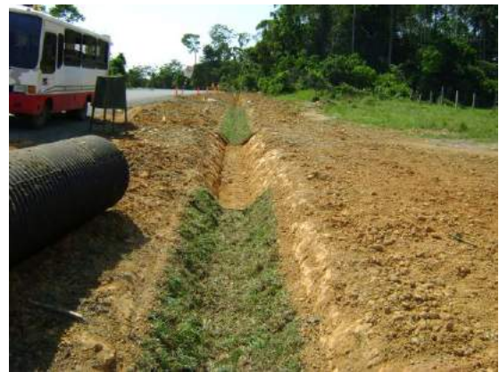
Sembrío de césped en taludes de cunetas triangulares de concreto
