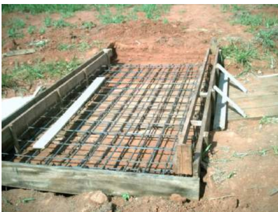
Encofrado de pase peatonal
