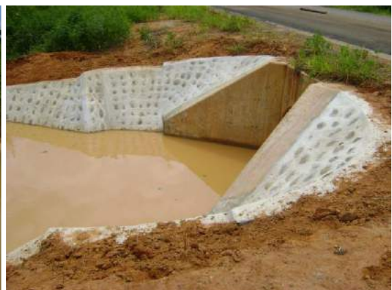
Algunos encausamiento se vuelven a inundar encausando sin embargo las aguas hacia la alcantarilla
