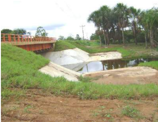
Césped en talud de defensa ribereña Puente San Francisco
