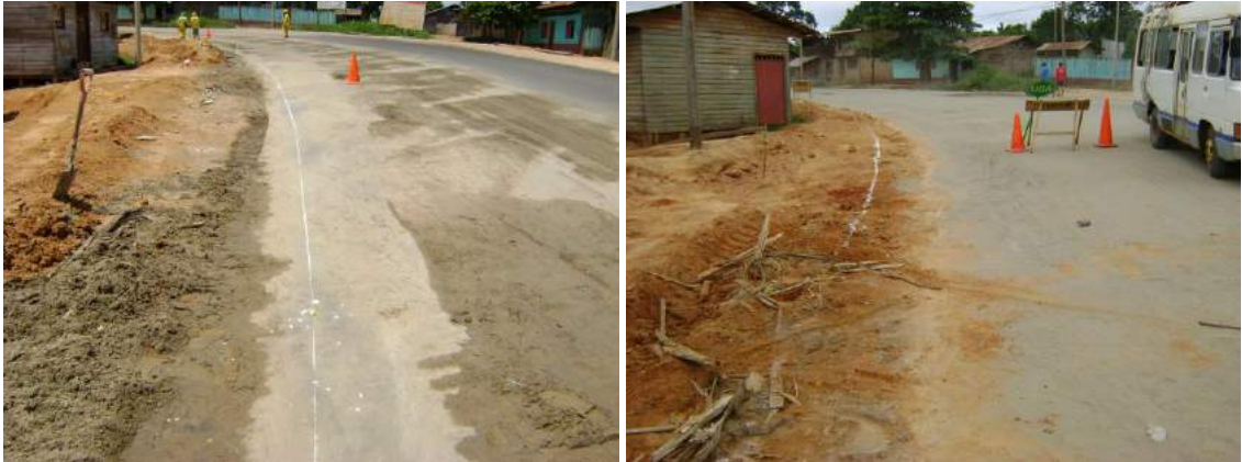
Trazo de cuneta urbana sobre pavimento a ser cortado
