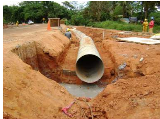
Zapata de cabezal vacuada
