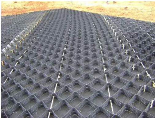
Tensores amarrados en las estacas de anclaje
