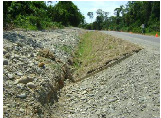
Perfilamiento de cunetas triangulares (desarrollo L=2.70\text{m} )
