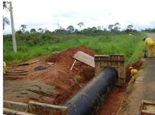
Tendido de TMC sobre cama de arena 0.30m de espesor
