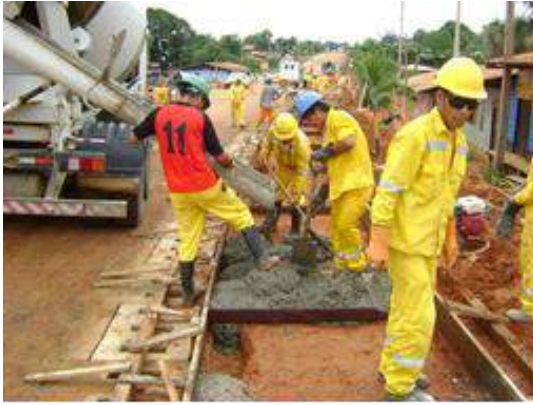
Vaciado de concreto en veredas
