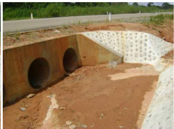
Encausamientos Terminados.- la función para las que han sido construidas es captar las aguas que van hacia las alcantarillas
