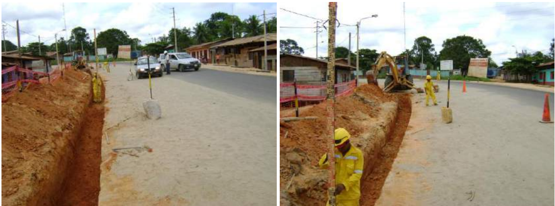
Verificación de alturas con el nivel topográfico
