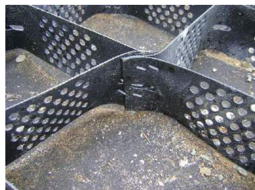
Secciones de geo web unida con grapas
