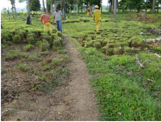
Extracción de placas de césped
