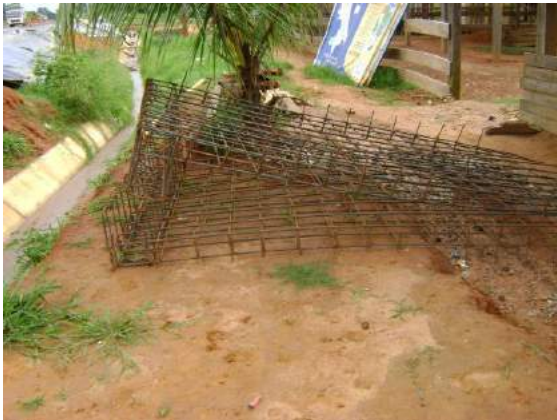
Armadura de acero para pases peatonales
