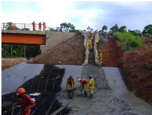
Extendido y frotachado del mortero
