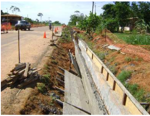
Muros Desencofrados
