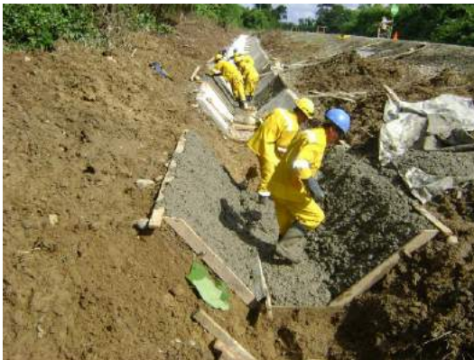
Vaciado de concreto en paños intercalados
