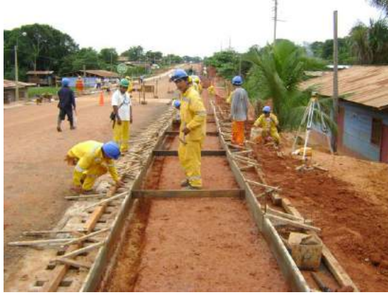
Fijación de las tablas en los durmientes
