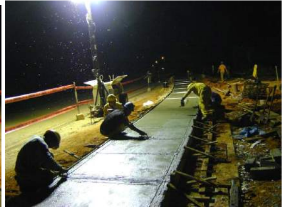
Frotachado y acabado de veredas, en el cual se usa luminaria si es necesario
