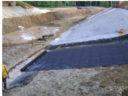
Geotextil extendido
