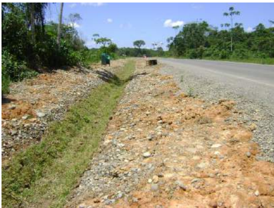
Sembrío de césped en zanjas terraplén
