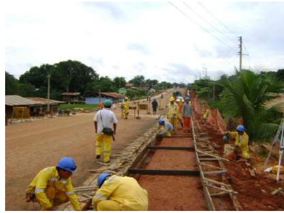
Fijación de las tablas en los durmientes
