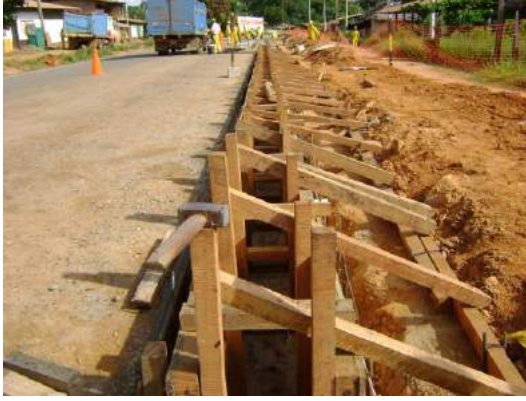
Muros Encofrados
