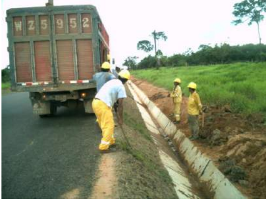
Sembrío de césped en taludes de cunetas triangulares de concreto
