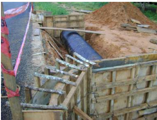
Encofrado de cabezal
