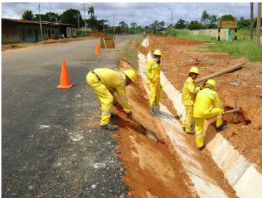
Perfilado de cuneta de concreto (desarrollo L=1.10\text{m} )
