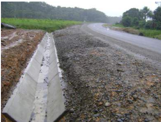
Cunetas llenadas de concreto
