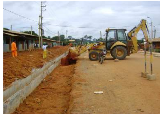
Relleno con material seleccionado
