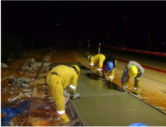
Frotachado y acabado de veredas, en el cual se usa luminaria si es necesario
