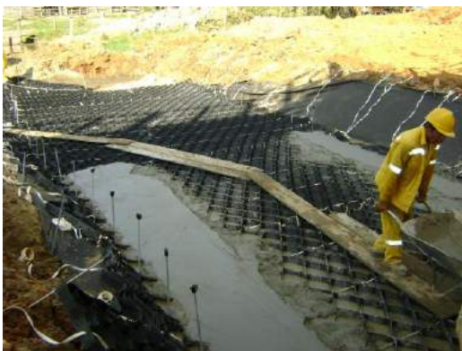
Vaciado de mortero f'c=210\text{kg/cm}^2
