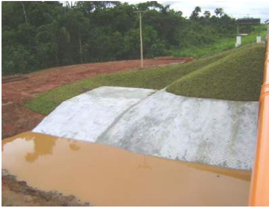
Césped en talud de defensa ribereña Puente Pampa Hermosa
