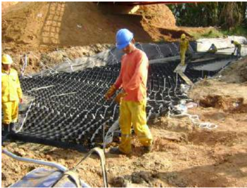
Tendido de geoweb
