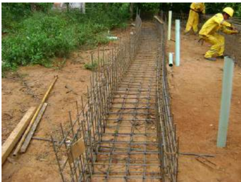
Habilitado de acero para losa y muros (canastillas)
