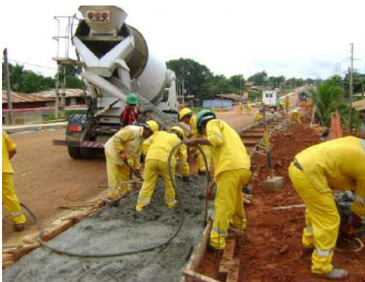
Vibrado de la mezcla y reglado
