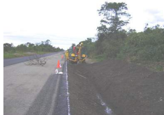
Excavación de zanjas para cunetas revestidas de césped
