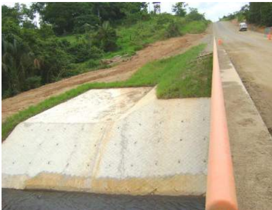
Césped en talud de defensa ribereña Puente Loboyoc
