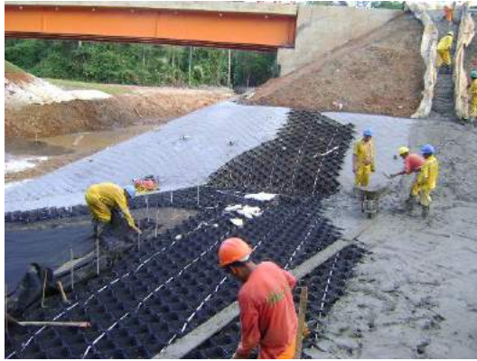
Vaciado de mortero
