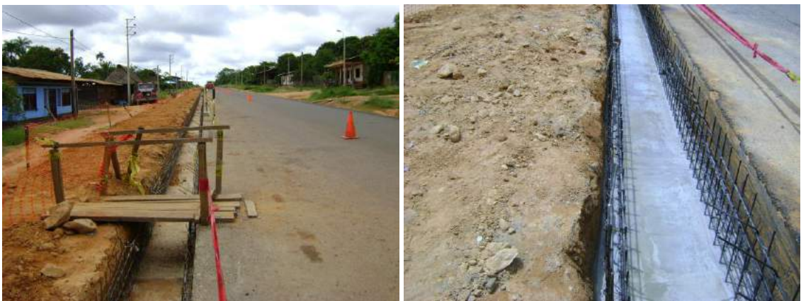
Losas vaciadas de concreto
