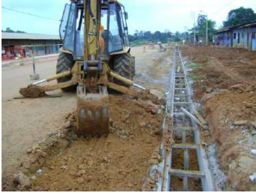
Excavación hasta conseguir suelo firme
