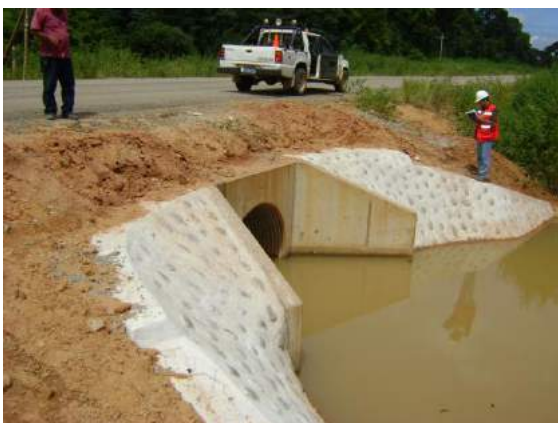
Algunos encausamiento se vuelven a inundar encausando sin embargo las aguas hacia la alcantarilla
