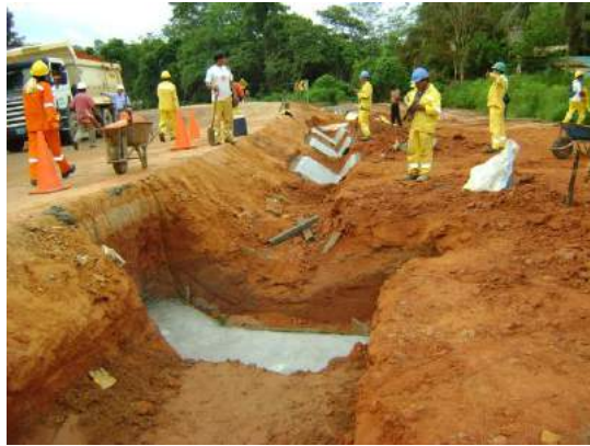
Zapata de cabezal vacuada
