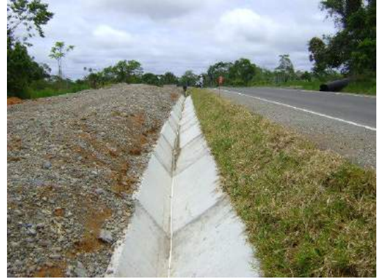
Sembrío de césped en taludes de cunetas triangulares de concreto
