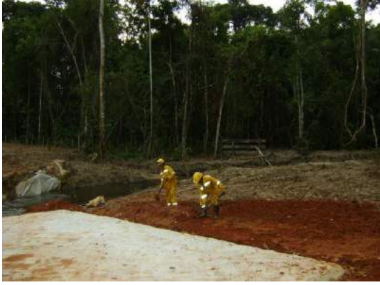
Primeramente el área es limpiada y perfilada Luego se siembra el césped
