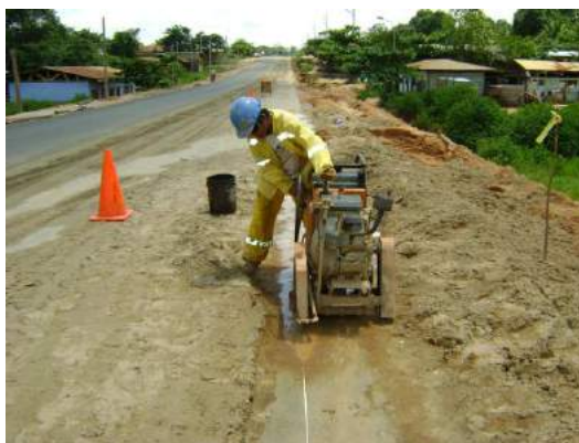
Corte del pavimento
