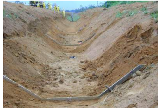
Perfilamiento de canal trapezoidal (desarrollo L=2.80\text{m} )
