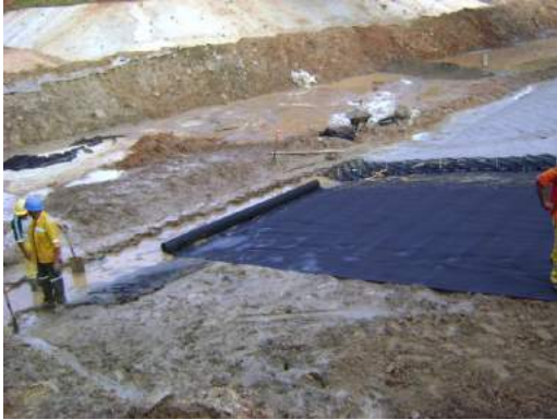
Tendido de geotextil no tejido
