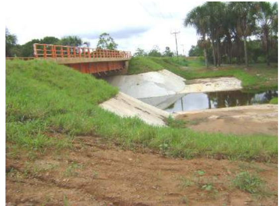
Césped en talud de defensa ribereña Puente San Francisco
