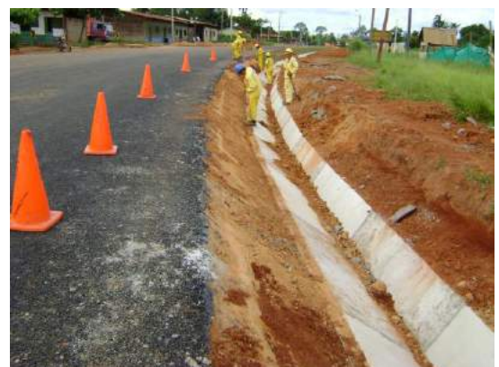
Perfilamiento de cunetas triangulares (desarrollo L=2.70\text{m} )
