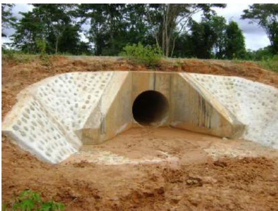
Encausamientos Terminados.- la función para las que han sido construidas es captar las aguas que van hacia las alcantarillas
