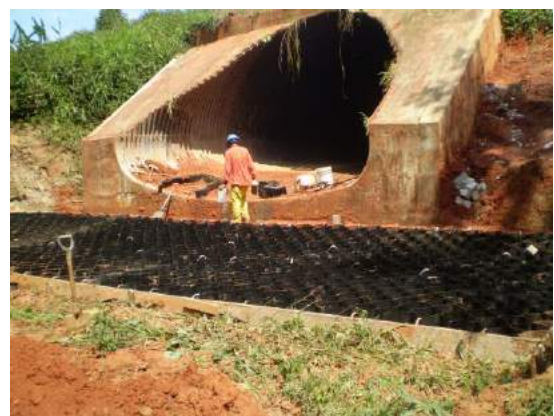
Extendido de la malla geoweb, ancladas con los bastones
