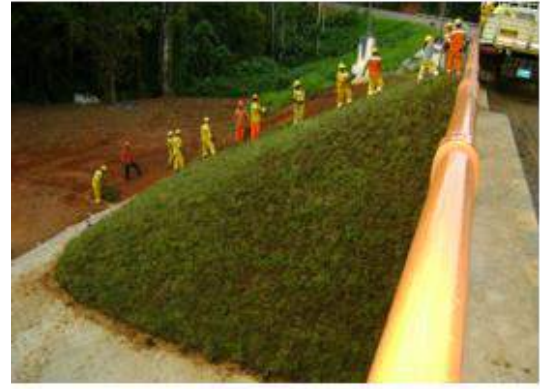
Primeramente el área es limpiada y perfilada Luego se siembra el césped
