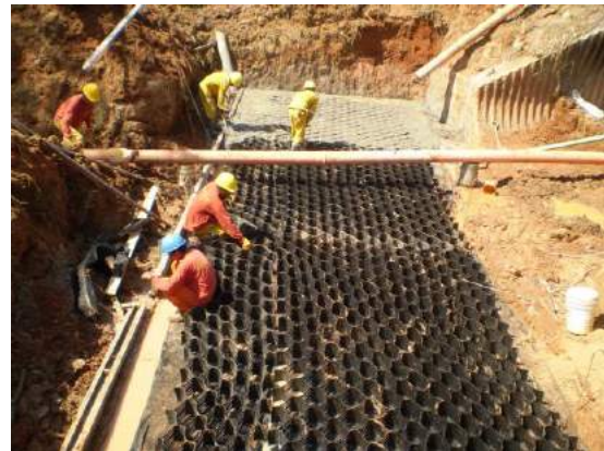
Extendido de la malla geoweb, ancladas con los bastones
