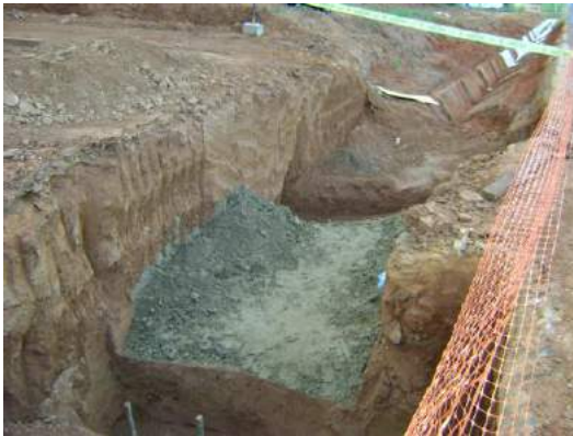
Excavación para construcción de pase vehicular
