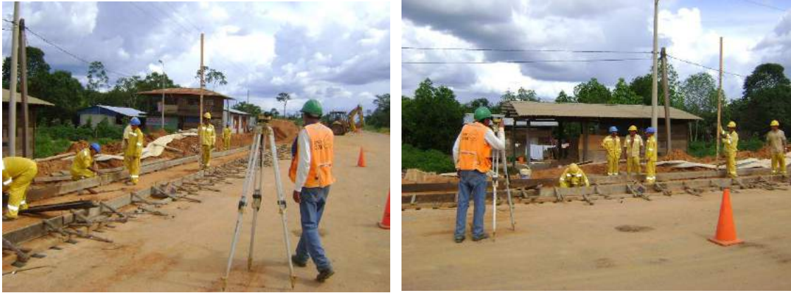
Colocado de niveles
