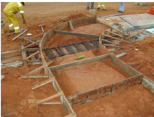
Encofrado de veredas
