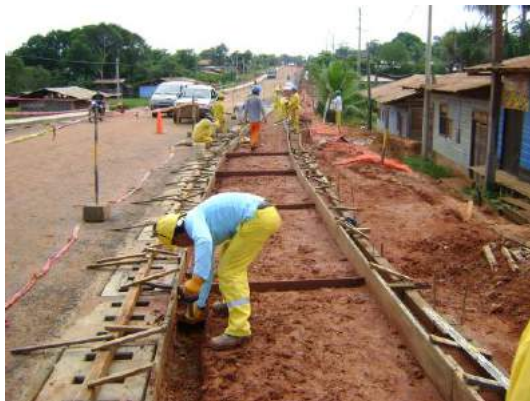
Excavación de uñas
