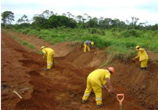
Perfilamiento de canal trapezoidal (desarrollo L=2.80\text{m} )
