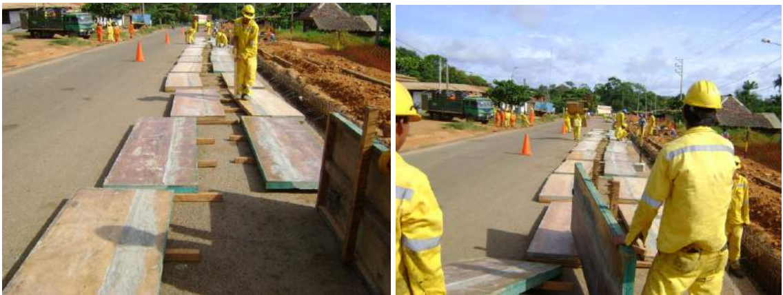
Paneles preparados para el encofrado
