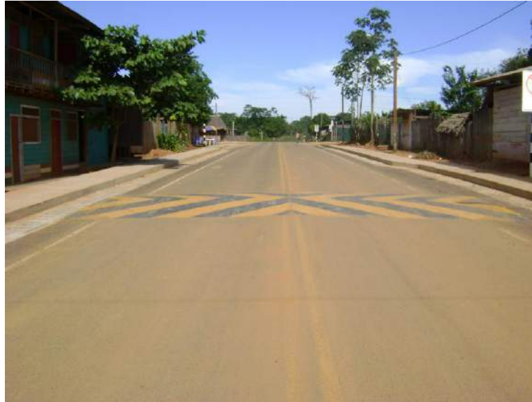
Cuneta Urbana Localidad de Panchón
