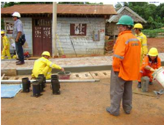
Se saca muestras del concreto para realizar los ensayos de rotura
