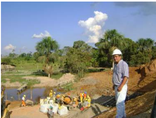
Preparado del mortero f'c=210\text{kg/cm}^2
