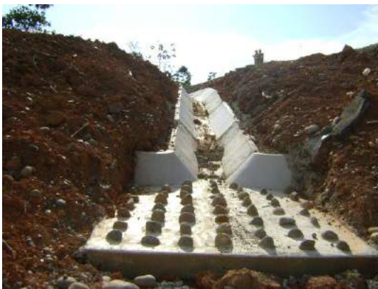
Dispositivo en salida de cunetas
