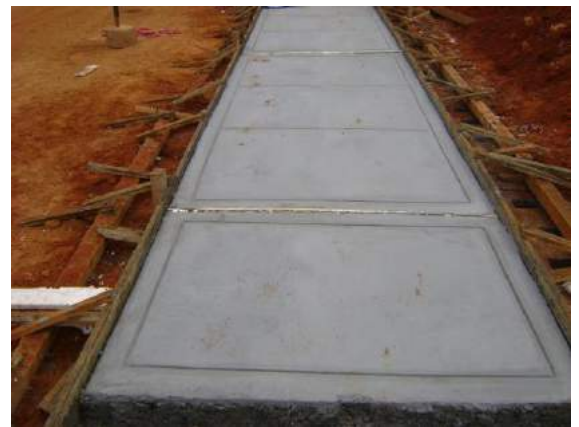
Frotachado y acabado de veredas, en el cual se usa luminaria si es necesario
