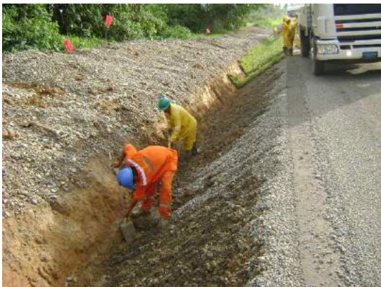
Perfilamiento de cunetas triangulares (desarrollo L=2.70\text{m} )
