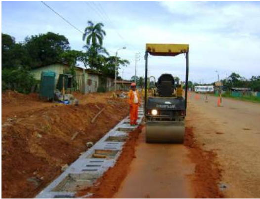
Compactación de la base
