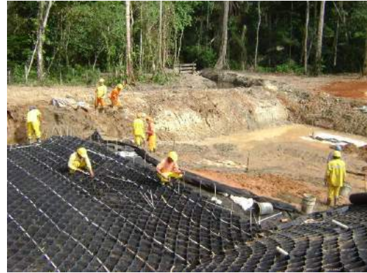
Tendido del Geoweb
