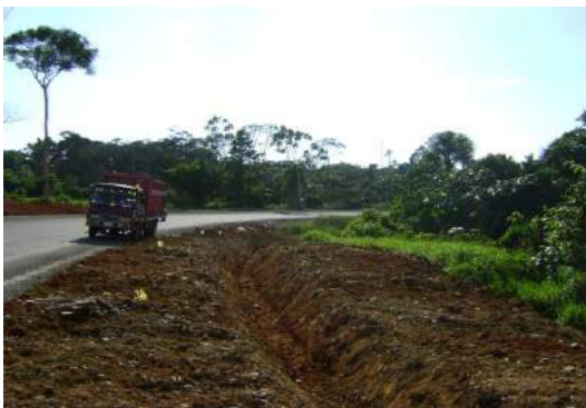
Excavación de zanjas para cunetas revestidas de césped
