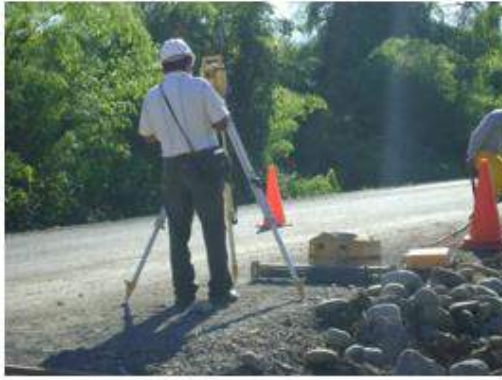
Replanteo de los ejes y alturas de nivel
