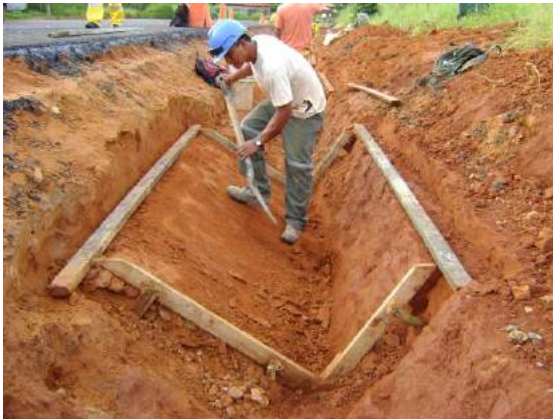
Personal Perfilando y Cerchando
