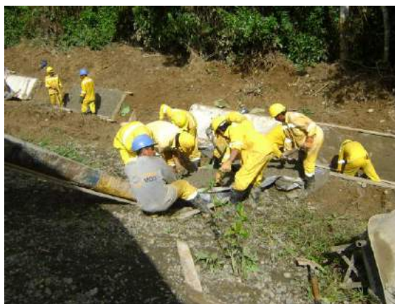
Vaciado de concreto en cunetas
