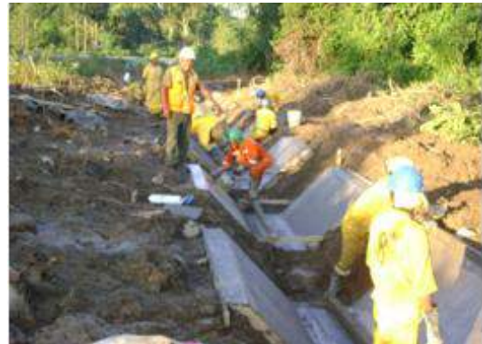
Utilizando un chute para el vaciado
