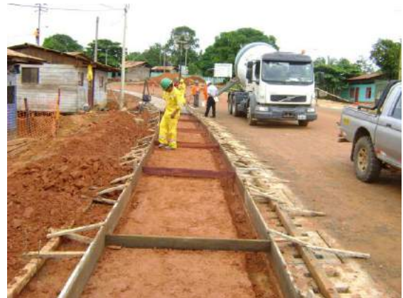
Verificación del estado del encofrado
