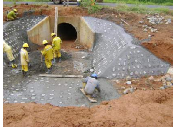
Colocado de piedras y acabado.- Una vez colocado el concreto se colocan las piedras previamente lavadas
