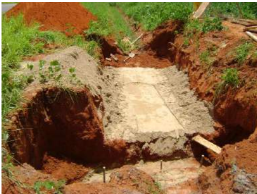
Tendido de TMC sobre cama de arena 0.30m de espesor
