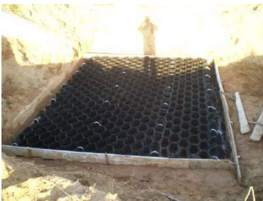
El geoweb queda extendido en el área a construir la losa
