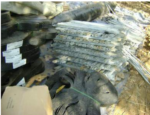
Estacas de anclaje
