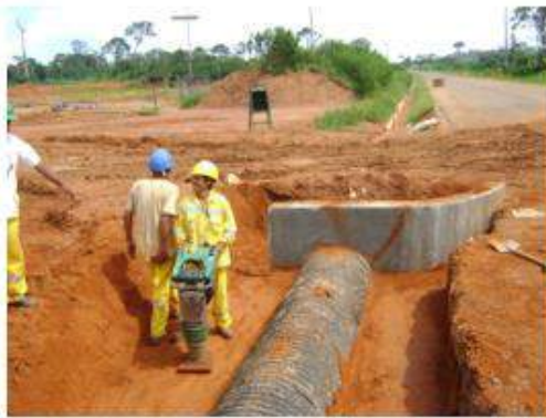
Relleno de pase vehicular en capas de 20cm.
