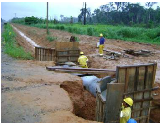
Desencofrado de cabezales
