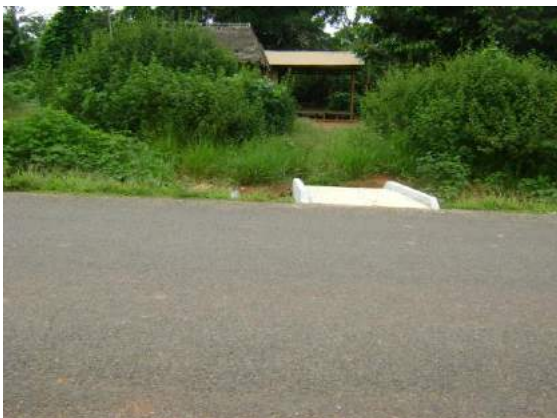
Pase peatonal construido
