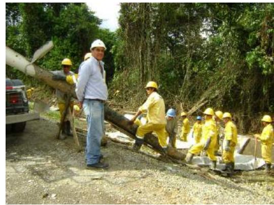
Utilizando un chute para el vaciado
