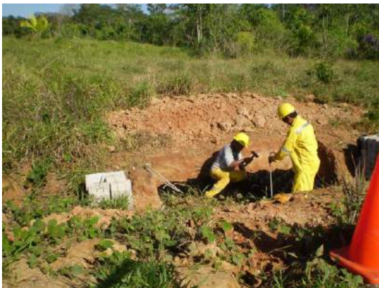
Extendido de la malla geoweb, ancladas con los bastones
