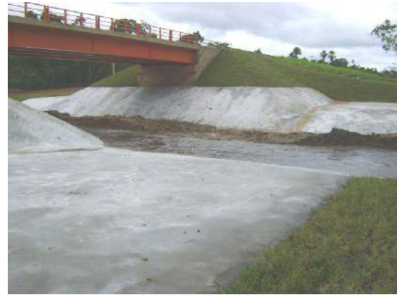
Césped en talud de defensa ribereña Puente Pampa Hermosa
