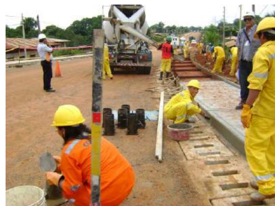
Se saca muestras del concreto para realizar los ensayos de rotura
