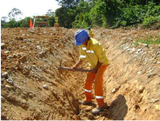
Perfilamiento de zanja terraplén (desarrollo L=1.56\text{m} )
