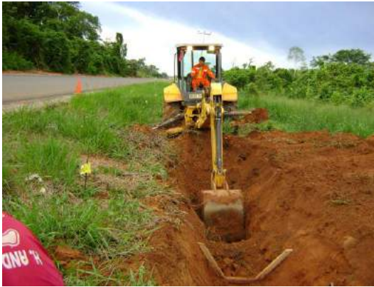
Excavación de zanjas para cunetas
