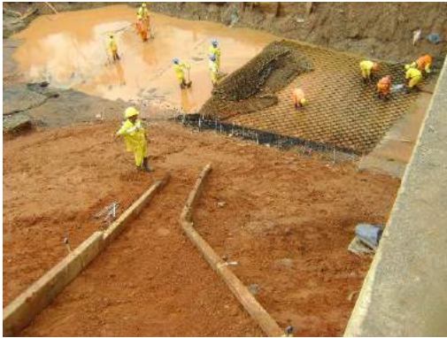
Chute acondicionada para el vaciado de mortero
