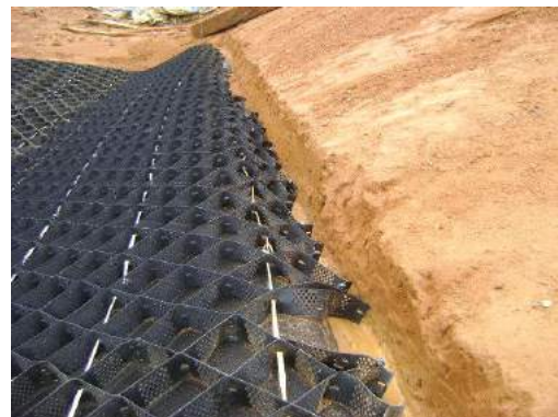
Tendido del Geoweb
