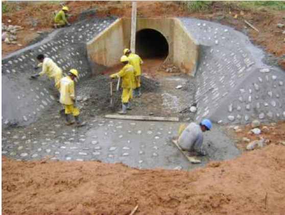
Colocado de piedras y acabado.- Una vez colocado el concreto se colocan las piedras previamente lavadas
