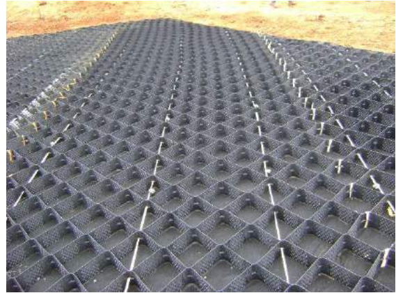
Geoweb extendido
