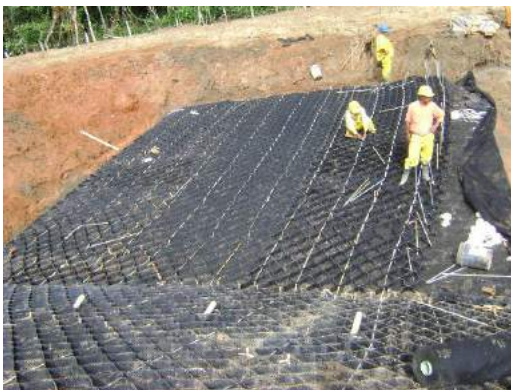
Tendido de geotextil no tejido
