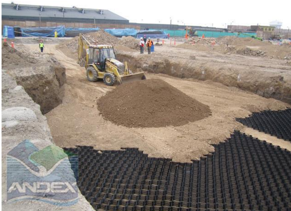
Figura 44. Implementación de geoweb. Andex del Norte.
