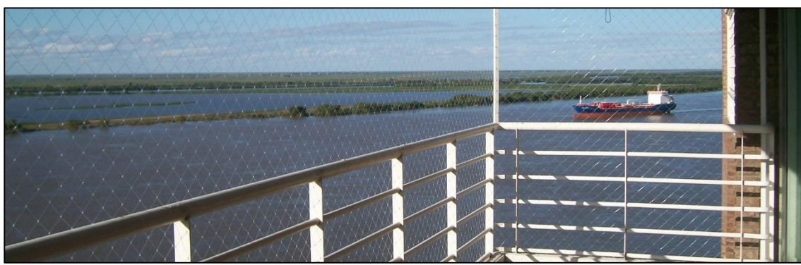
Figura 43. Ejemplo de malla anticaída colocada en un balcón frente a un río.
