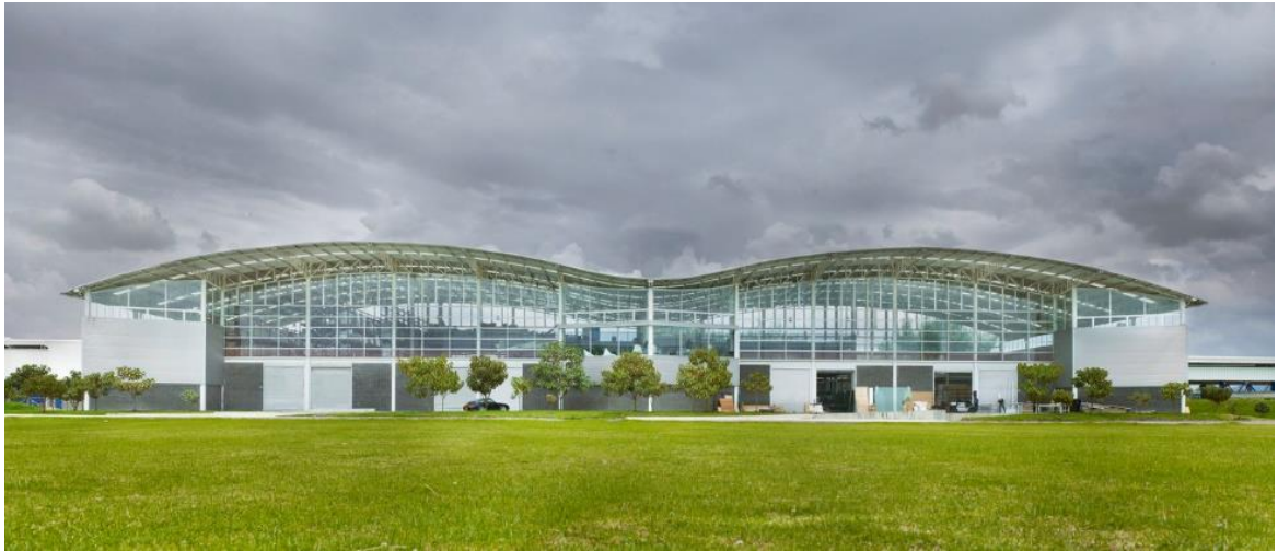
Ilustración 4. Fachada principal de la fabrica Atek. Fuente: https://www.archdaily.pe [Recuperado 20 07.2018]
