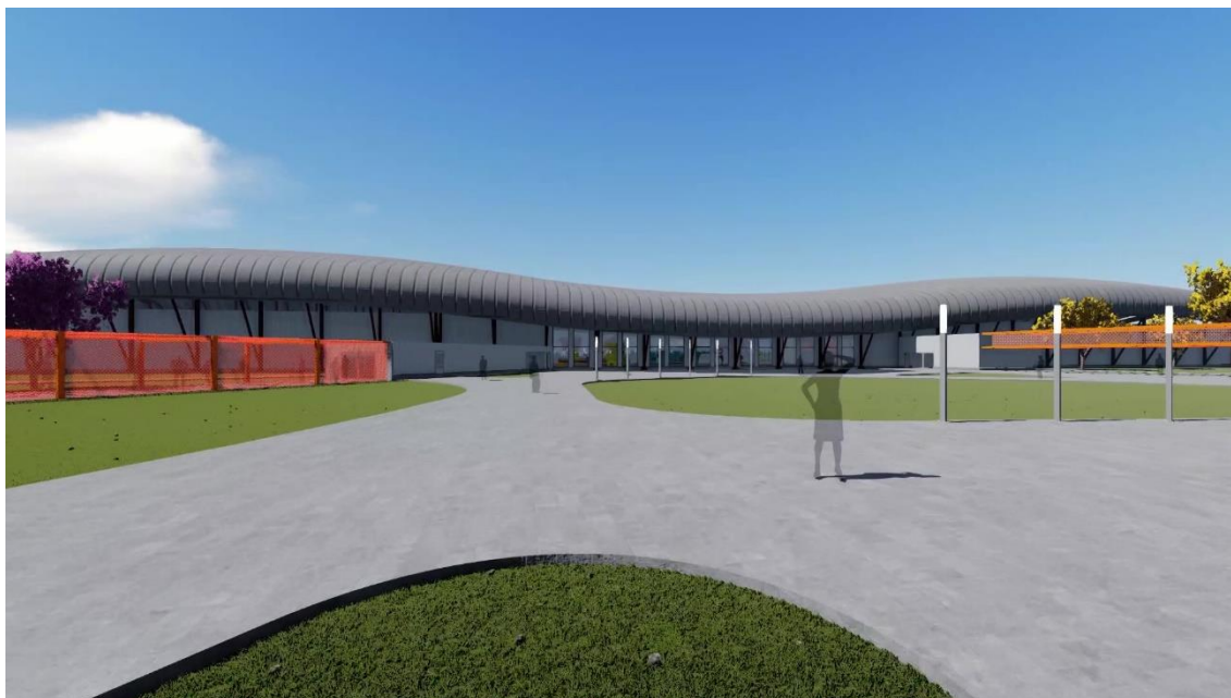
Ilustración 47. Vista frontal 1 de la Planta Empacadora.
