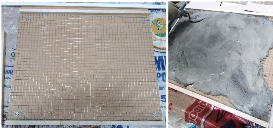
Figura 30. Tarrajeo de paneles de 1.5 cm de espesor
