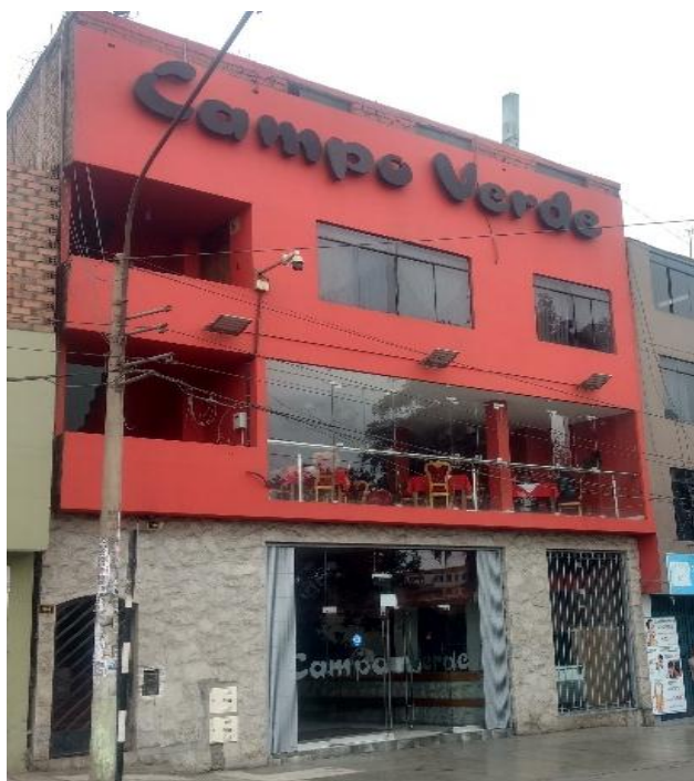
Fotografía 1. Fachada del Restaurante Parrillas Campo Verde. Elaboración Propia
