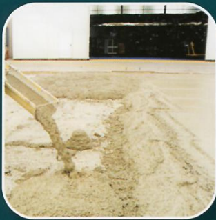
Pisos y pavimentos
