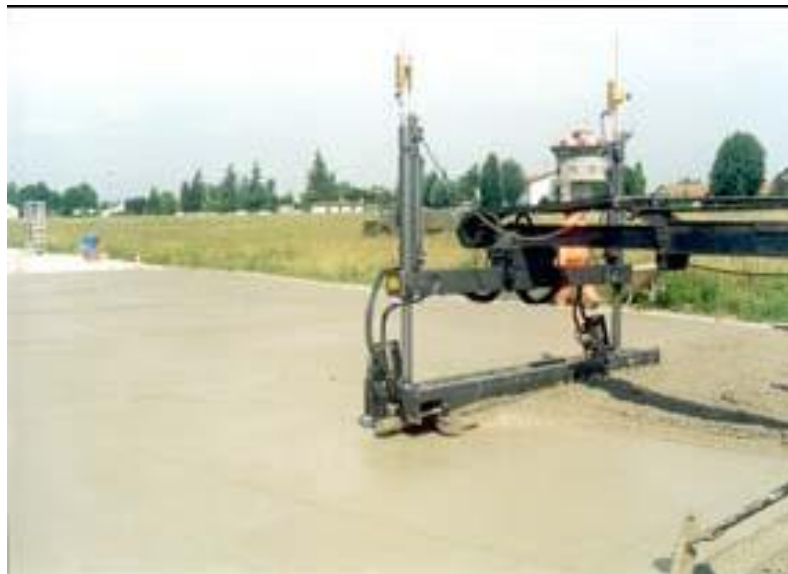
Nivelación de la pavimentación c / Fibra de Acero c / una máquina niveladora láser.
