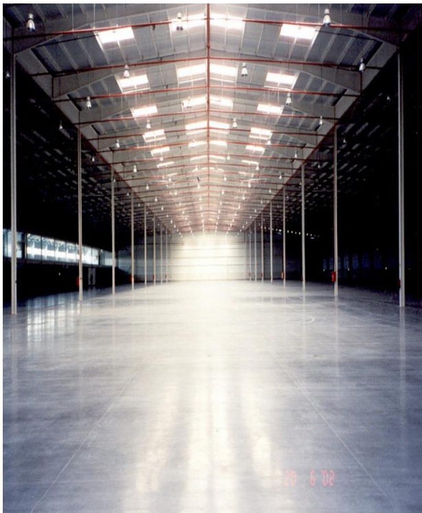
Pisos industriales reforzados con Fibra de Acero.
