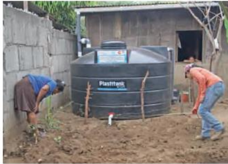
IMAGEN N°21: Instalación de tanques para la captación de agua de lluvia. FUENTE: FAO / 21-03-2017
