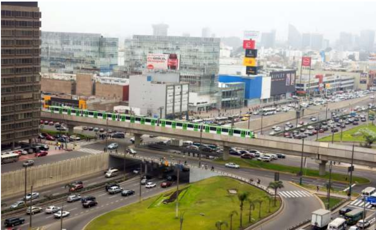
FIGURA N° 50: METRO DE LIMA LINEA 1, ATRAVESANDO AV. JAVIER PRADO ESTE
